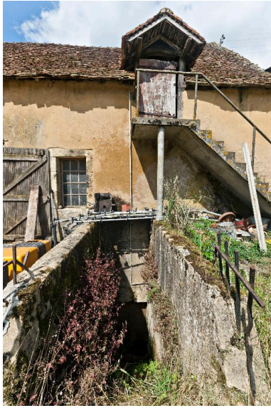
Escalier du cellier. Phot. Yves Guillotin IVR52_20147201849NUCA
