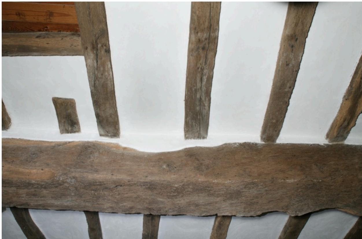
Détail poutre et solive du rez-de-chaussée.
