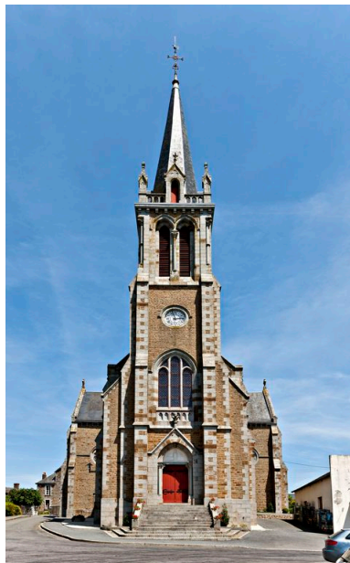
Vue d'ensemble. Phot. Yves Guillotin IVR52_20155300147NUCA
