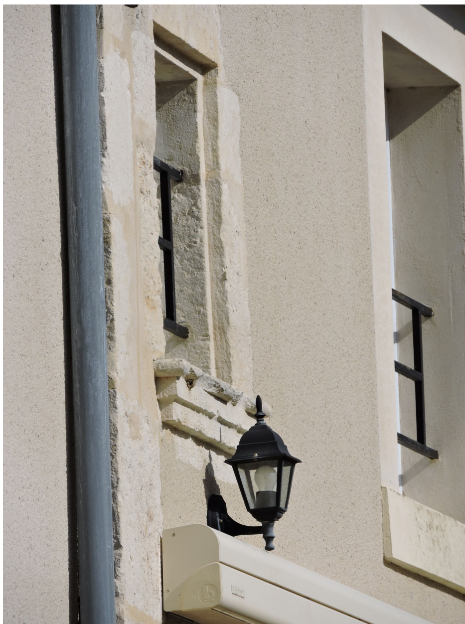
La baie avec appui mouluré observée sur le corps de bâtiment est, côté sud.
