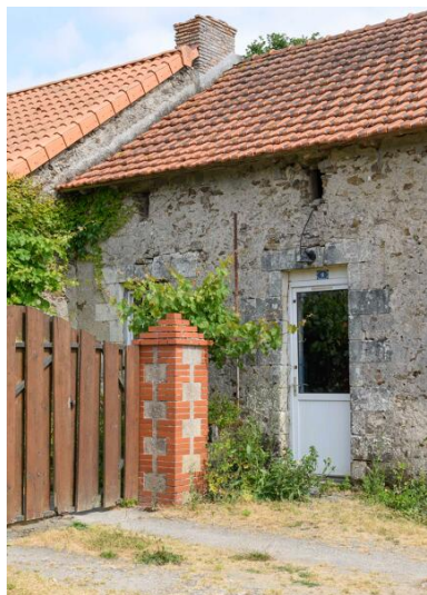
Détail d'ouvertures en pierre de taille de tuffeau (RDC) et moellons de schiste (CS) d'un des logis du Plessis Pasquier.
