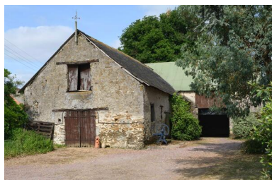
Vue des façades principales de la grange du Plessis-aux-Boeufs. Phot. Armelle Maugin IVR52_20254900641NUCA
