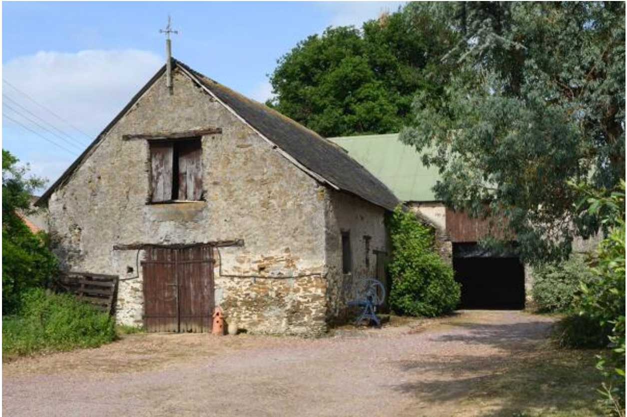
Vue des façades principales de la grange du Plessis-aux-Boeufs.
