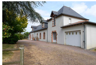
Vue d'ensemble du logis du Plessis-aux-Boeufs (ferme n° 11). Phot. Armelle Maugin IVR52_20254900648NUCA
