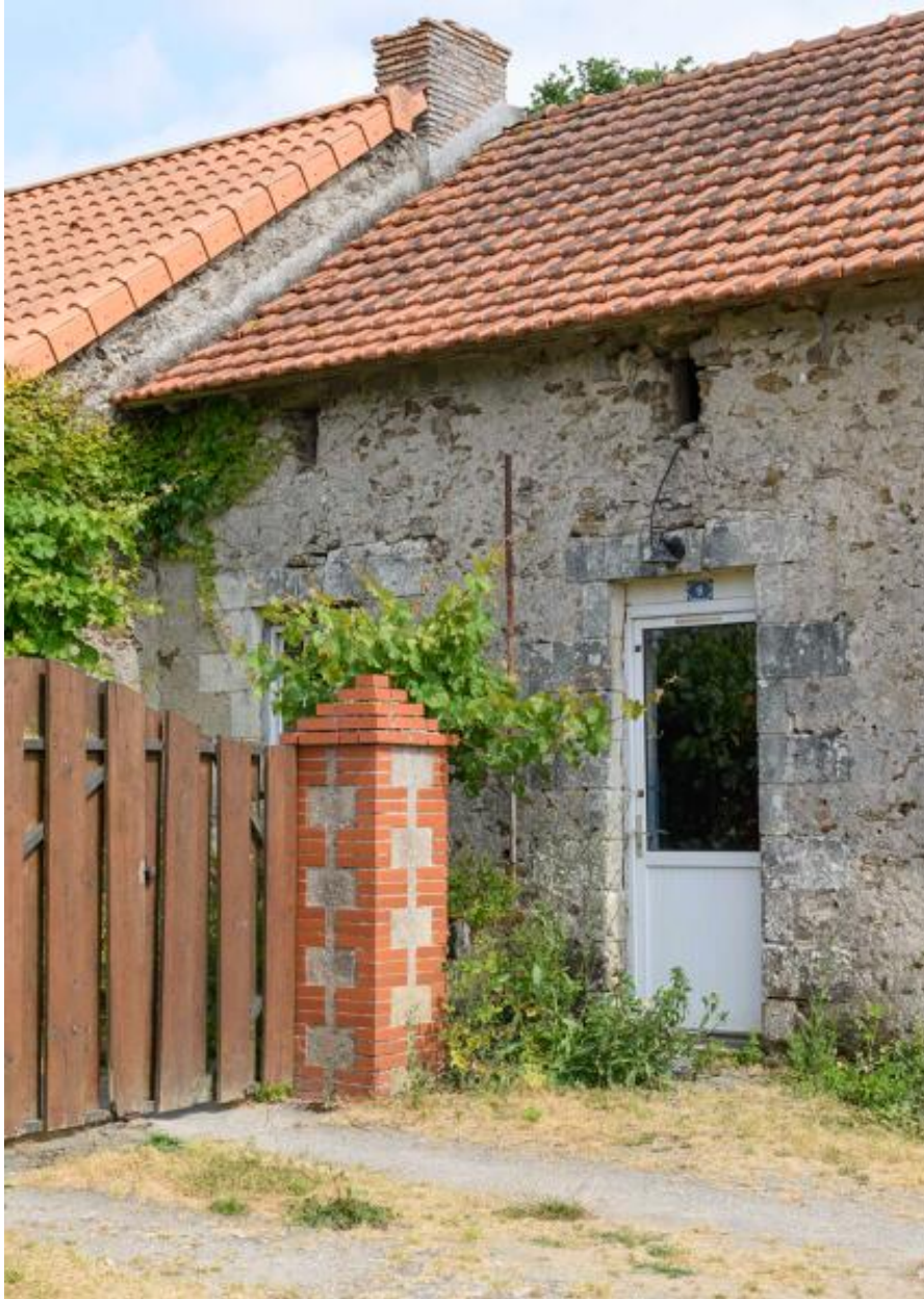
Détail d'ouvertures en pierre de taille de tuffeau (RDC) et moellons de schiste (CS) d'un des logis du Plessis Pasquier.
