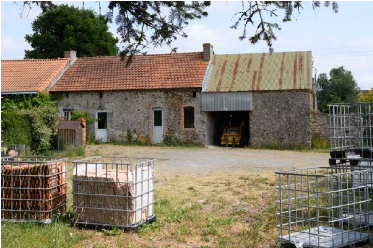
Partie est des logis du Plessis Pasquier avec grange à l'extrémité.
