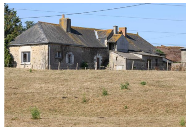
Logis de la ferme du Petit Plessis. Phot. Armelle Maugin IVR52_20254901054NUCA
