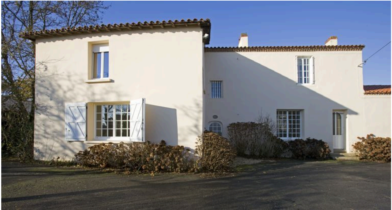
Le logis. Façade est, partie sud.
