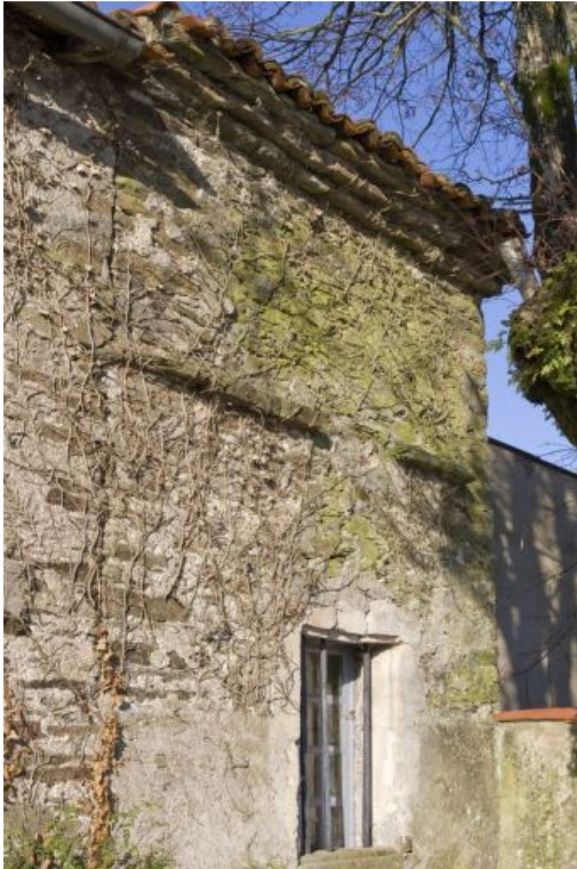
Le pigeonnier : détail des appareillages de pierres.
