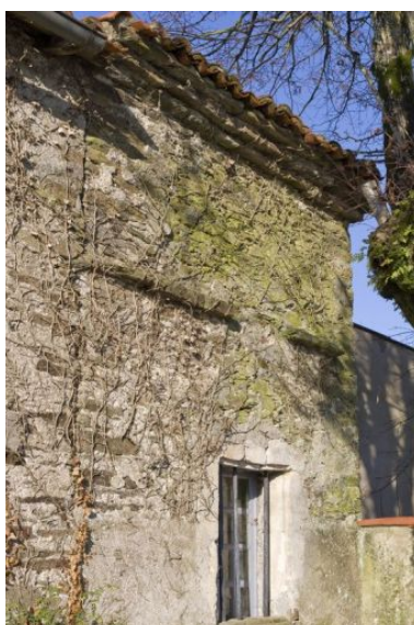
Le pigeonnier : détail des appareillages de pierres. Phot. Yves Guillotin IVR52_20104403048NUCA
