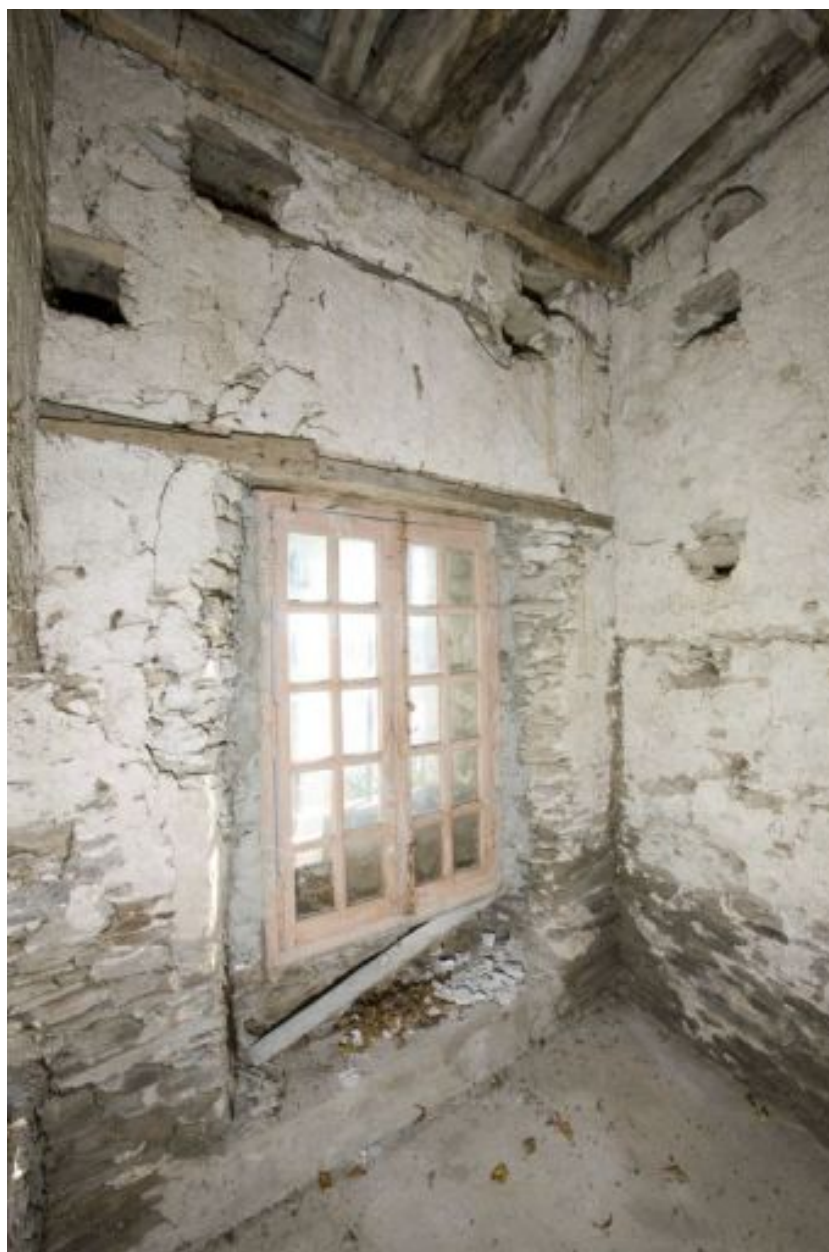
Le pigeonnier : détail de quelques trous de boulin.
