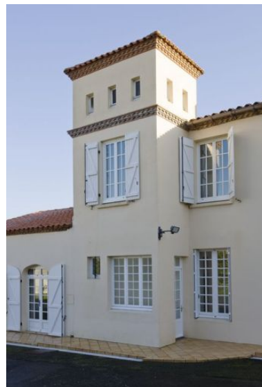
Façade ouest : la surélévation des années 1950 rappelle l'une des tours de Chasseloir. Phot. Yves Guillotin IVR52_20104403042NUCA
