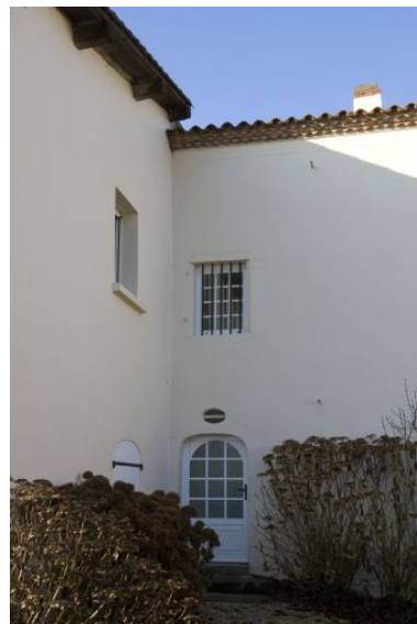
Façade est : corps de logis primitif Phot. Yves Guillotin IVR52_20104403039NUCA
