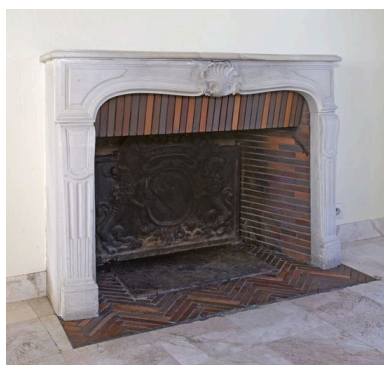
Cheminée réinstallée dans la maison sud remaniée vers 1955. Phot. Yves Guillotin IVR52_20104403032NUCA
