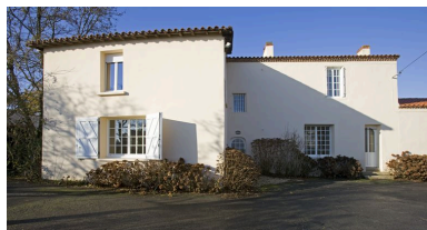
Le logis. Façade est, partie sud. Phot. Yves Guillotin IVR52_20104403038NUCA
