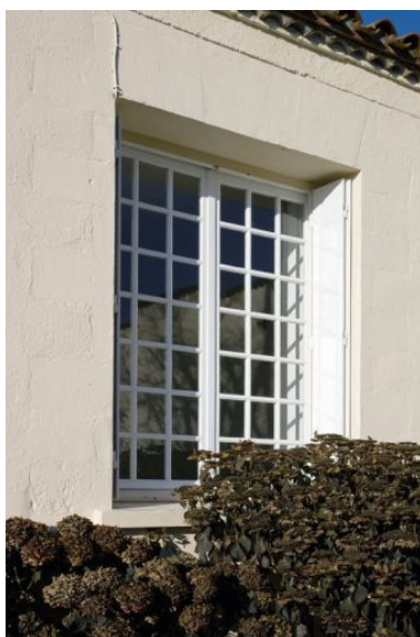
Façade est : baie à entourage de calcaire. 19e siècle. Phot. Yves Guillotin IVR52_20104403036NUCA
