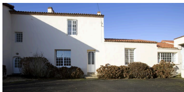
Le logis. Façade est, partie nord. Phot. Yves Guillotin IVR52_20104403035NUCA
