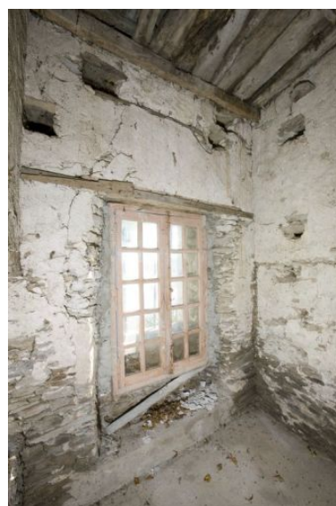
Le pigeonnier : détail de quelques trous de boulin. Phot. Yves Guillotin IVR52_20104403049NUCA
