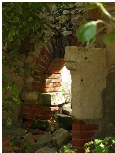
Vestiges de cheminée et de la gueule du four.
