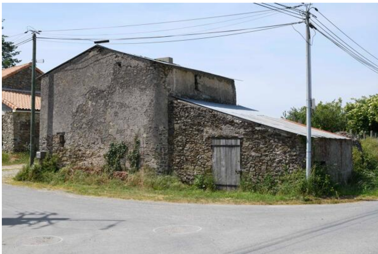
La Jolivetière. Vue de la ferme n° 2 depuis le sud-est.
