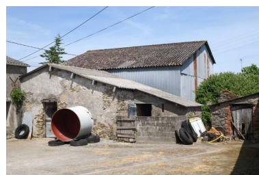
La Jolivetière. La ferme n° 3. Phot. Armelle Maugin IVR52_20254900764NUCA
