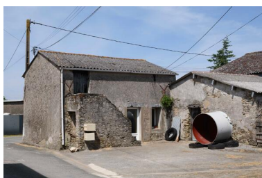
La Jolivetière. La ferme n° 3. Phot. Armelle Maugin IVR52_20254900765NUCA
