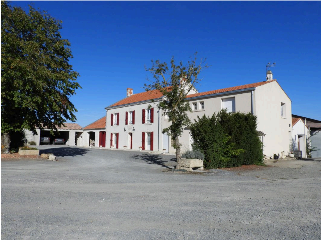
Le logis vu depuis le sud-est, encadré à gauche par une ancienne porcherie, à droite par une ancienne étable remaniée.
