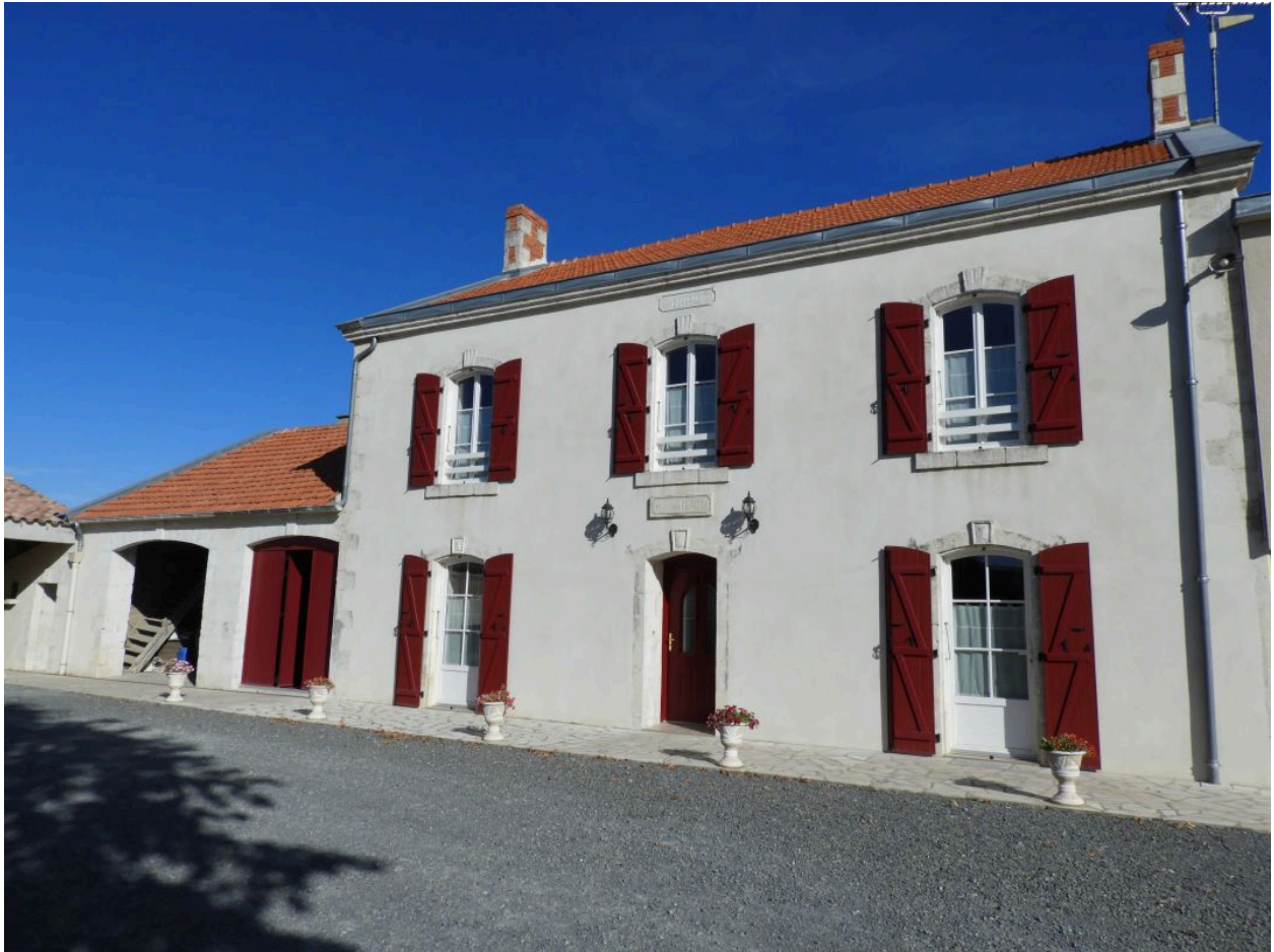
Le logis vu depuis le sud.
