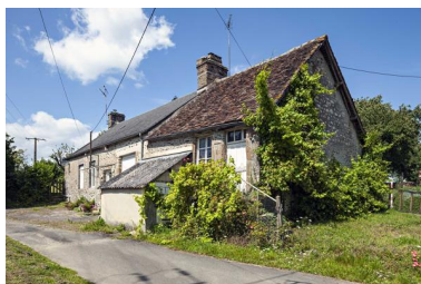
Maison, 23-25 rue des Aubépines (2023 B 423-424). Phot. Yves Guillotin IVR52_20215300904NUCA
