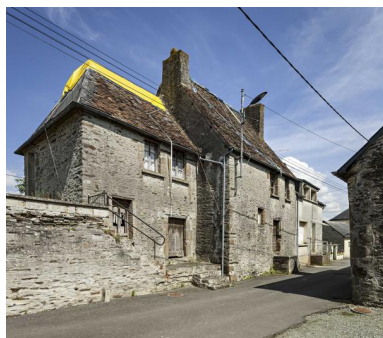
Maison, 8 bis rue des Aubépines (2023 B 403). Phot. Yves Guillotin IVR52_20215300902NUCA
