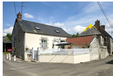
Maison, 12 rue des Aubépines (2023 ZB 410). Phot. Yves Guillotin IVR52_20215300903NUCA
