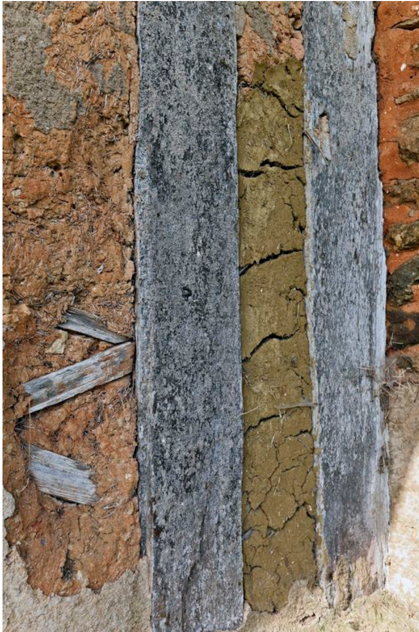
Elévation postérieure : détail de la mise en oeuvre du pan-de-bois.
