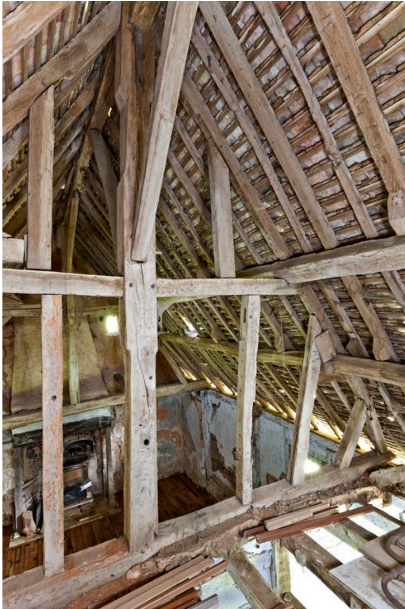
Vue intérieure du logis : ferme intermédiaire, à chevrons porteurs et panne, située entre la pièce à cheminée et la pièce froide.
