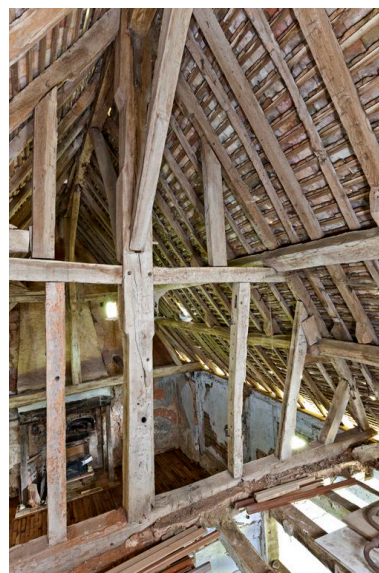
Vue intérieure du logis : ferme intermédiaire, à chevrons porteurs et panne, située entre la pièce à cheminée et la pièce froide. Phot. Yves Guillotin IVR52_20127201207NUCA
