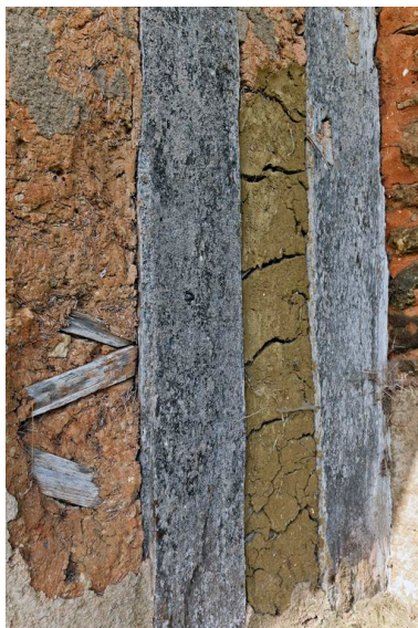
Elévation postérieure : détail de la mise en oeuvre du pan-de-bois. Phot. Yves Guillotin IVR52_20127201202NUCA
