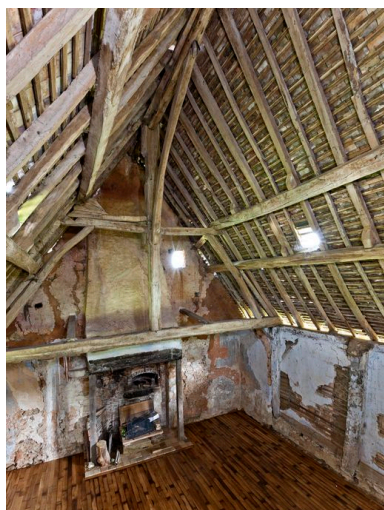
Vue intérieure du logis : pièce principale à cheminée. Phot. Yves Guillotin IVR52_20127201206NUCA
