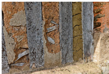
Elévation postérieure : détail de la mise en oeuvre du pan-de-bois. Phot. Yves Guillotin IVR52_20127201203NUCA
