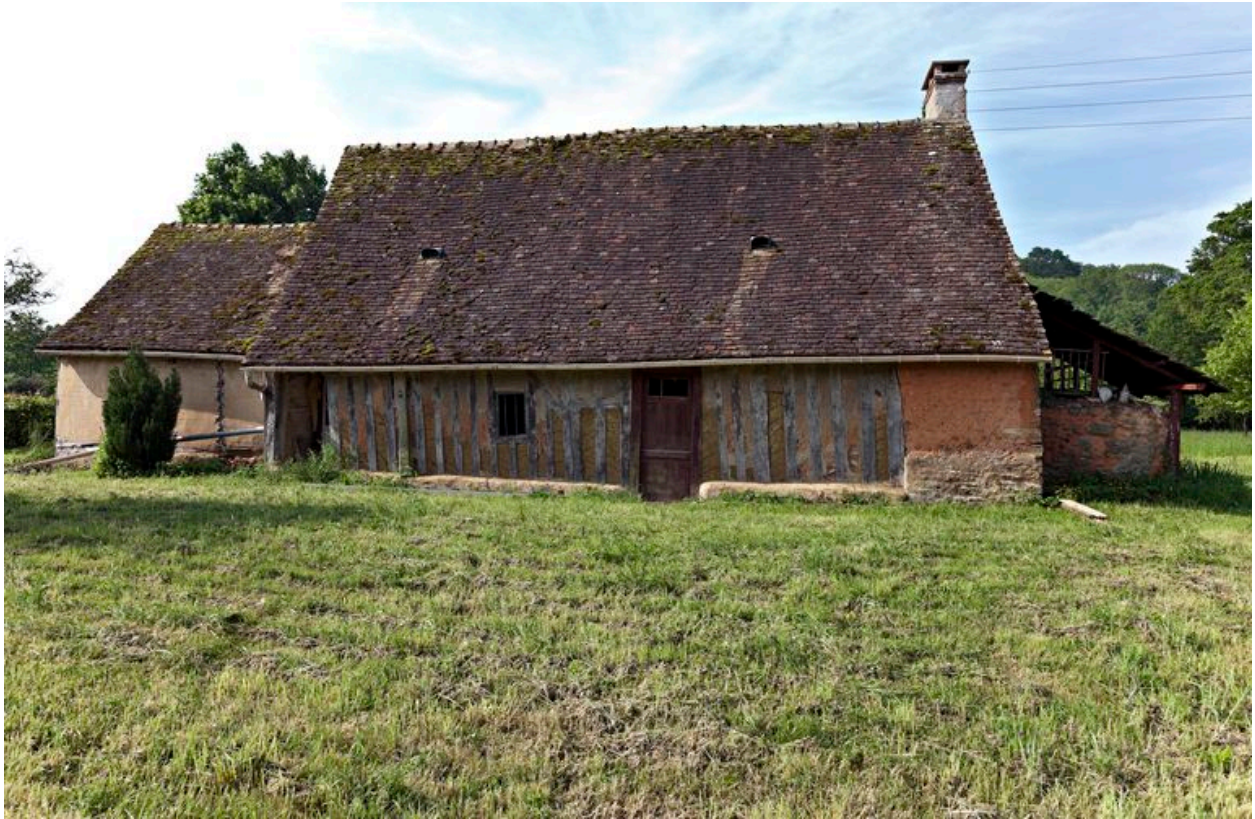
Elevation postérieure du logis.
