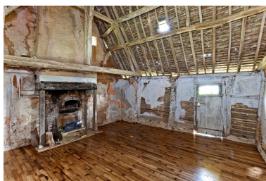
Vue intérieure du logis : pièce principale à cheminée. Phot. Yves Guillotin IVR52_20127201208NUCA
