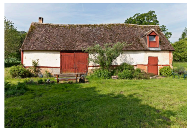
Elevation antérieure de la grange-étable. Phot. Yves Guillotin IVR52_20127201205NUCA
