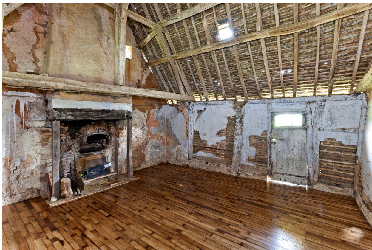
Vue intérieure du logis : pièce principale à cheminée.
