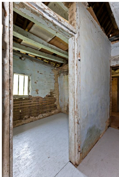
Vue intérieure du logis : laiterie. Phot. Yves Guillotin IVR52_20127201209NUCA
