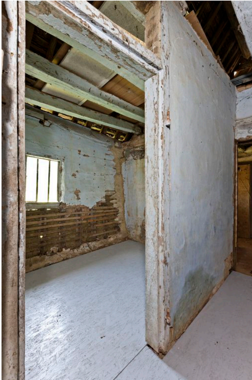
Vue intérieure du logis : laiterie.
