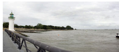
Vue de la jetée vers l'aval. Phot. François Lasa IVR52_20054401100NUCA
