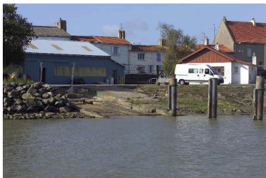
La cale située en aval du bassin de carénage. Phot. Denis Pillet IVR52_20044401885NUCA
