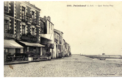
La jetée vue depuis le quai Boulay-Paty (1er quart XXe siècle). Autr. Artaud-Nozais, Phot. Denis (reproduction) Pillet IVR52_20034401769NUCA
