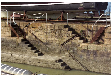
Le bassin de carénage, détail des quais. Phot. Denis Pillet IVR52_20044401897NUCA
