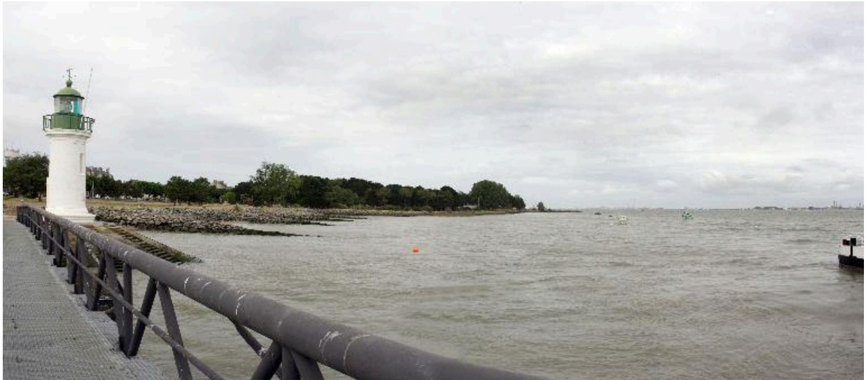
Vue de la jetée vers l'aval.
