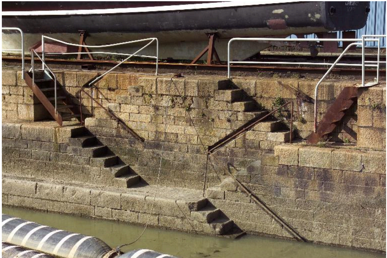
Le bassin de carénage, détail des quais.
