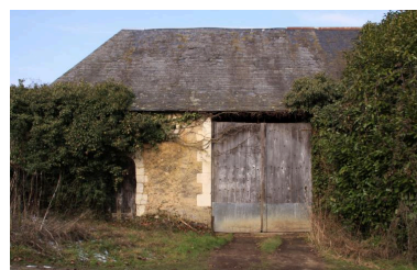
Grange : façade antérieure sur cour. Phot. Jean-Baptiste Darrasse IVR52_20107200299NUCA
