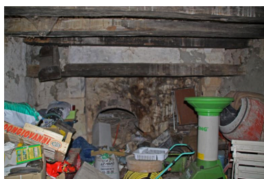
Buanderie : cheminée équipée d'un four à pain. Phot. Jean-Baptiste Darrasse IVR52_20107200297NUCA
