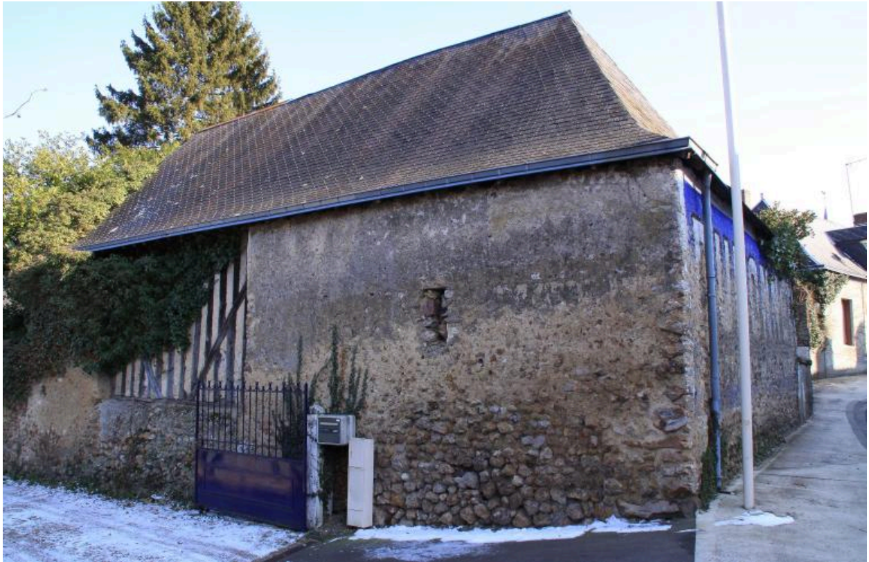
Grange, façade postérieure vue depuis la rue.
