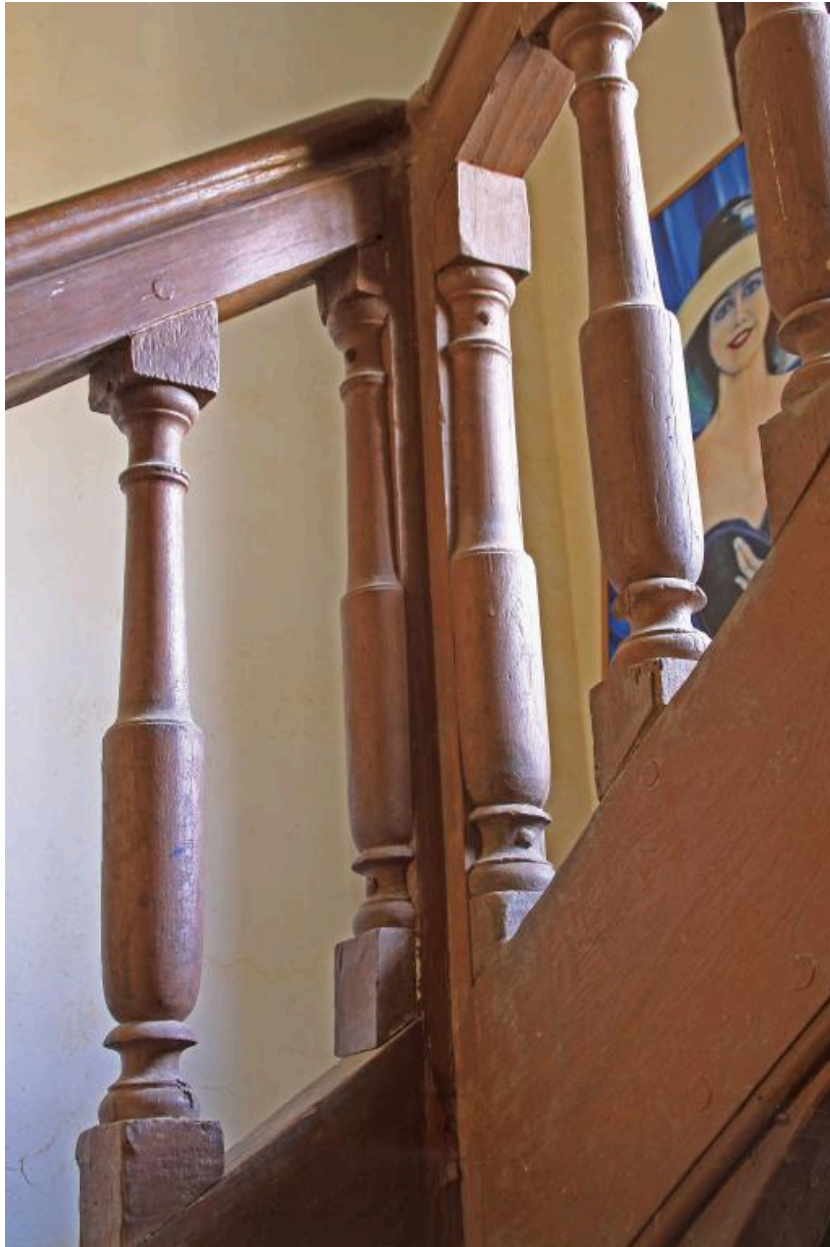
Vestibule, escalier : détail des balustres.
