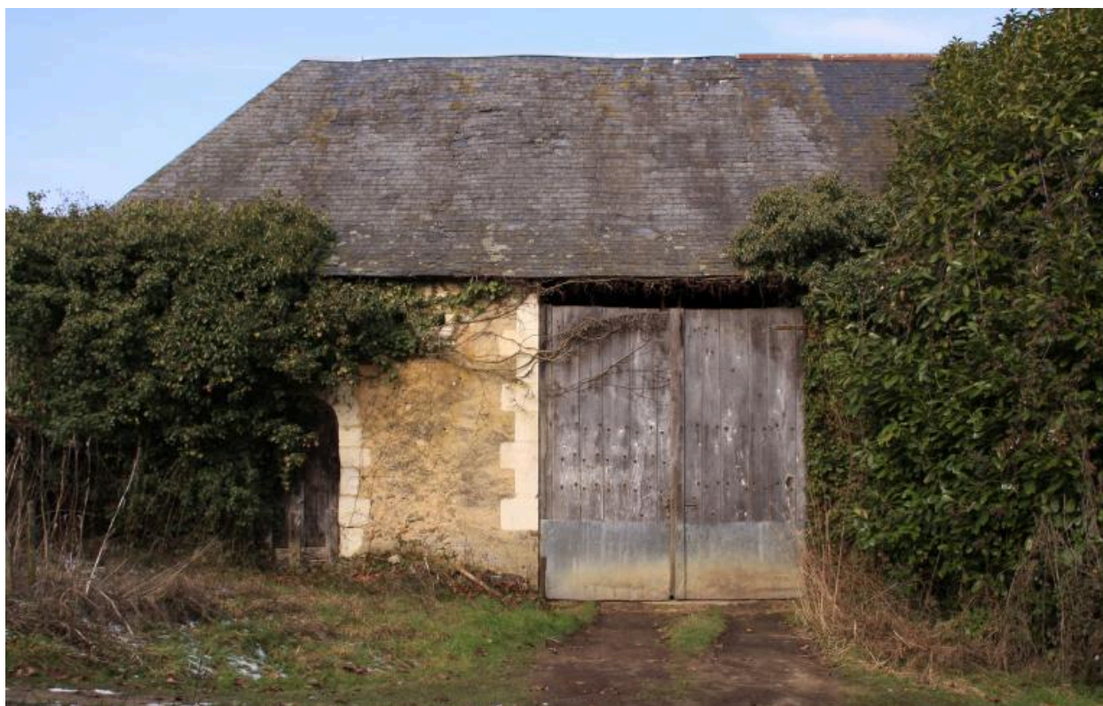
Grange : façade antérieure sur cour.
