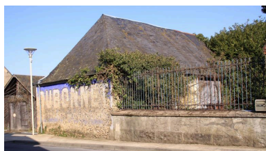
Grange, vue de volume depuis la rue. Phot. Jean-Baptiste Darrasse IVR52_20107200229NUCA
