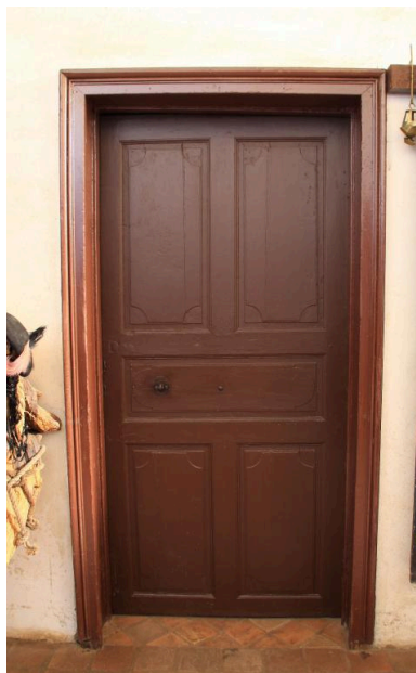
Vestibule, porte intérieure. Phot. Jean-Baptiste Darrasse IVR52_20107200296NUCA
