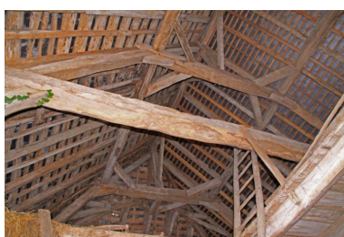
Grange, charpente. Phot. Jean-Baptiste Darrasse IVR52_20107200300NUCA
