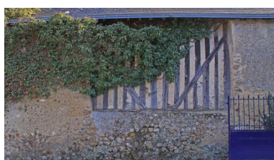
Grange : façade postérieure en pan de bois. Phot. Jean-Baptiste Darrasse IVR52_20107200251NUCA
