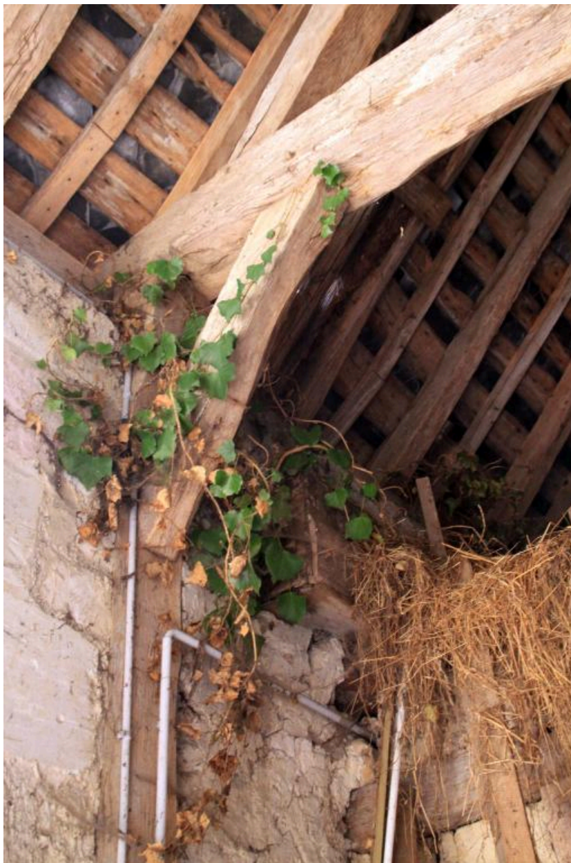
Grange : détail d'un poteau de bois.
