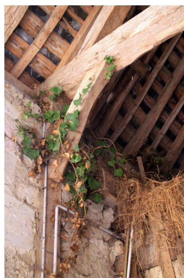
Grange : détail d'un poteau de bois. Phot. Jean-Baptiste Darrasse IVR52_20107200301NUCA
