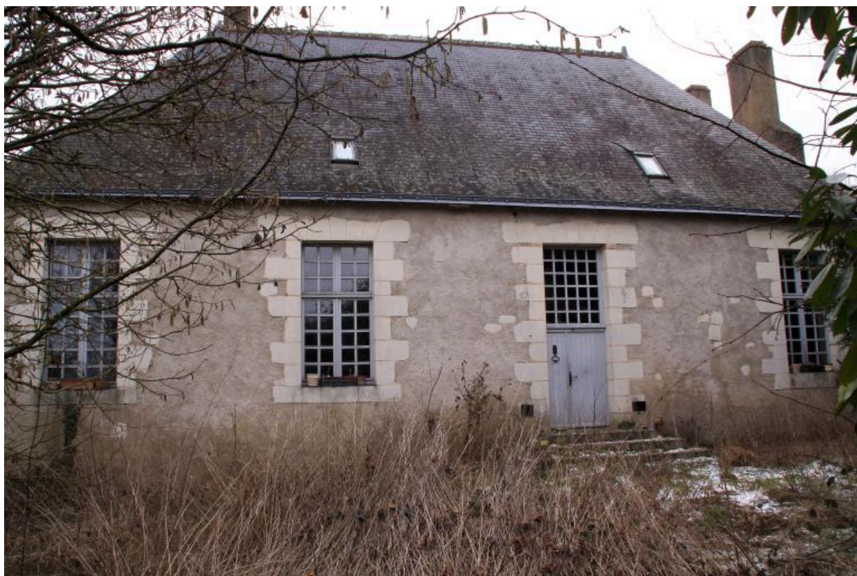
Presbytère, façade postérieure (actuellement, façade principale).
