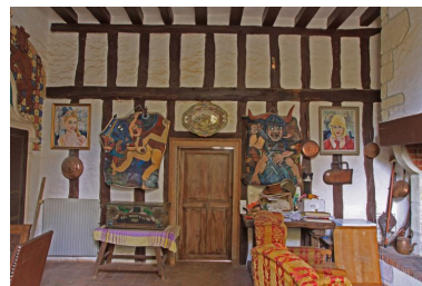
Cloison en pan de bois séparant la salle principale de la chambre. Phot. Jean-Baptiste Darrasse IVR52_20107200291NUCA
