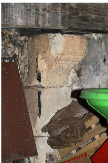
Buanderie : détail du corbeau gauche de la cheminée. Phot. Jean-Baptiste Darrasse IVR52_20107200298NUCA
