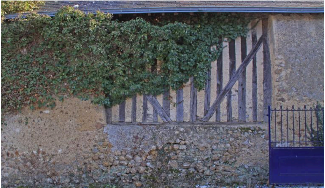
Grange : façade postérieure en pan de bois.
