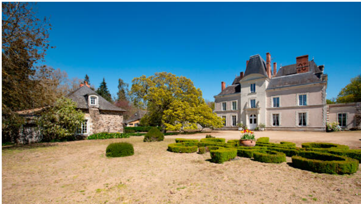
L'élévation antérieure et le parterre, côté Mayenne.
