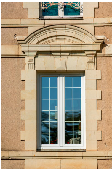
Une fenêtre de l'élévation postérieure. Phot. Pierre-Bernard Fourny IVR52_20235300264NUCA
