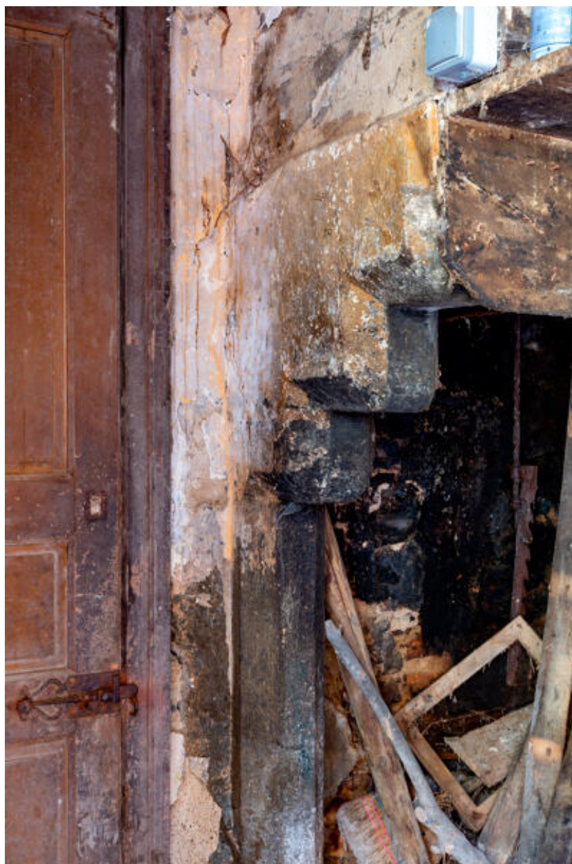
La cheminée de l'ancienne cuisine, détail.
