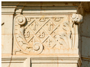
La porte de l'avant-corps formant tour, détail du décor sculpté. Phot. Pierre-Bernard Fourny IVR52_20235300260NUCA
