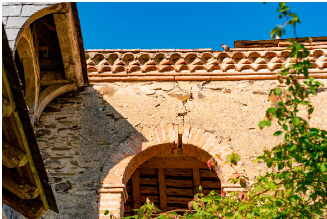
Le corps de dépendances longeant la Mayenne, détail de la double génoise.
