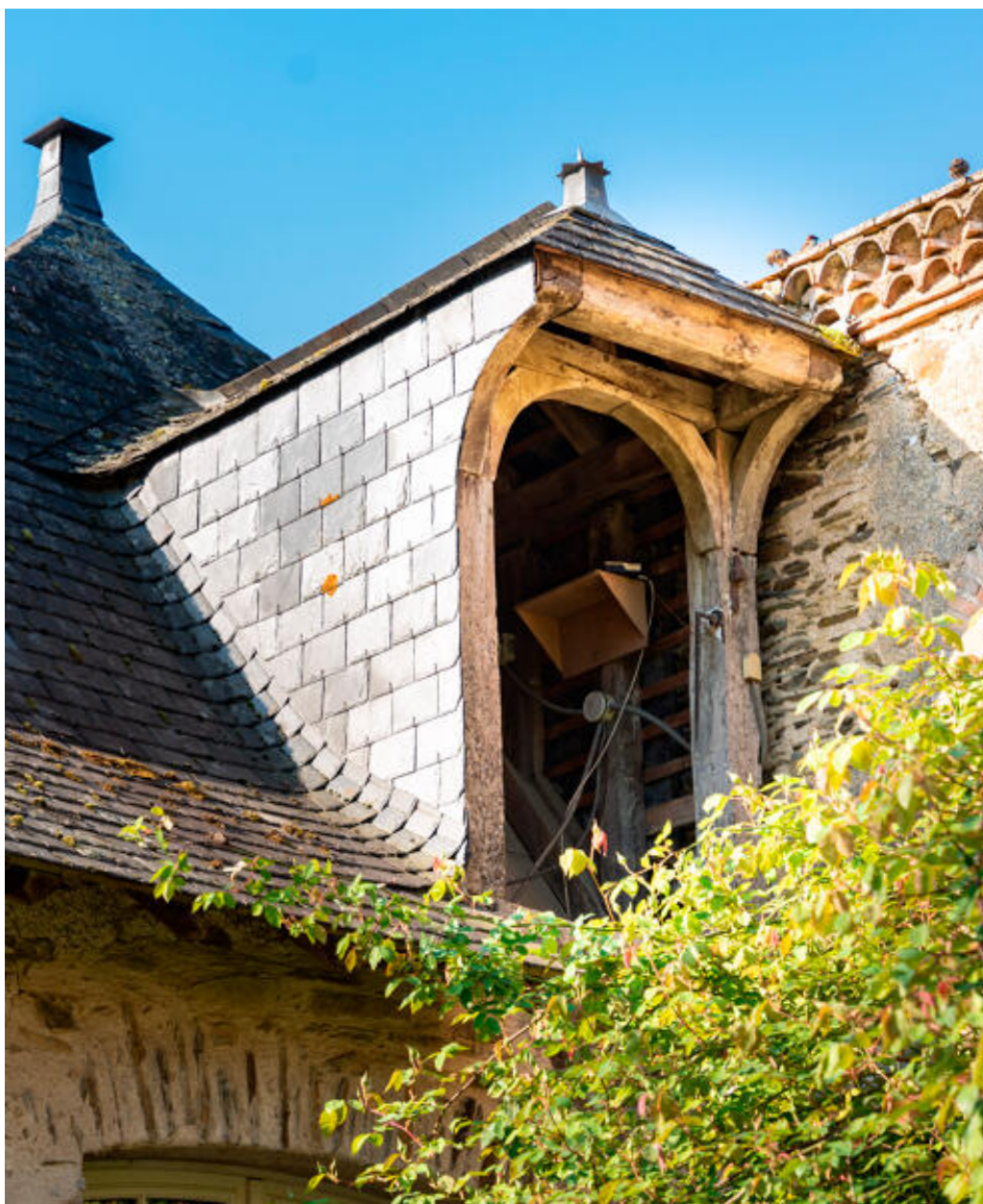
Le corps de dépendances longeant la Mayenne, détail d'une lucarne gerbière.
