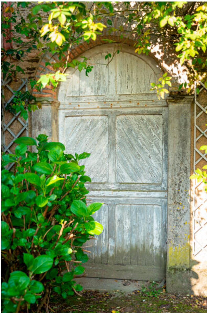
Le corps de dépendances longeant la Mayenne, détail d'une porte.
