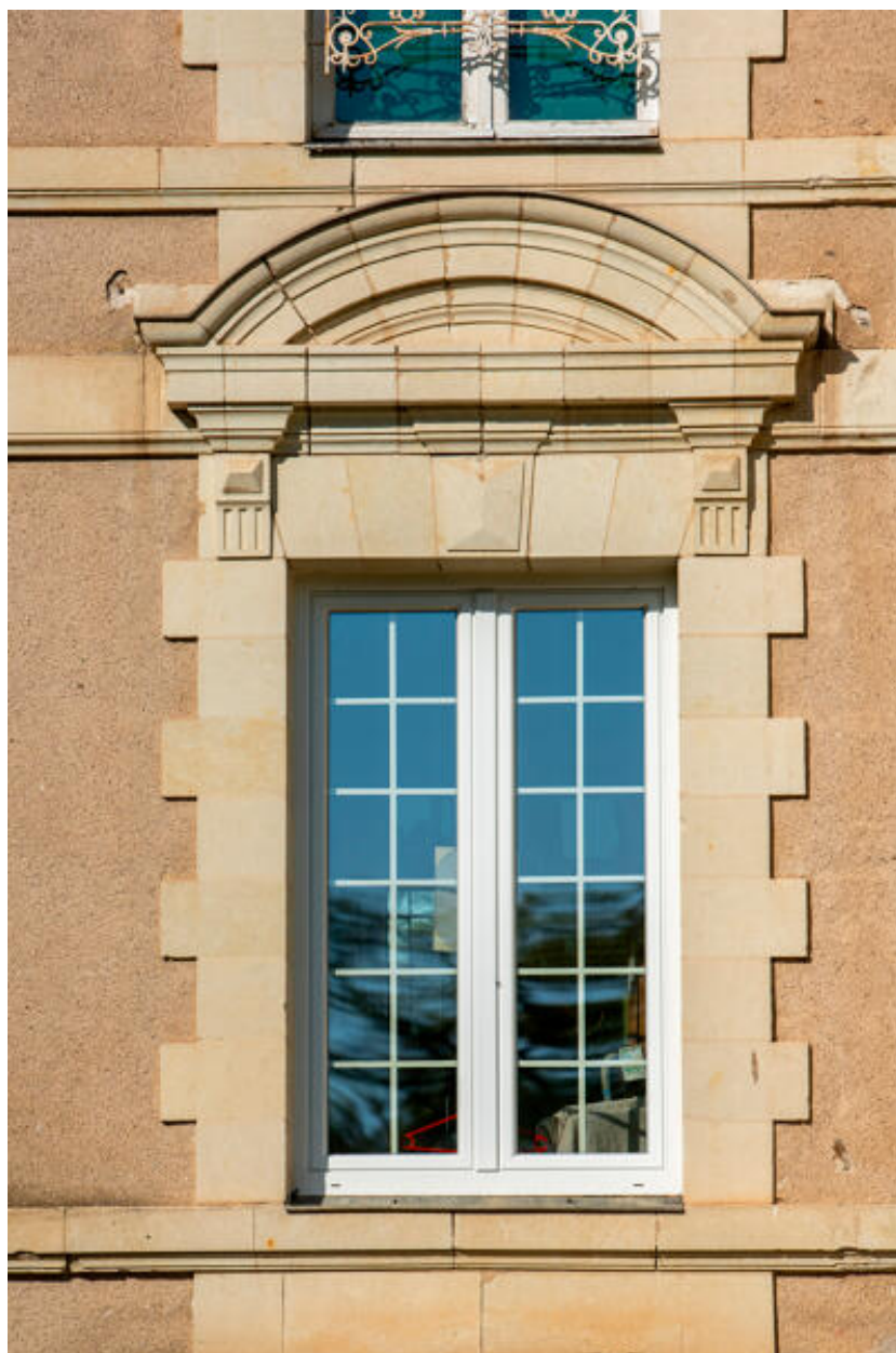
Une fenêtre de l'élévation postérieure.
