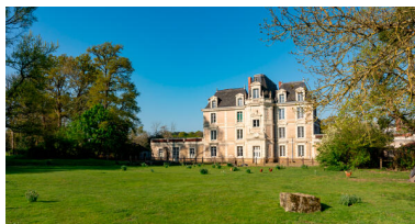
Une vue d'ensemble, côté parc. Phot. Pierre-Bernard Fourny IVR52_20235300255NUCA
