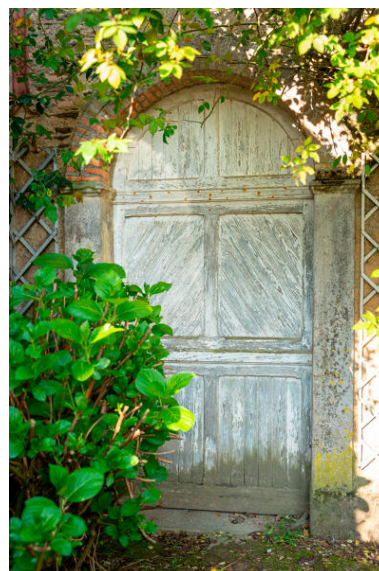
Le corps de dépendances longeant la Mayenne, détail d'une porte. Phot. Pierre-Bernard Fourny IVR52_20235300241NUCA
