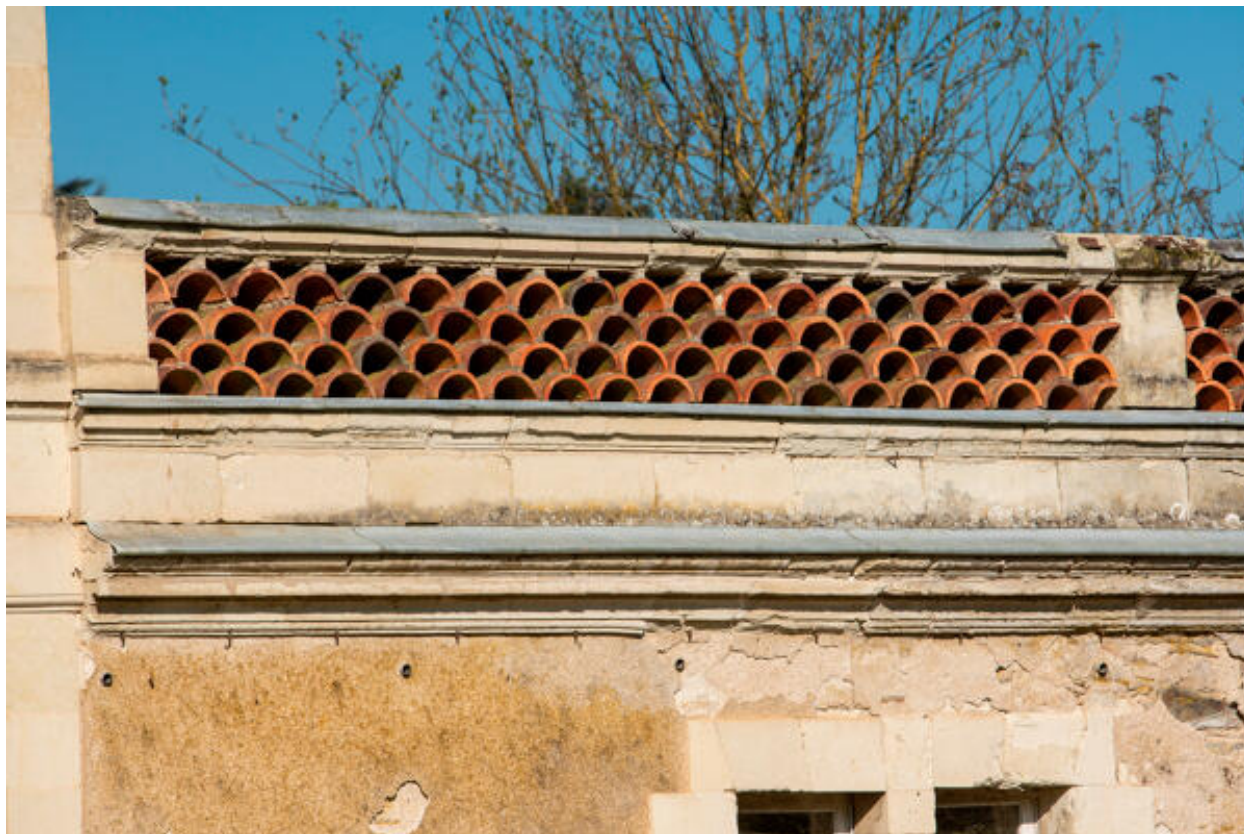
Le garde-corps couronnant l'aile nord.
