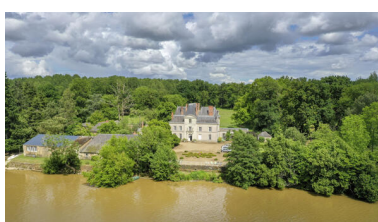
Le château face à la Mayenne. Phot. Pierre-Bernard Fourny IVR52_20225300572NUCA
