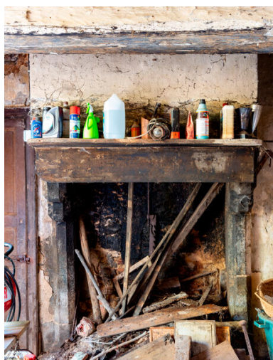
La cheminée de l'ancienne cuisine. Phot. Pierre-Bernard Fourny IVR52_20235300235NUCA
