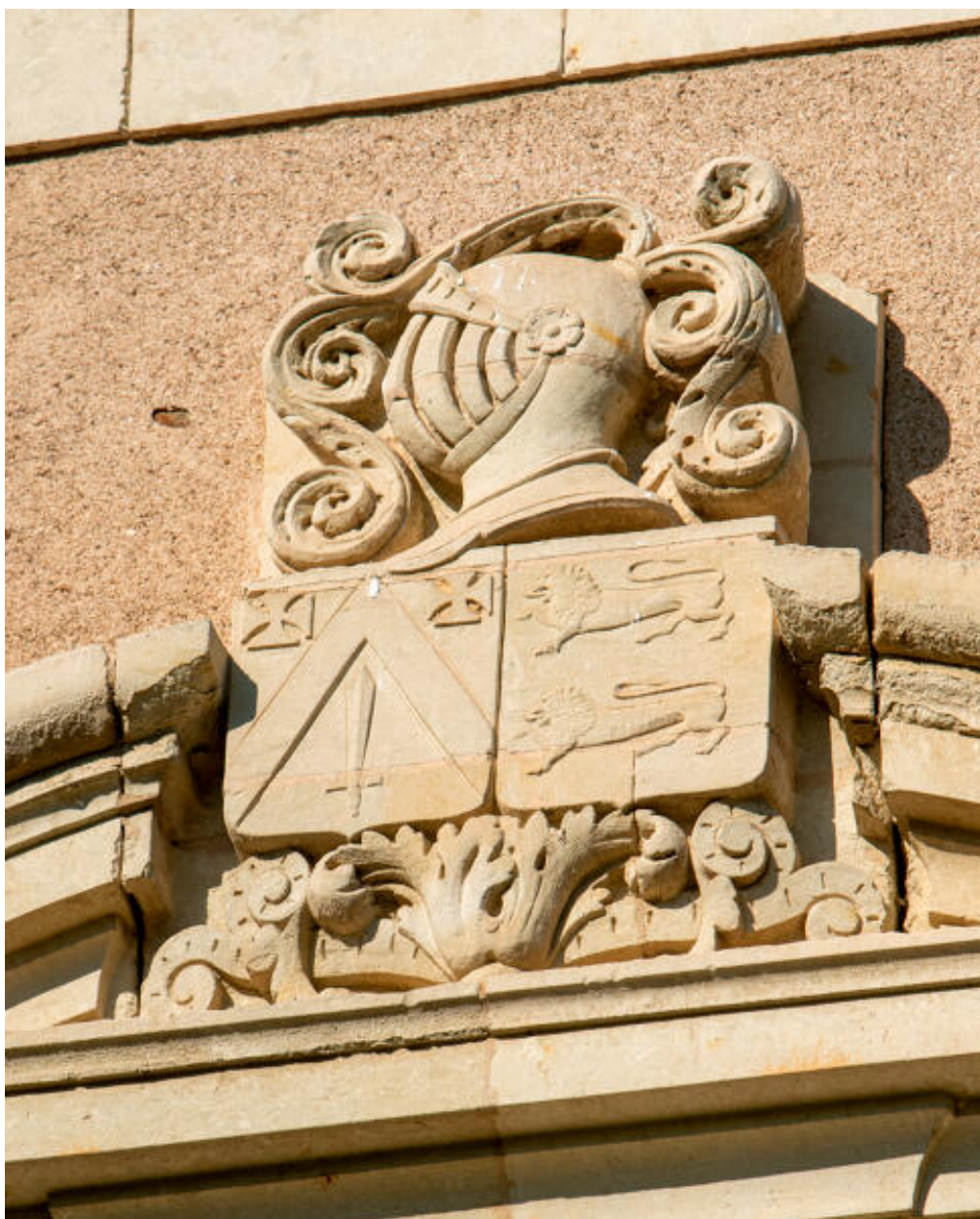
La fenêtre de l'avant-corps formant tour, détail des armoiries.
