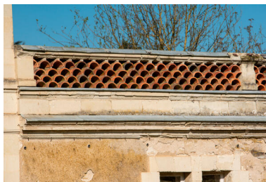
Le garde-corps couronnant l'aile nord. Phot. Pierre-Bernard Fourny IVR52_20235300265NUCA
