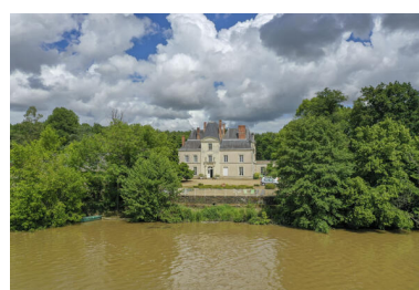
Le château face à la Mayenne. Phot. Pierre-Bernard Fourny IVR52_20225300563NUCA
