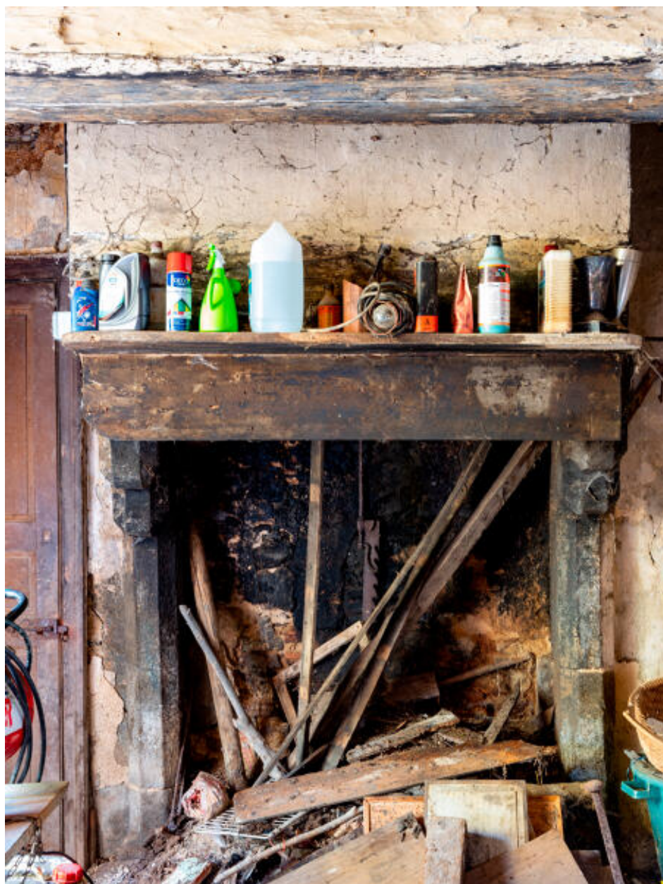
La cheminée de l'ancienne cuisine.
