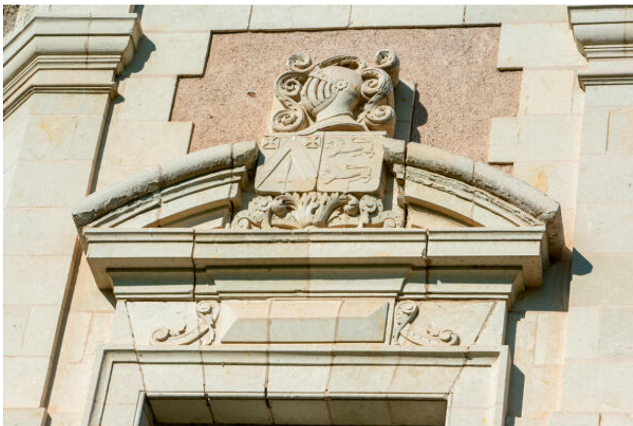
La fenêtre de l'avant-corps formant tour, détail du fronton sculpté.
