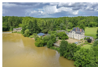
Le château face à la Mayenne. Phot. Pierre-Bernard Fourny IVR52_20225300571NUCA
