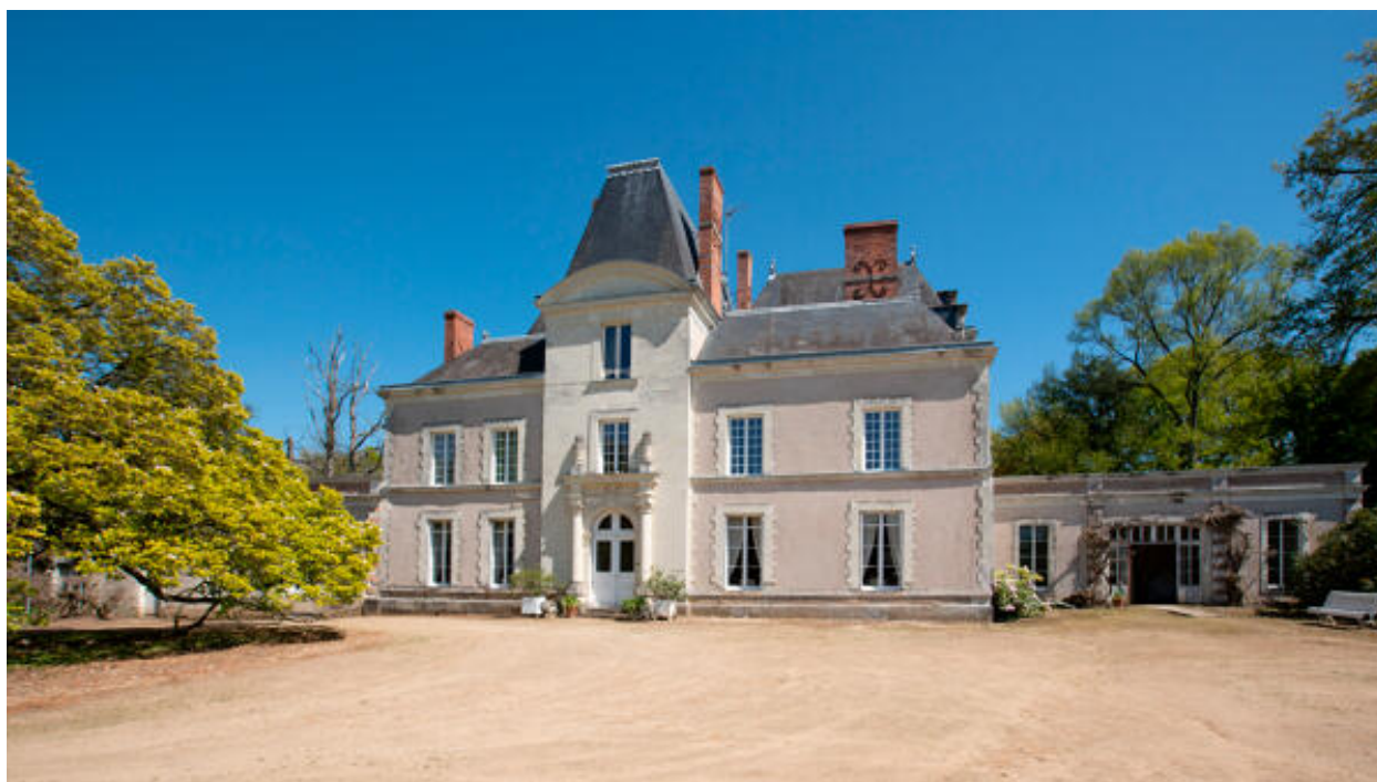
L'élévation antérieure et le parterre, côté Mayenne.
