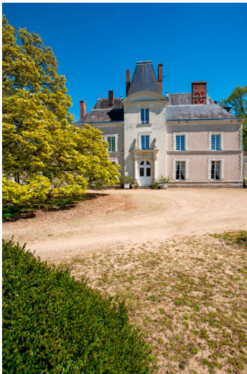
L'élévation antérieure et le parterre, côté Mayenne.
