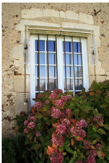
Logis, façade est, fenêtre rez-de-chaussée travée gauche. Phot. Jean-Baptiste Darrasse IVR52_20097201529NUCA
