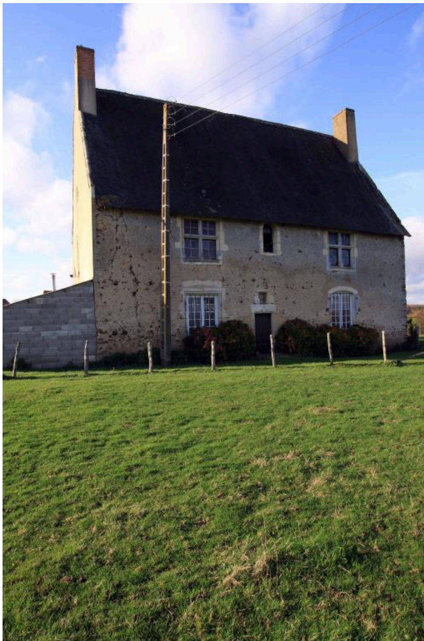
Logis, façade est (principale). Porte d'entrée surmontée d'une niche. Baie d'une ancienne chapelle à l'étage.
