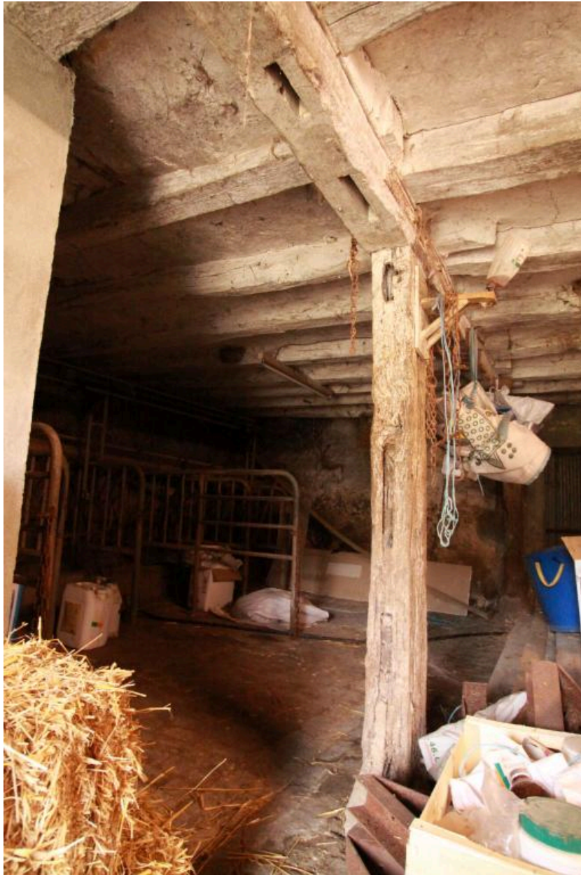
Grange-étable, fenils : détail structure en bois.
