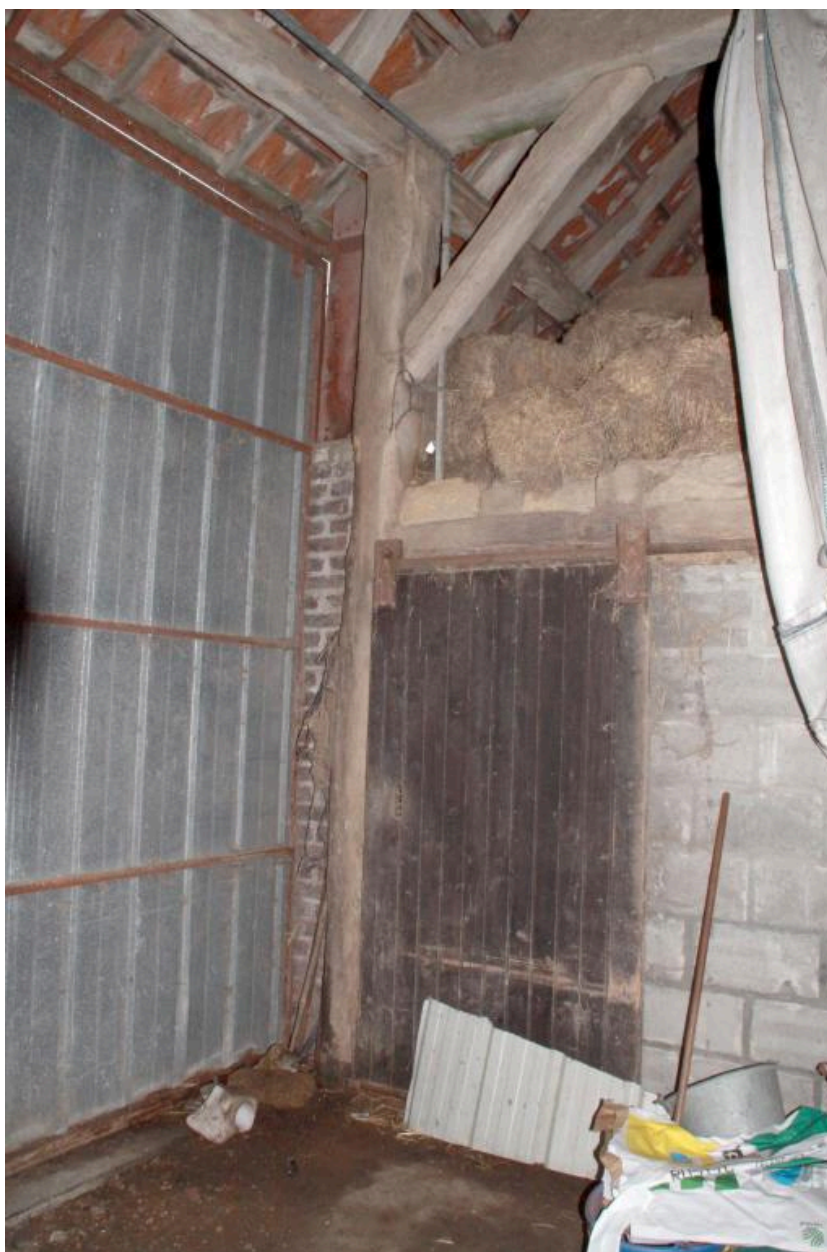
Grange-étable, détail intérieur grange (porte).
