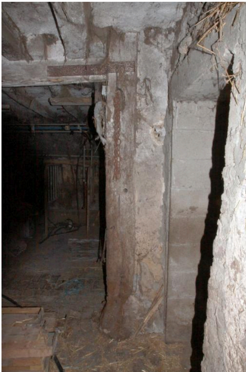
Grange étable : structure en bois et torchis.
