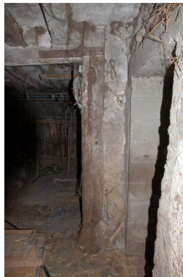
Grange étable : structure en bois et torchis. Phot. Jean-Baptiste Darrasse IVR52_20097201560NUCA
