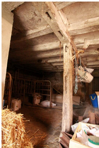
Grange-étable, fenils : détail structure en bois. Phot. Jean-Baptiste Darrasse IVR52_20097201556NUCA
