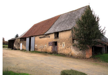
Grange-étable, façade sur cour. Phot. Jean-Baptiste Darrasse IVR52_20097201544NUCA
