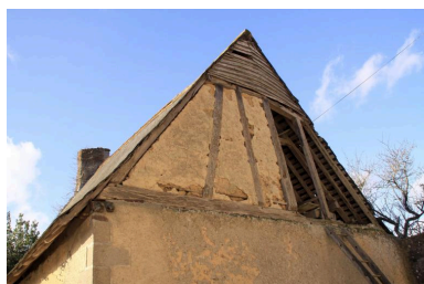
Grange-étable, pignon, détail : pan de bois. Phot. Jean-Baptiste Darrasse IVR52_20097201534NUCA
