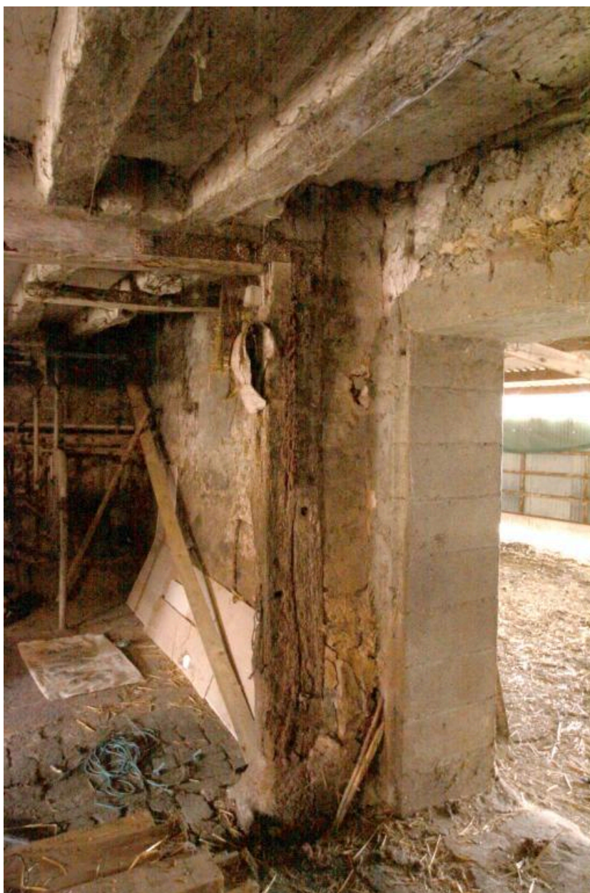
Grange-étable, façade postérieure : entrée.
