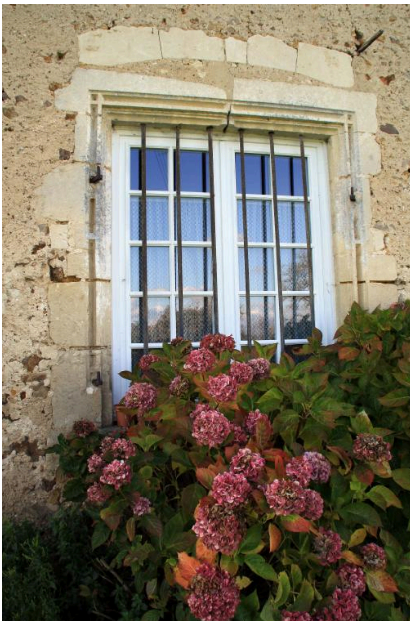
Logis, façade est, fenêtre rez-de-chaussée travée gauche.
