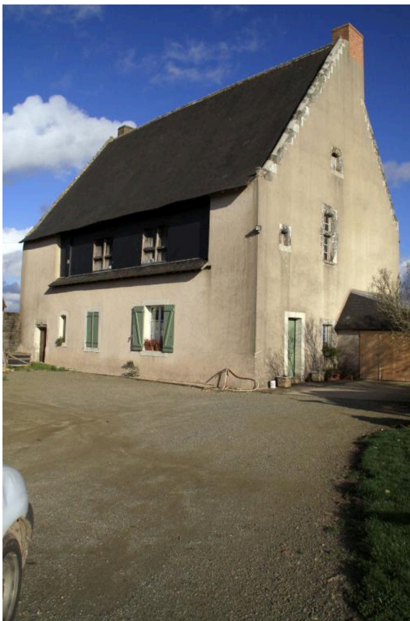
Logis, vue de volume : façade ouest sur cour et pignon sud découvert. A l'étage, galerie ? murée.
