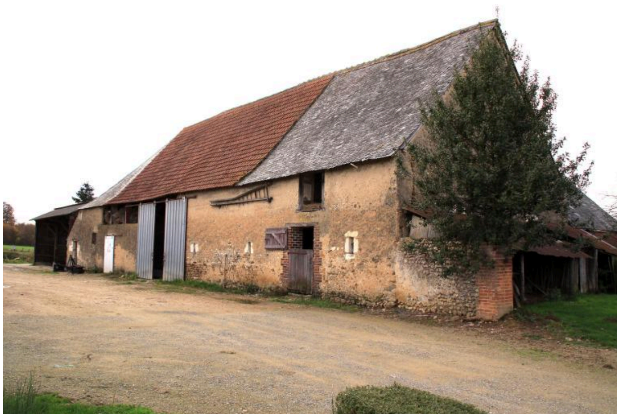
Grange-étable, façade sur cour.
