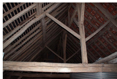
Grange-étable, charpente à pannes avec faux-entrait. Phot. Jean-Baptiste Darrasse IVR52_20097201546NUCA
