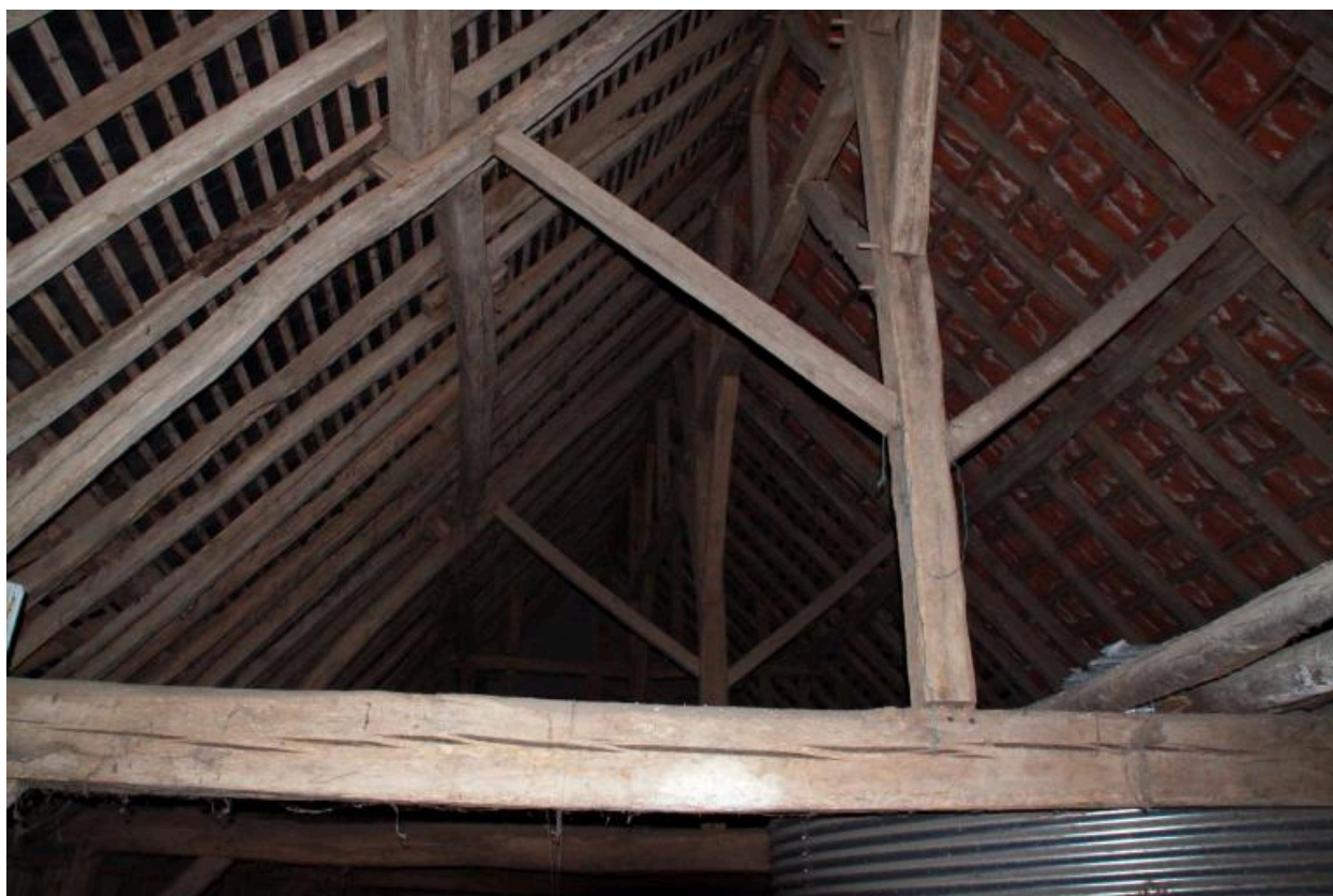
Grange-étable, charpente à pannes avec faux-entrait.
