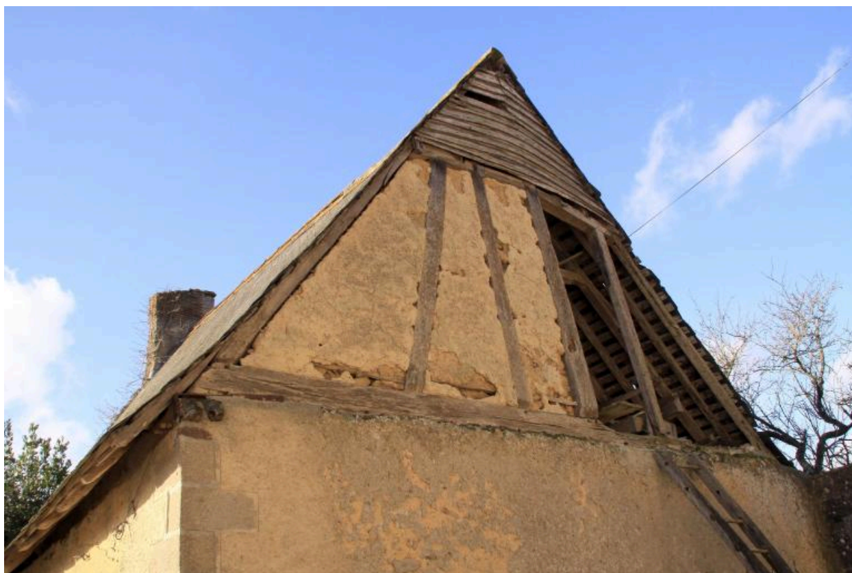
Grange-étable, pignon, détail : pan de bois.
