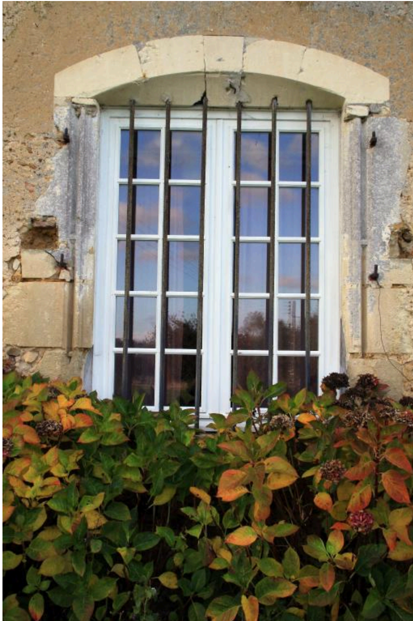
Logis, façade est, fenêtre rez-de-chaussée travée droite.
