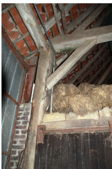
Grange-étable, intérieur grange : poteau cornier et structure en bois. Phot. Jean-Baptiste Darrasse IVR52_20097201553NUCA
