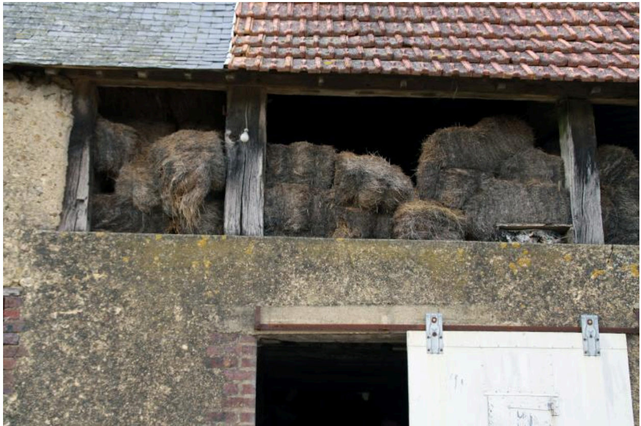
Grange-étable, façade postérieure : fenils.
