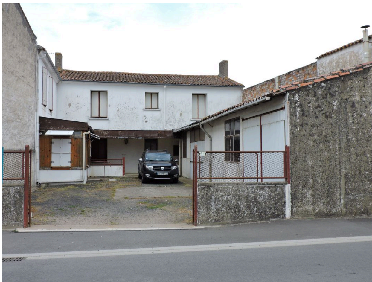
L'ancien café, en fond de cour, et l'ancienne forge, à droite, vus depuis le sud-ouest.
