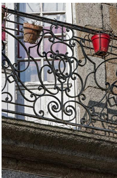
Détail de la ferronnerie du balcon. Phot. Yves Guillotin IVR52_20215300731NUCA
