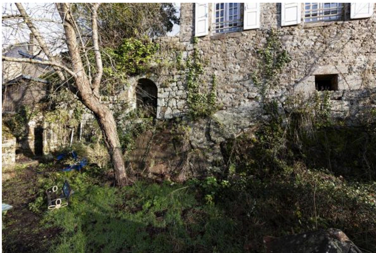
Soubassement sous la maison arrière.
