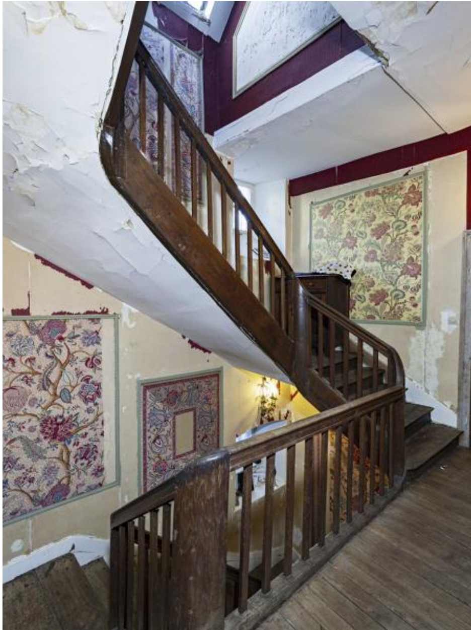
Escalier à jour central. Premier étage.
