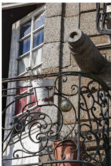
Pierrier en trompe-l'œil surgissant à droite de la façade principale, 1er niveau. Phot. Yves Guillotin IVR52_20215300729NUCA
