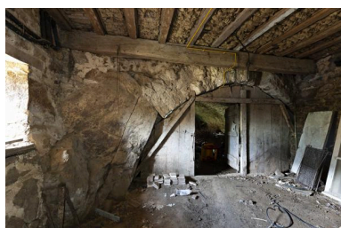
Soubassement de la maison arrière. Phot. Yves Guillotin IVR52_20195301293NUCA
