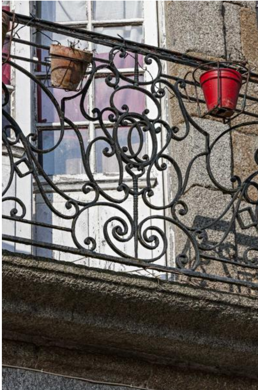
Détail de la ferronnerie du balcon.
