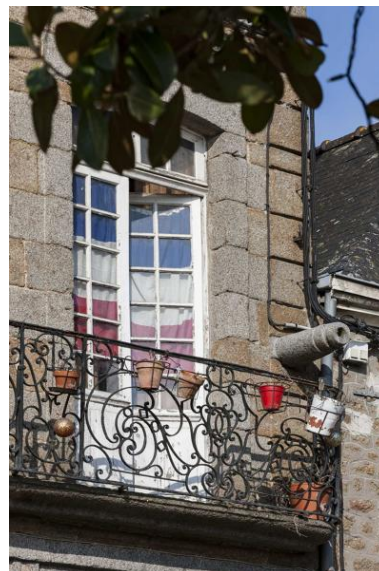
Pierrier en trompe-l'œil surgissant à droite de la façade principale, 1er niveau. Phot. Yves Guillotin IVR52_20215300728NUCA
