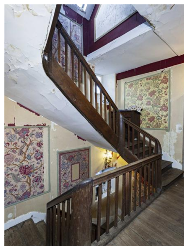
Escalier à jour central. Premier étage. Phot. Yves Guillotin IVR52_20215301743NUCA
