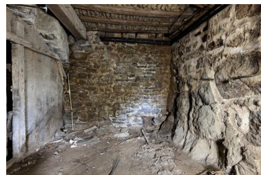
Soubassement de la maison arrière. Phot. Yves Guillotin IVR52_20195301294NUCA
