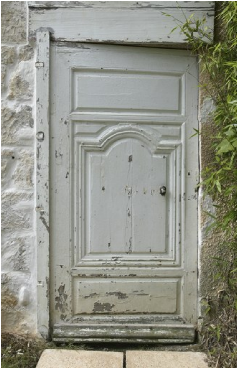
Ancienne porte du logis, réemployée dans un bâtiment de commun.
