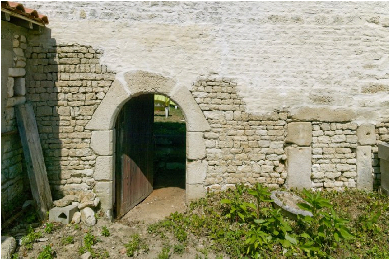
Vue du cellier, prise du sud.
