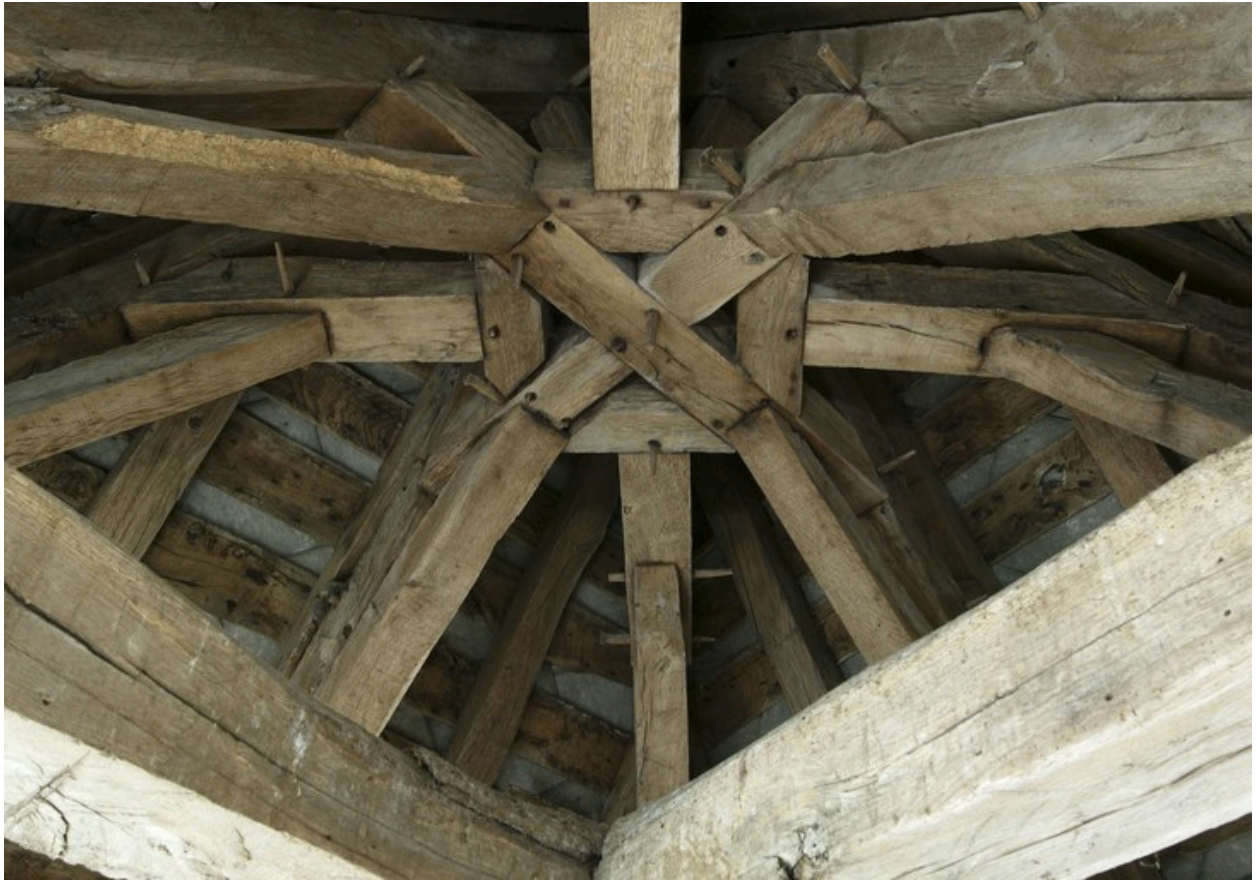
Charpente du pigeonnier.
