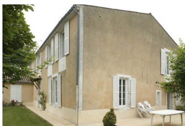
Vue de l'arrière du logis, prise du sud-ouest du jardin. Phot. Patrice Giraud IVR52_20088500927NUCA
