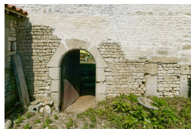
Vue du cellier, prise du sud. Phot. Patrice Giraud IVR52_20098500493NUCA
