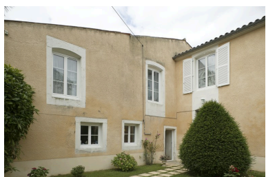
Vue des façades sur cour du logis, prises du nord de la cour. Phot. Patrice Giraud IVR52_20088500926NUCA
