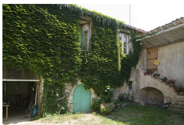
Anciennes dépendances, rue Henry-Renaud : partie sud de la façade sur jardin. Phot. Patrice Giraud IVR52_20098500494NUCA
