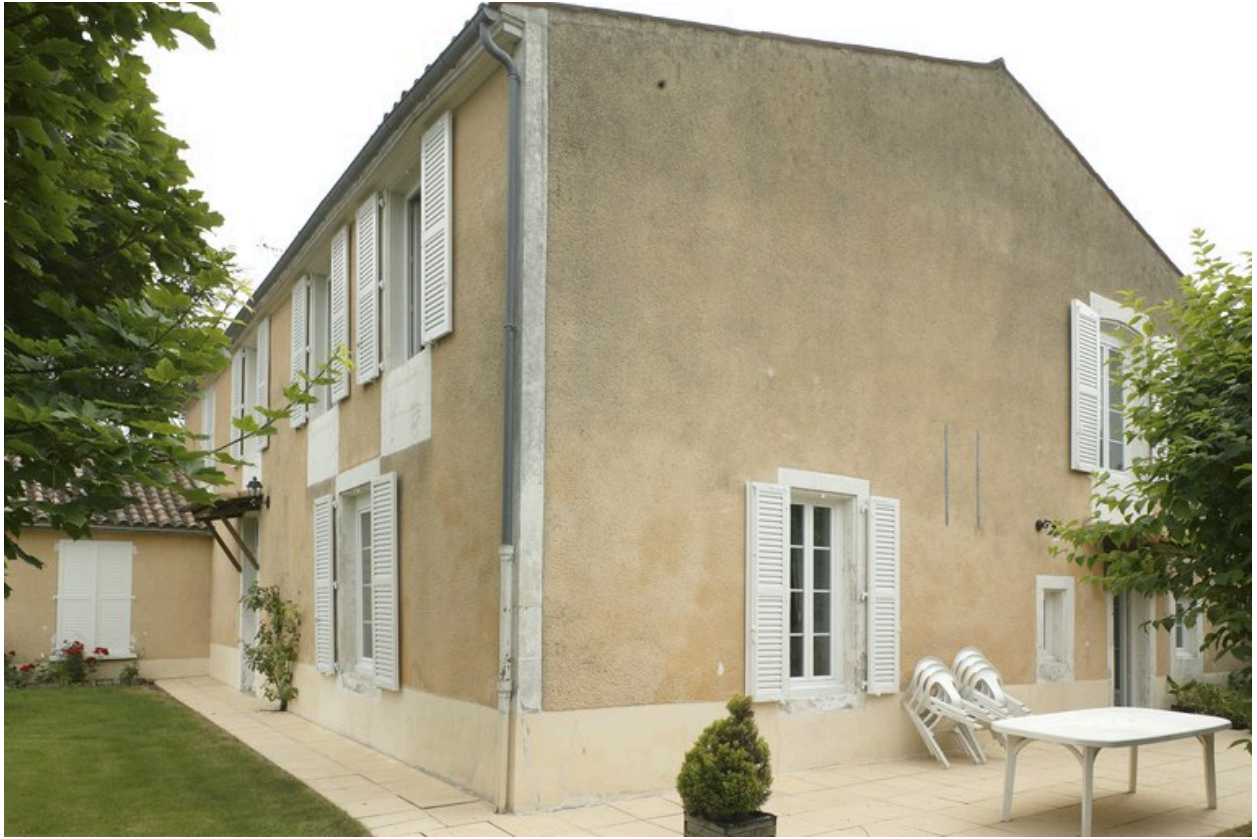
Vue de l'arrière du logis, prise du sud-ouest du jardin.
