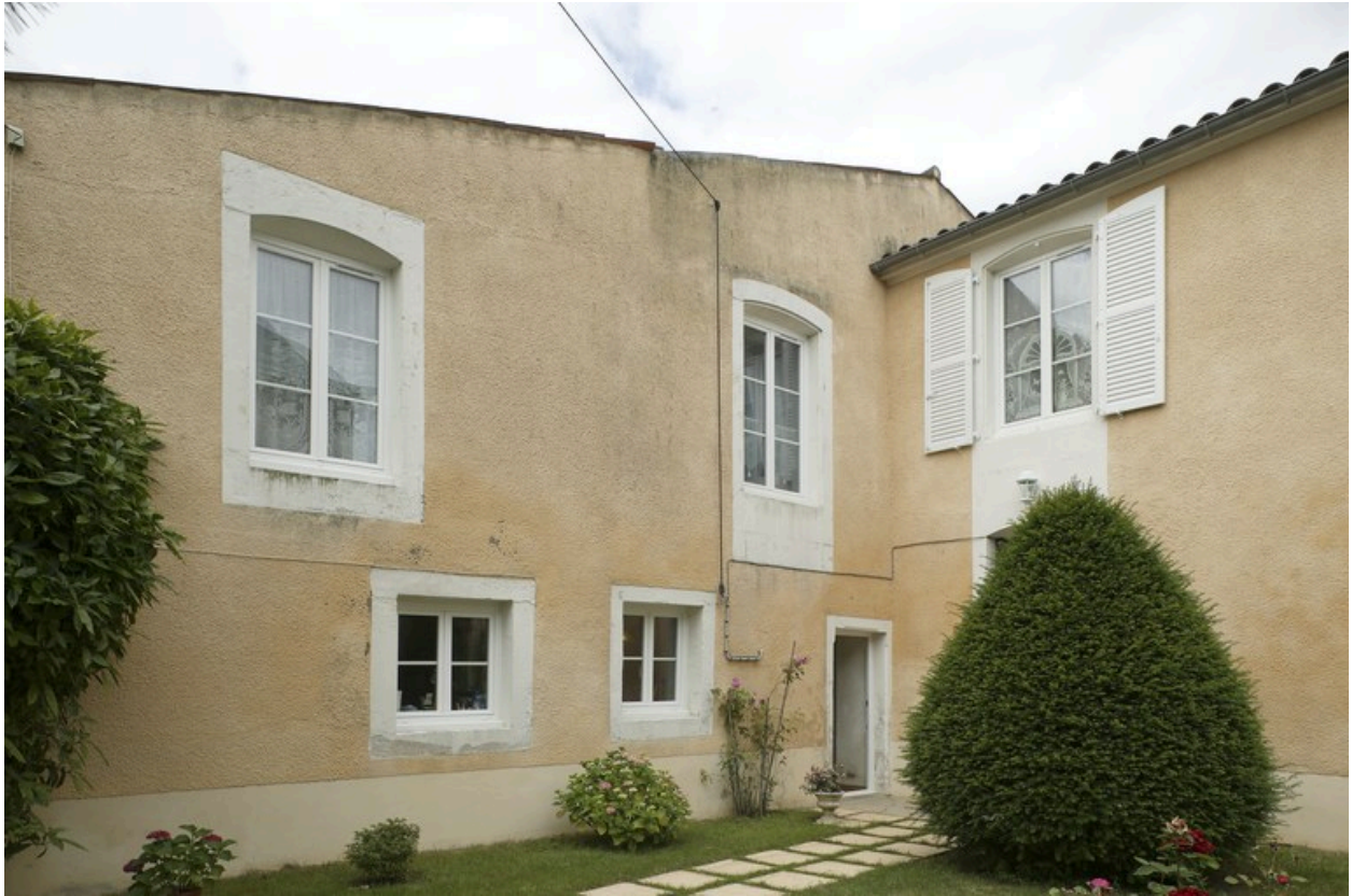
Vue des façades sur cour du logis, prises du nord de la cour.
