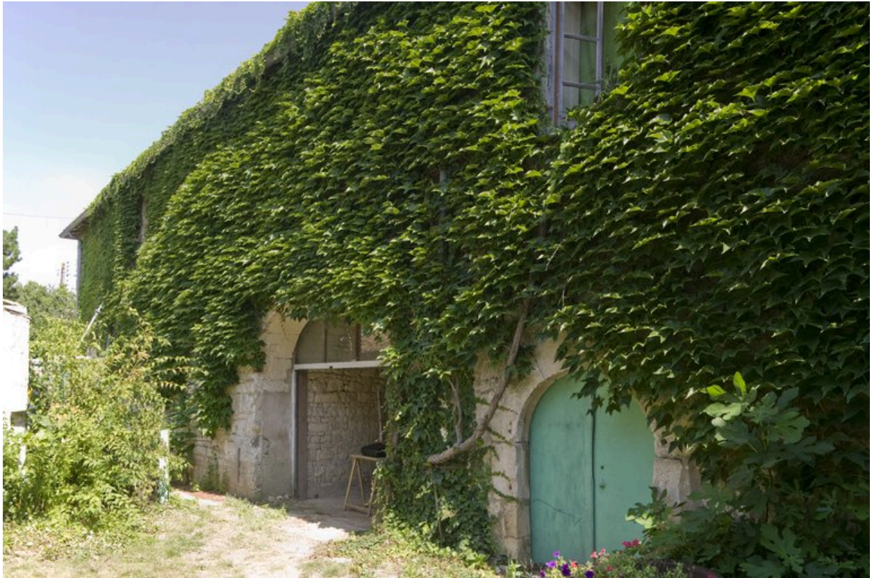
Anciennes dépendances, rue Henry-Renaud : partie nord de la façade sur jardin.
