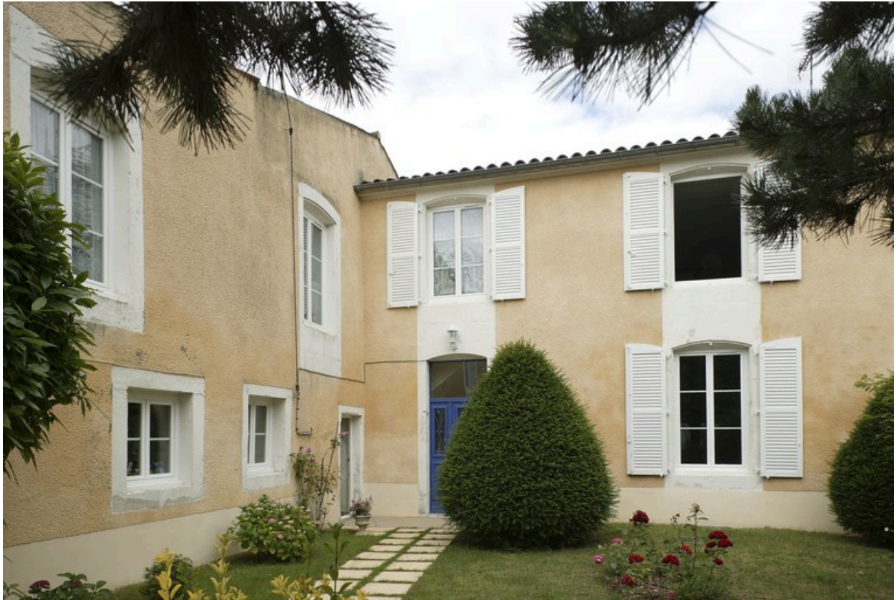
Vue des façades sur cour du logis, prises de l'entrée (à l'est de la cour).
