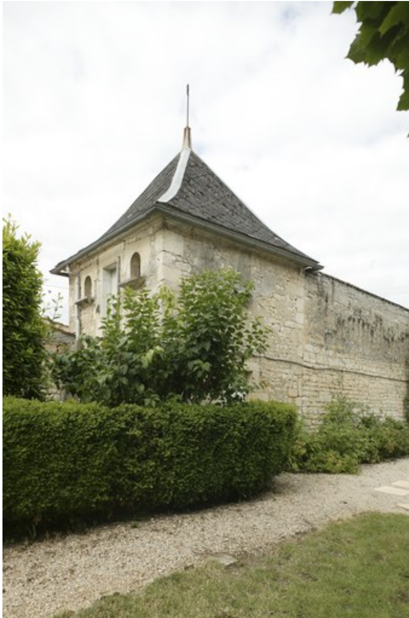
Vue d'ensemble du pigeonnier.
