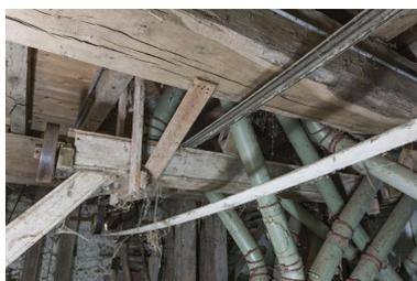
Premier étage du moulin : vue rapprochée des conduits métalliques assurant la descente des céréales vers les broyeurs.
