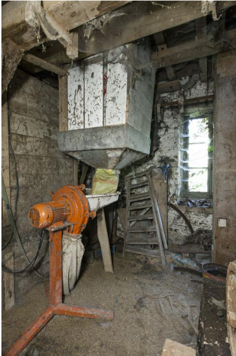
Premier étage du moulin, angle nord-est : ensacheur à trémie moderne, vu depuis l'ouest.
