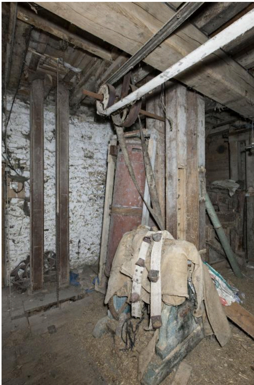
Premier étage du moulin : monte-sac intérieur et élévateurs à godets ouest vus depuis le sud-est.
