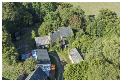
Vue aérienne du moulin et de ses dépendances depuis le sud-est en 2018. Au fond, l'étable, l'ancien logis et le moulin ; à droite, le nouveau logis. Phot. Yves Guillotin IVR52_20185300400NUCA
