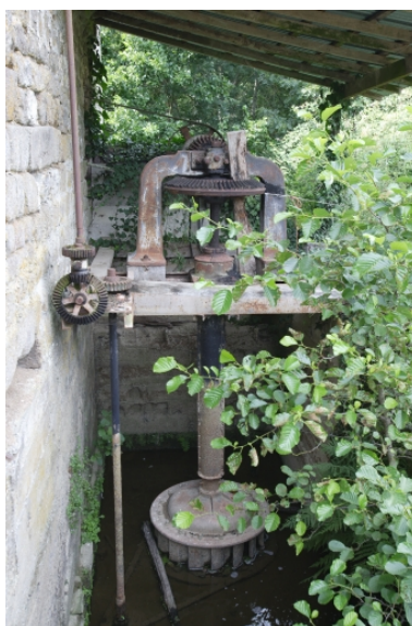
La turbine en 2006. Phot. François Lasa IVR52_20065300763NUCA
