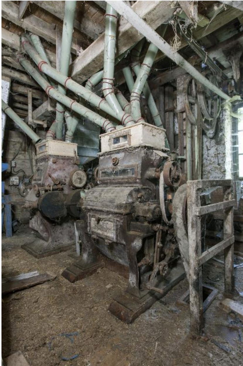
Premier étage du moulin : vue depuis le sud-ouest des broyeurs à cylindres.
