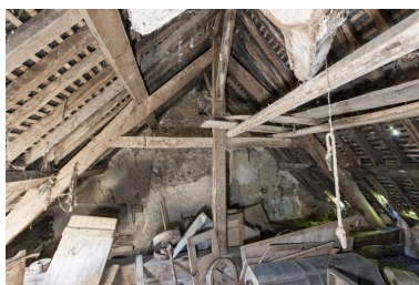
Ancien logis du meunier, comble : charpente vue depuis l'est. Phot. Yves Guillotin IVR52_20185300424NUCA
