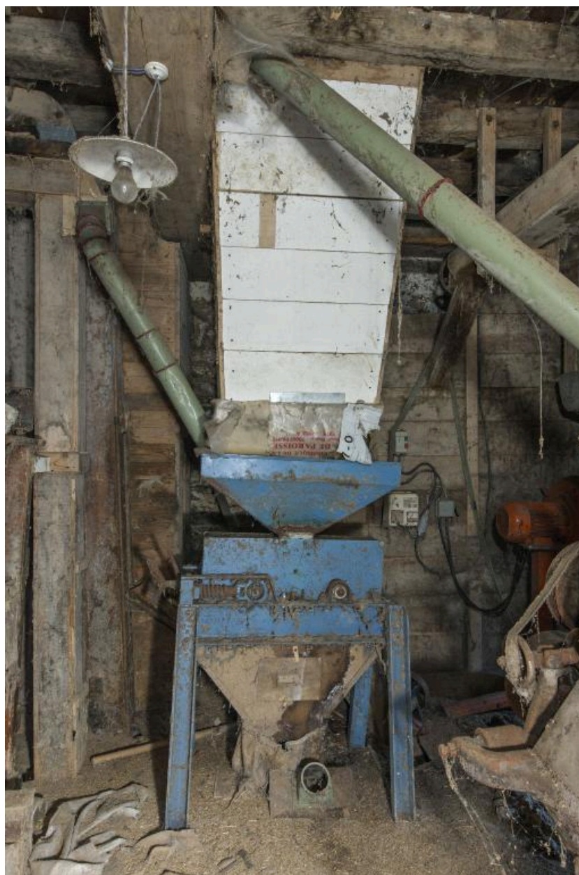
Premier étage du moulin, angle nord-est : aplatisseur vu depuis le sud.
