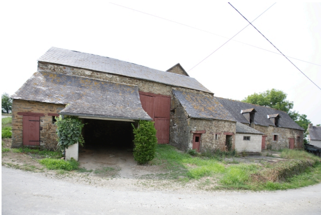
Les bâtiments ouest de la ferme vus depuis le chemin à l'est : la grange, le bûcher, l'étable à vaches.
