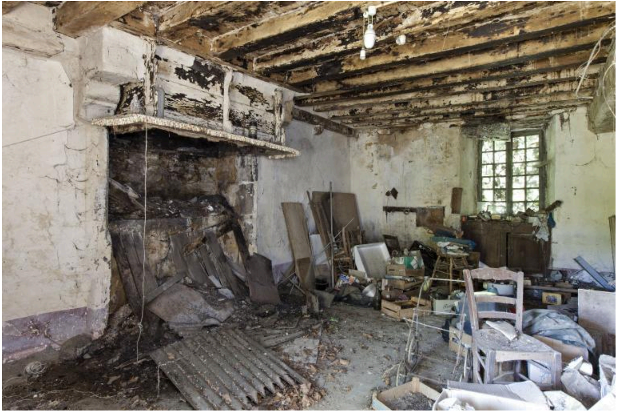
Ancien logis du meunier, premier étage : vue d'ensemble de la pièce principale depuis le sud-est en 2018.
