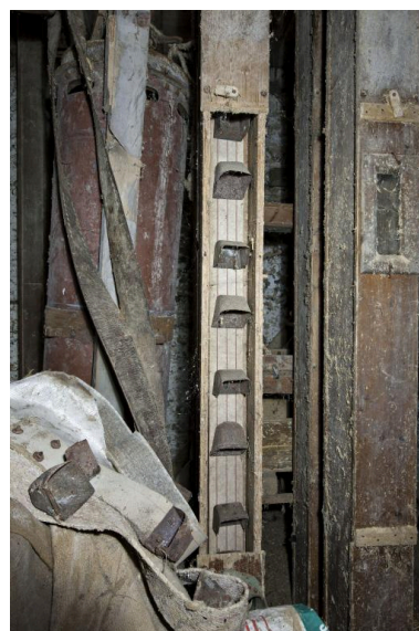
Premier étage du moulin : vue de détail des élévateurs à godets ouest et d'une sangle à godets démontée.
