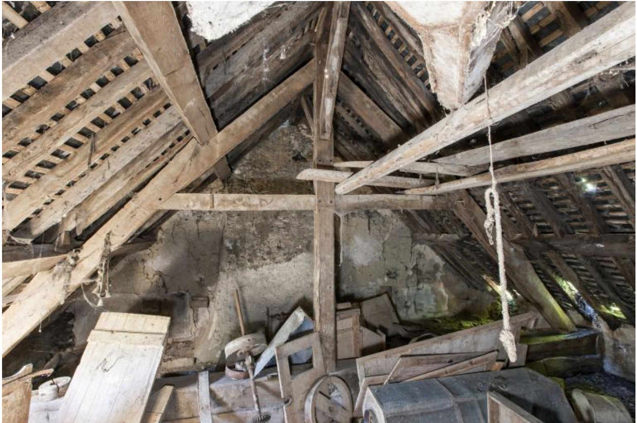
Ancien logis du meunier, comble : charpente vue depuis l'est.
