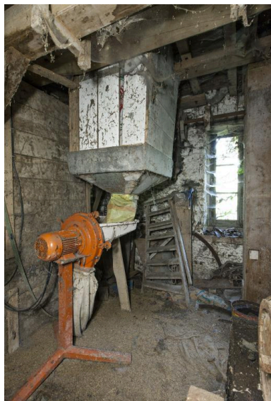
Premier étage du moulin, angle nord-est : ensacheur à trémie moderne, vu depuis l'ouest. Phot. Yves Guillotin IVR52_20185300415NUCA
