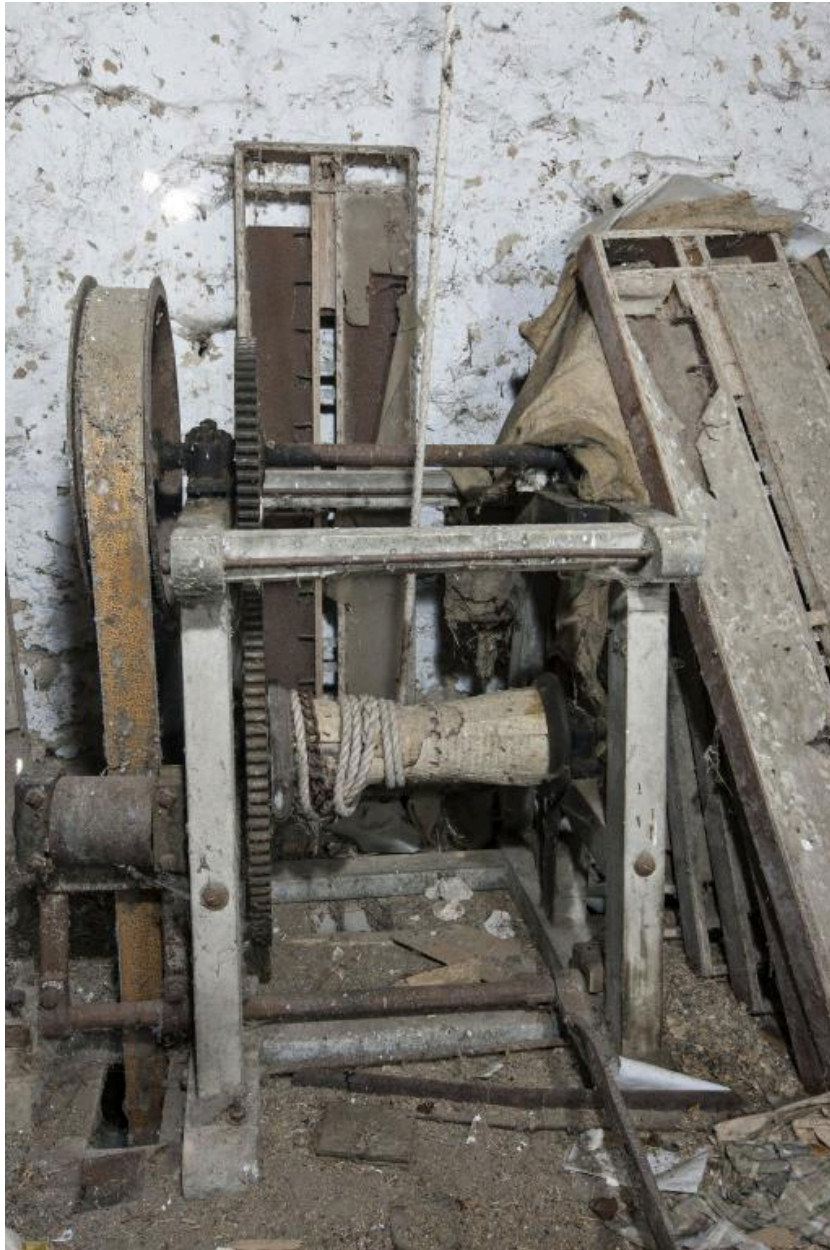
Comble du moulin, angle sud-est : poulie commandant le monte-sac intérieur vue depuis l'ouest.
