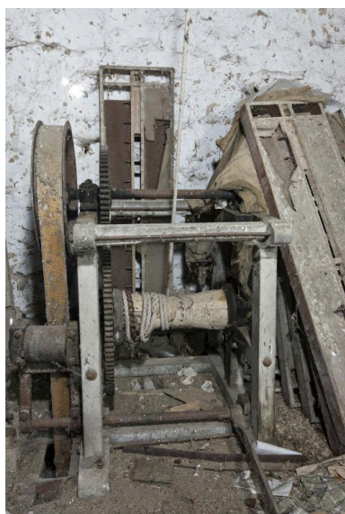
Comble du moulin, angle sud-est : poulie commandant le monte-sac intérieur vue depuis l'ouest. Phot. Yves Guillotin IVR52_20185300422NUCA
