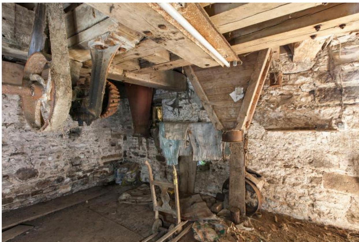
Rez-de-chaussée du moulin : vue depuis le nord-ouest des ensacheurs à farine. A gauche, l'axe horizontal et les courroies de transmission.
