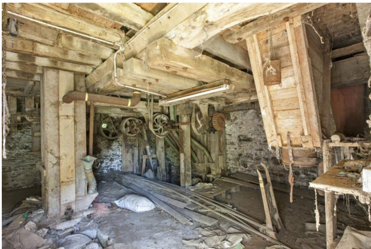
Rez-de-chaussée du moulin, vue d'ensemble depuis le sud-ouest : élévateurs à godets ouest, axe horizontal et courroies de transmission de la force motrice, un des ensacheurs à farine.
