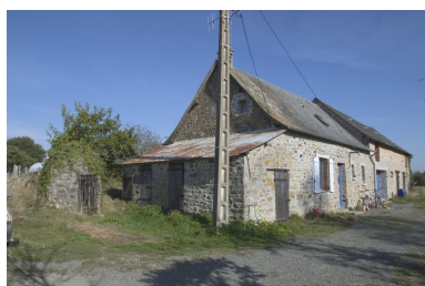
Vue d'ensemble du bâtiment depuis le sud. Phot. François Lasa IVR52_20045302533NUCA
