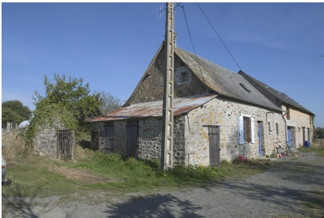
Vue d'ensemble du bâtiment depuis le sud.
