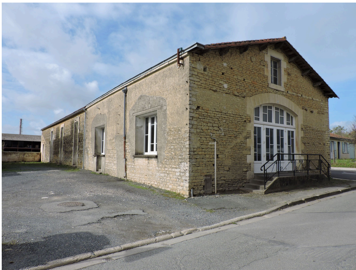
La salle vue depuis le sud-est.
