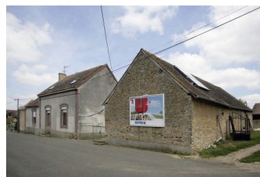
Ensemble depuis le sud. Phot. François Lasa IVR52_20077200774NUCA
