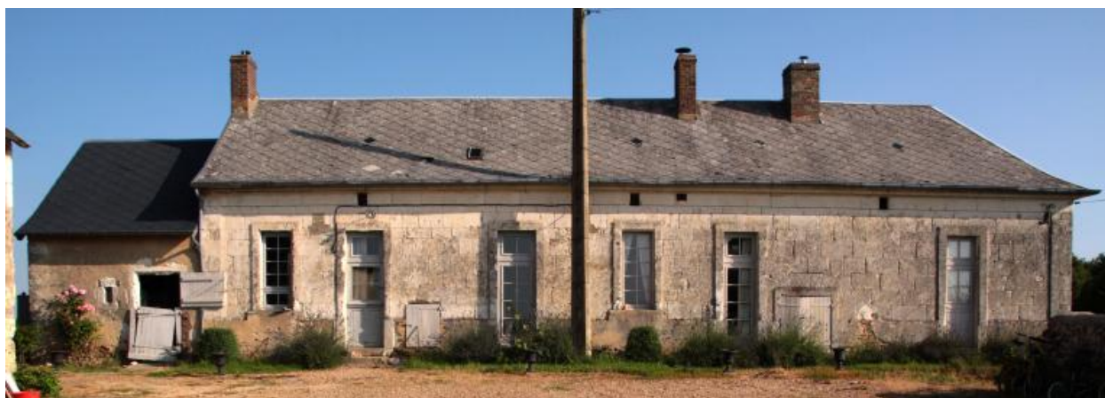
Maison : façade antérieure sur cour.
