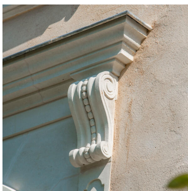
Un détail du larmier d'une fenêtre. Phot. Pierre-Bernard Fourny IVR52_20235300323NUCA
