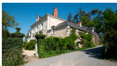
Le portail et la demeure. Phot. Pierre-Bernard Fourny IVR52_20235300311NUCA
