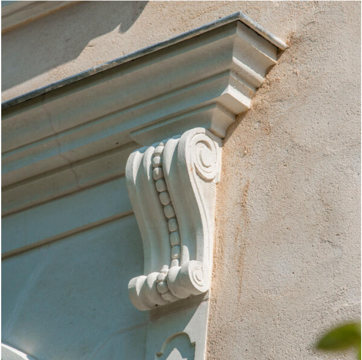
Un détail du larmier d'une fenêtre.
