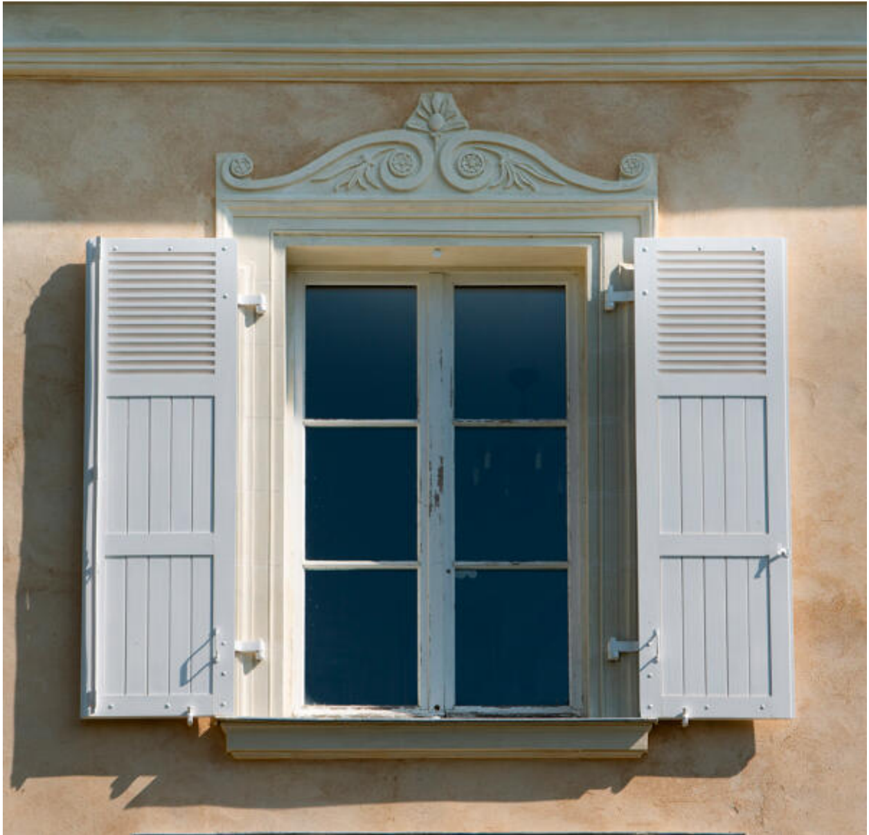
Un détail d'une fenêtre.
