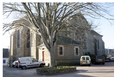
Vue de l'église depuis le nord-est. Phot. Denis Pillet IVR52_20084400232NUCA
