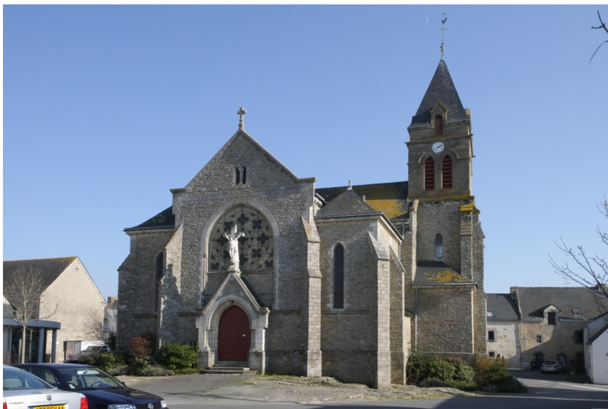
Vue de la façade occidentale.
