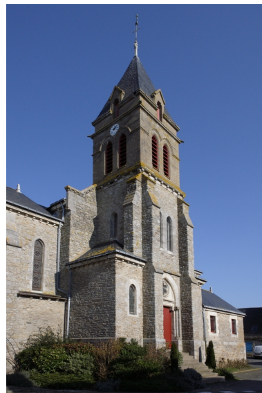
Vue du clocher et de la porte sud. Phot. Denis Pillet IVR52_20084400378NUCA
