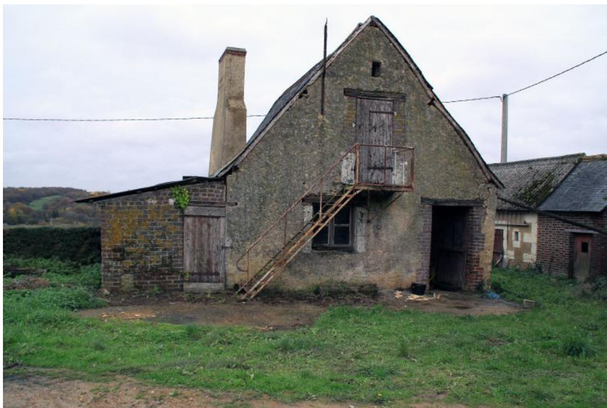
Vieille maison : pignon ouest reconstruit avec chaînage de grosses briques.
