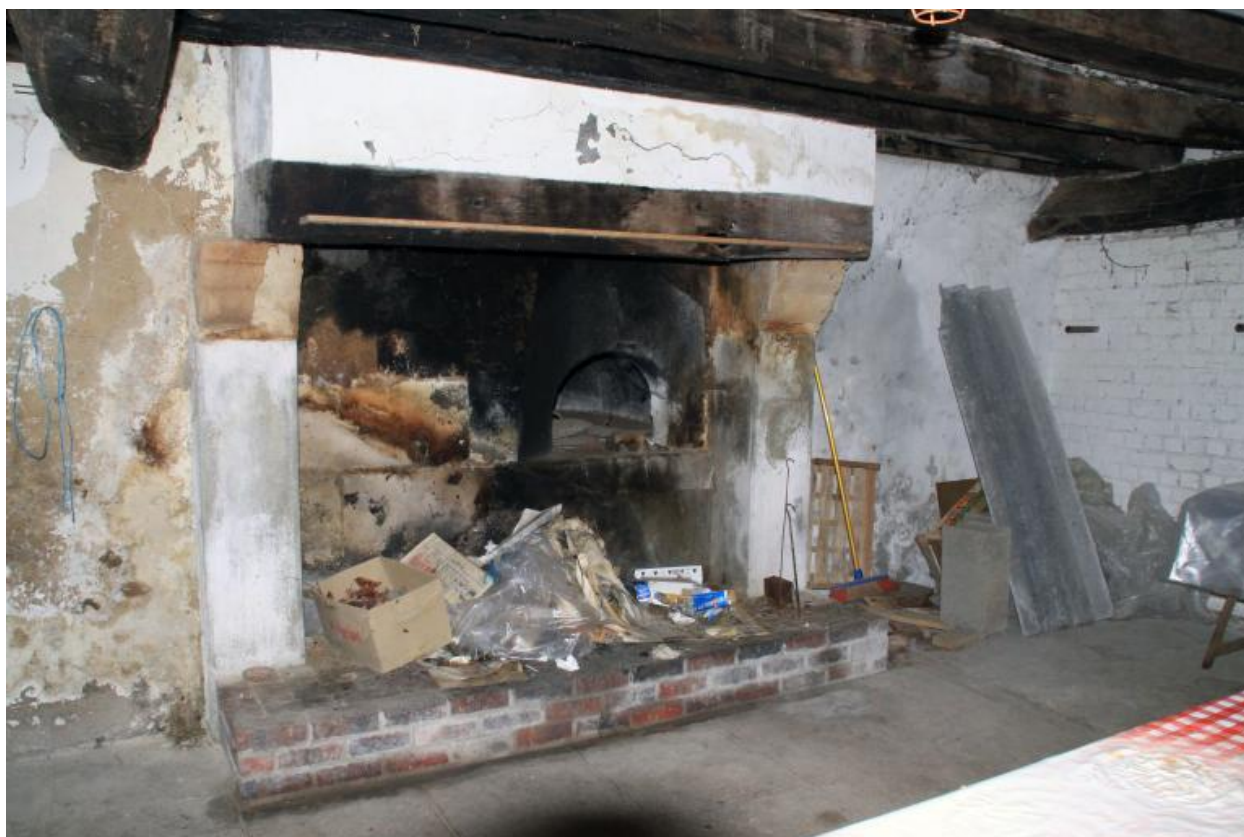
Vieille maison : cheminée sur mur goutterot remaniée.
