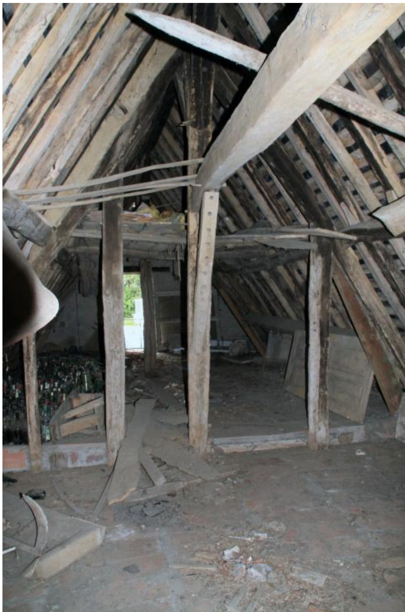
Vieille maison : charpente à pannes et vestiges d'un pignon à pan de bois mitoyen.
