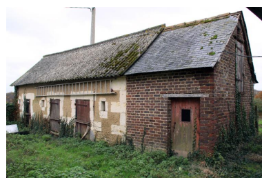
Dépendances à proximité de la vieille maison. Noter la juxtaposition des matériaux. Phot. Jean-Baptiste Darrasse IVR52_20097200937NUCA
