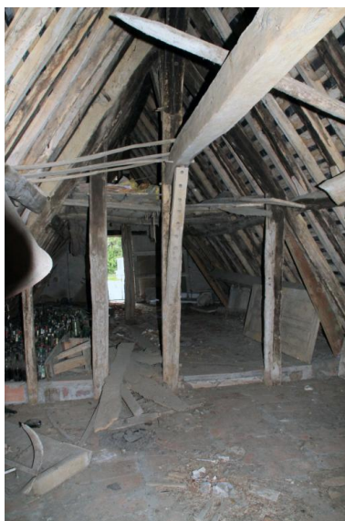
Vieille maison : charpente à pannes et vestiges d'un pignon à pan de bois mitoyen. Phot. Jean-Baptiste Darrasse IVR52_20097200926NUCA
