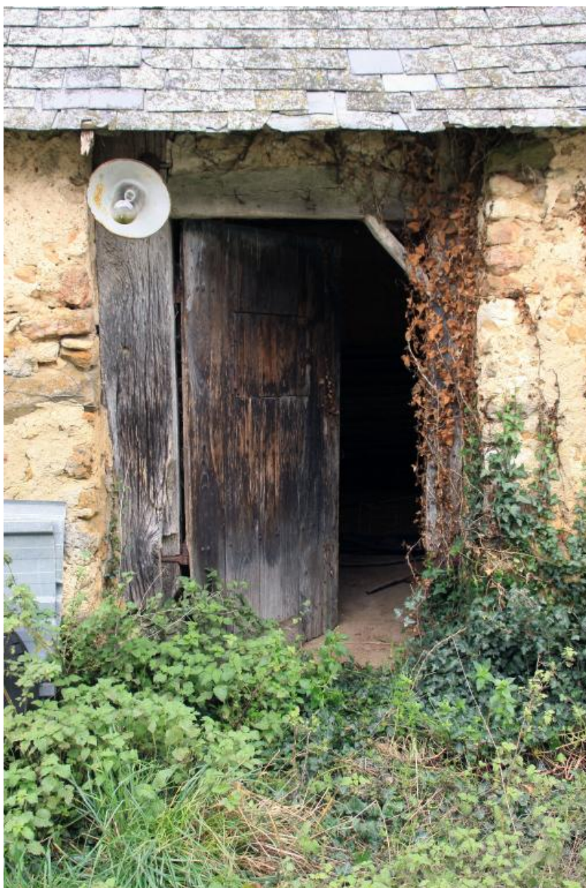
Vieille maison, façade sud, détail : porte.
