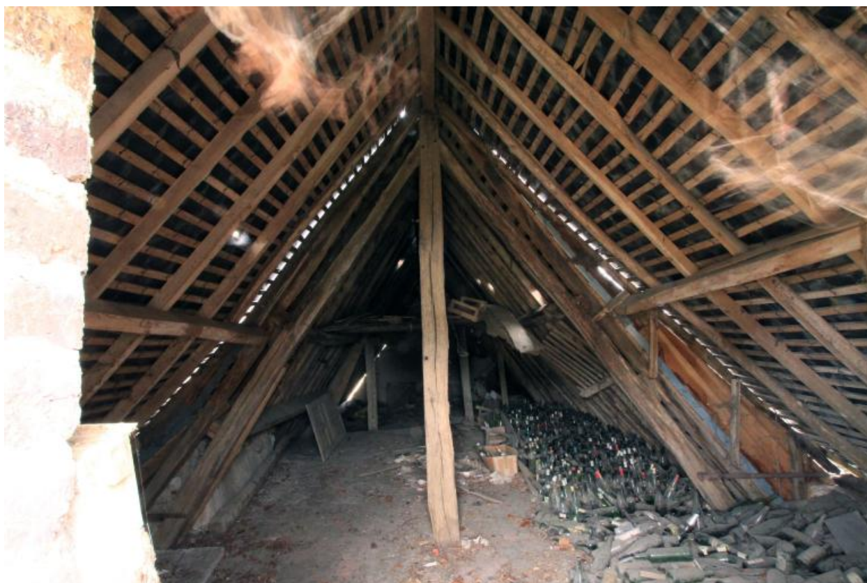
Vieille maison : charpente à pannes.
