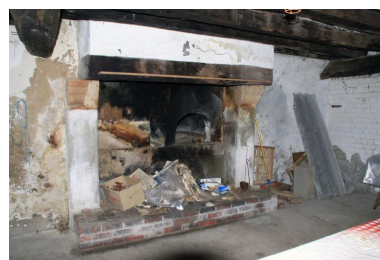
Vieille maison : cheminée sur mur goutterot remaniée. Phot. Jean-Baptiste Darrasse IVR52_20097200923NUCA
