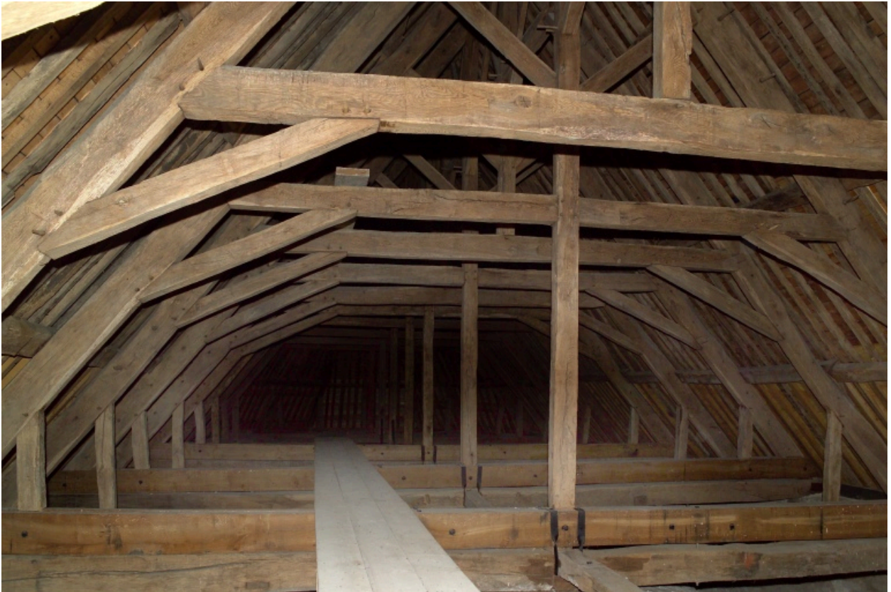
Charpente vue depuis l'ouest.
