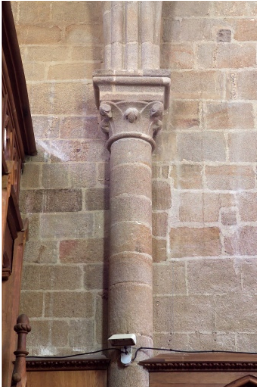
Mur nord, colonne n° 2, ancienne porte d'escalier vers les combles à l'ouest et collage à l'est.
