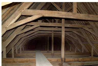
Charpente vue depuis l'ouest. Phot. Denis Pillet IVR52_20064402475NUCA
