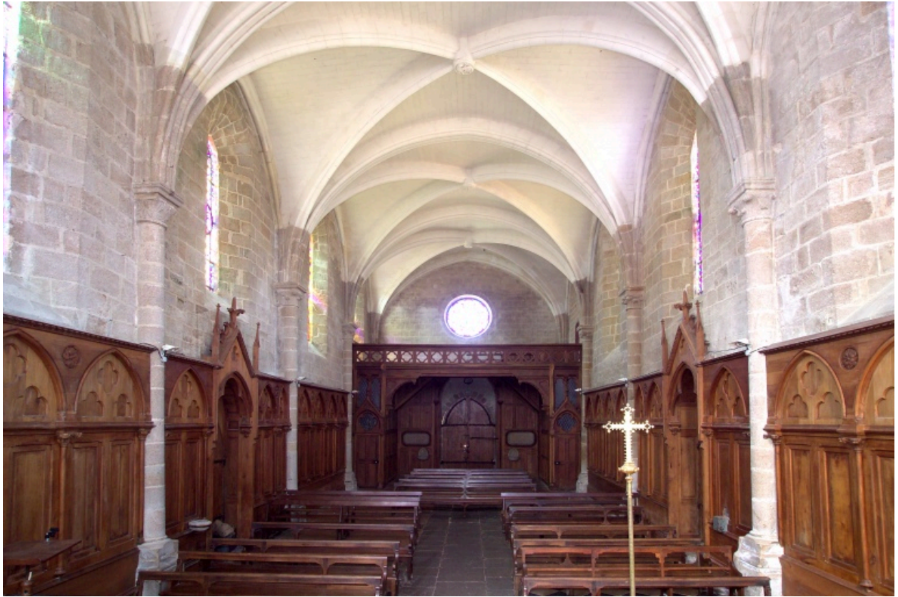
Vue générale intérieure prise du chœur vers l'ouest.
