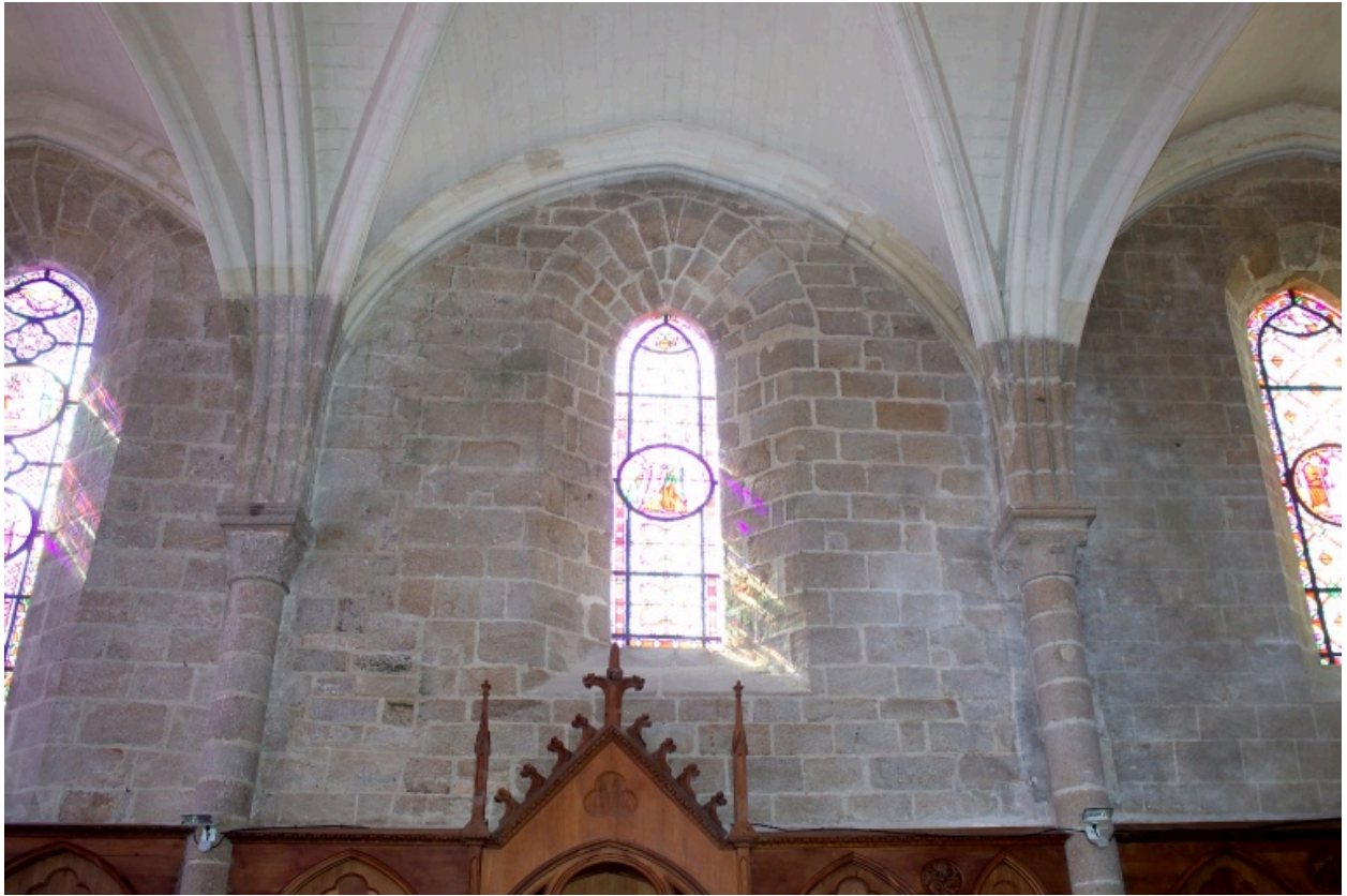
Mur sud, détail de la travée centrale.
