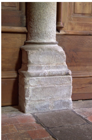
Détail d'une base de colonne de la nef. Phot. Denis Pillet IVR52_20064402467NUCA
