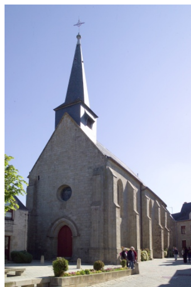
Vue générale de la façade occidentale et du mur sud. Phot. Denis Pillet IVR52_20064402443NUCA
