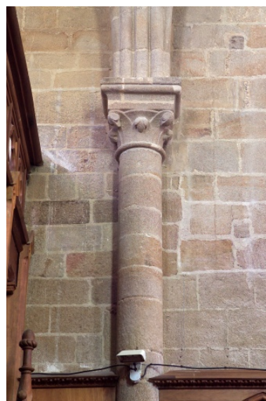
Mur nord, colonne n° 2, ancienne porte d'escalier vers les combles à l'ouest et collage à l'est. Phot. Denis Pillet IVR52_20064402468NUCA
