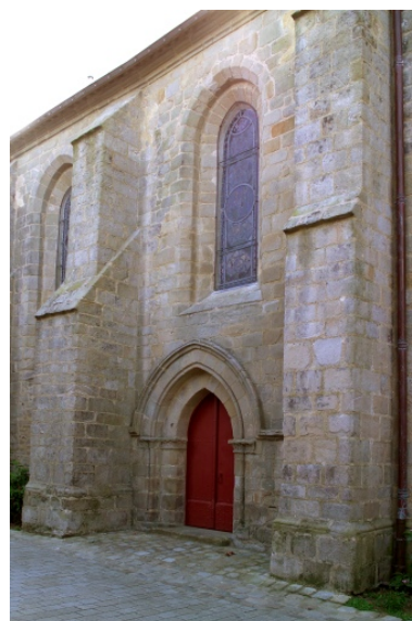
Mur nord, travée centrale : portail et baie. Phot. Denis Pillet IVR52_20064402486NUCA
