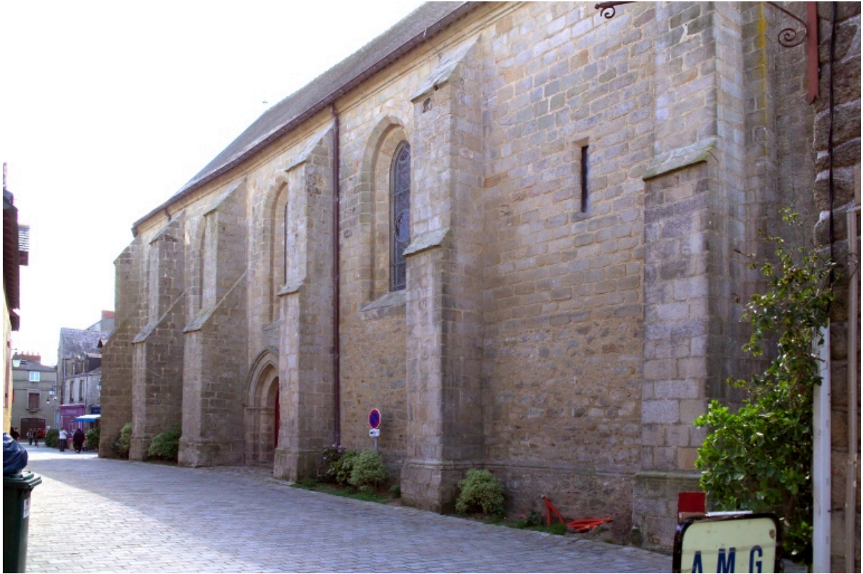
Vue du mur nord depuis le nord-ouest.
