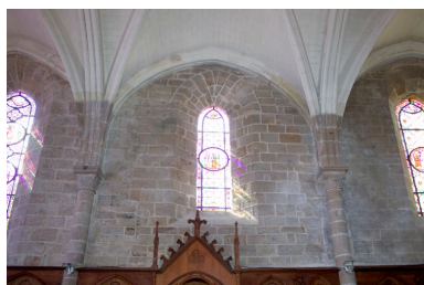
Mur sud, détail de la travée centrale. Phot. Denis Pillet IVR52_20064402470NUCA
