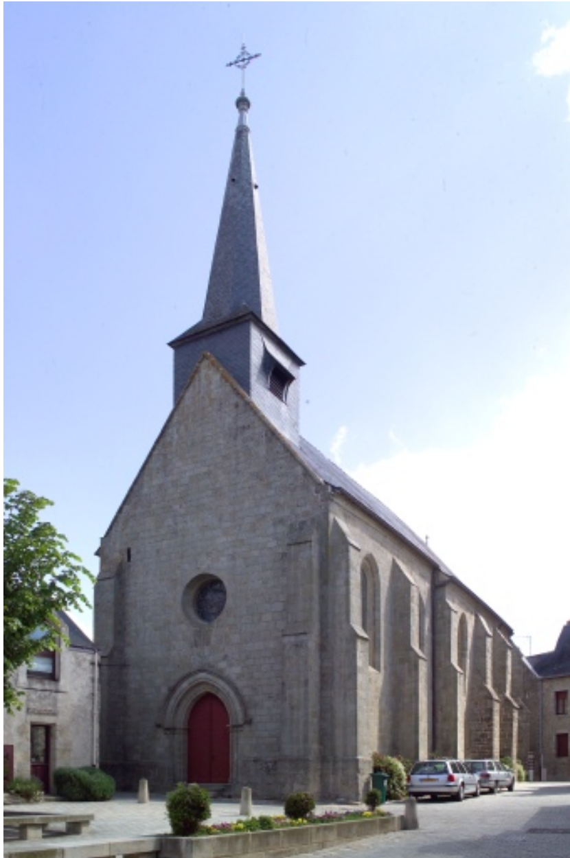
Façade occidentale et mur sud.
