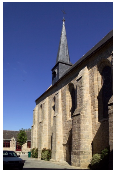
Mur sud et flèche vus depuis le sud-est. Phot. Denis Pillet IVR52_20064402444NUCA
