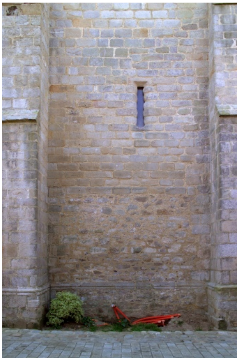
Mur nord, détail de la première travée.
