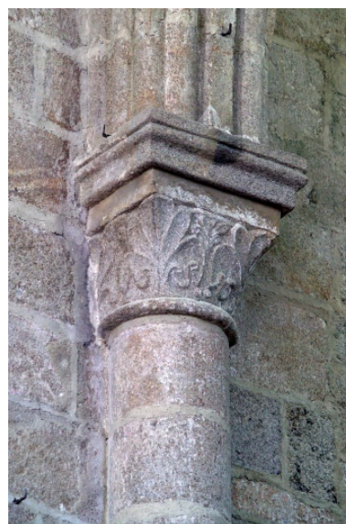
Détail d'un chapiteau du chœur. Phot. Denis Pillet IVR52_20064402463NUCA
