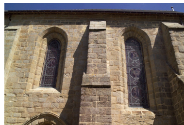
Mur sud, détail des baies des troisième et quatrième travées. Phot. Denis Pillet IVR52_20064402489NUCA
