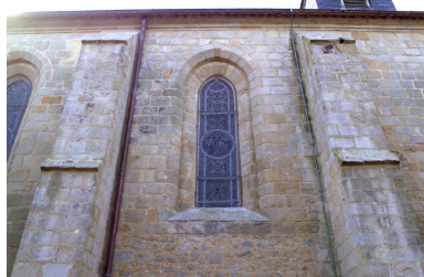
Mur nord, détail de la baie de la seconde travée. Phot. Denis Pillet IVR52_20064402483NUCA
