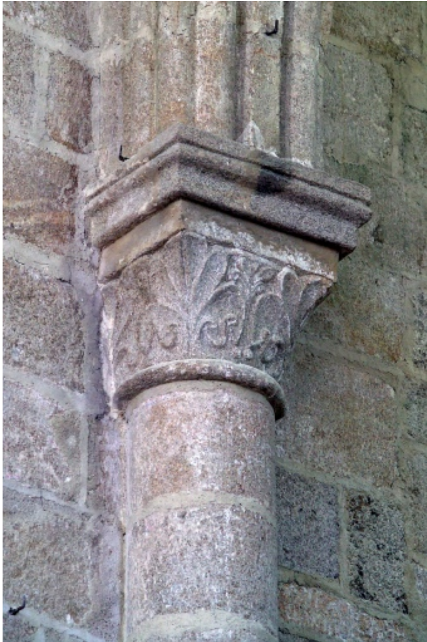
Détail d'un chapiteau du chœur.
