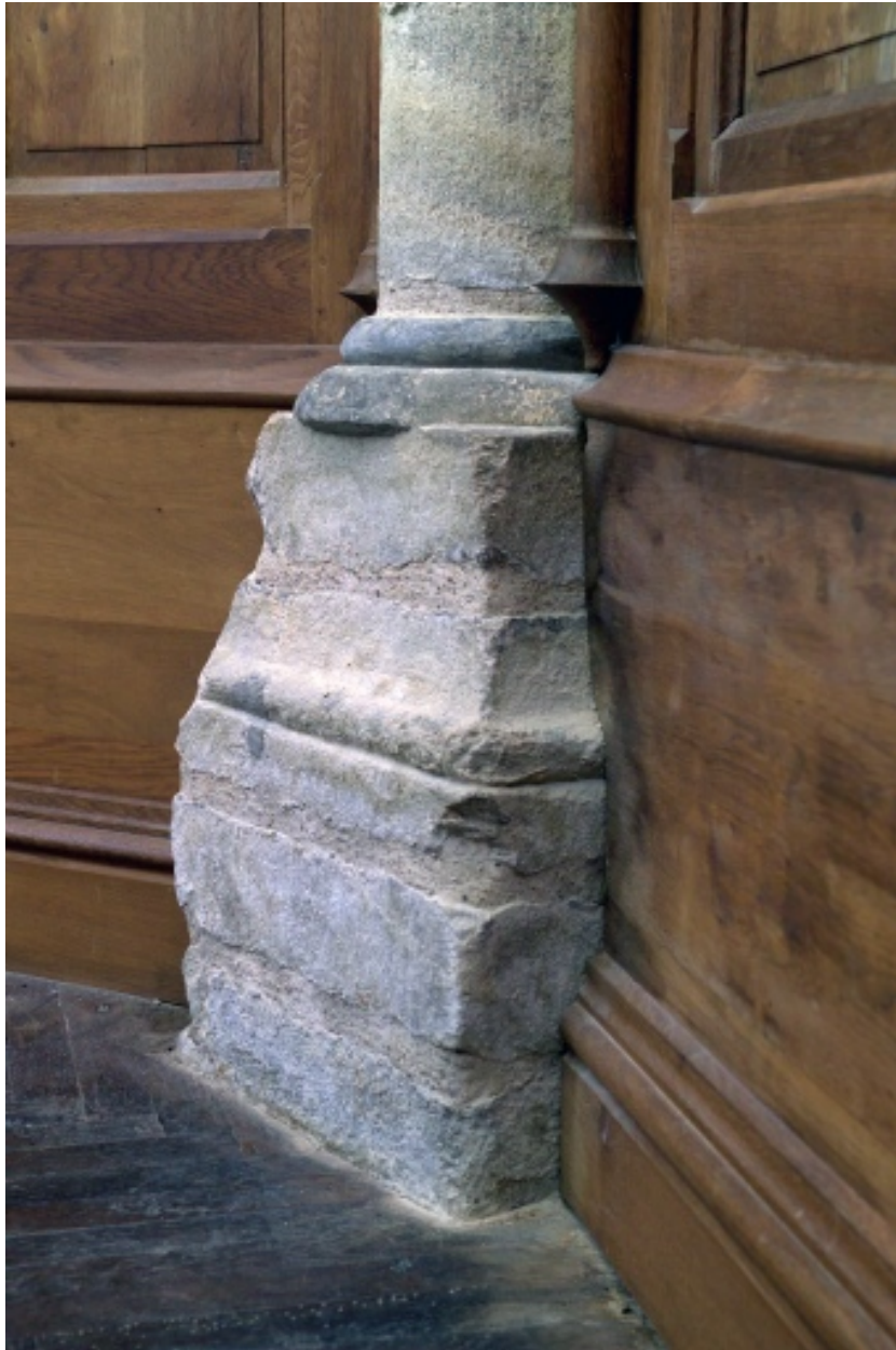
Détail d'une base de colonne du chœur.
