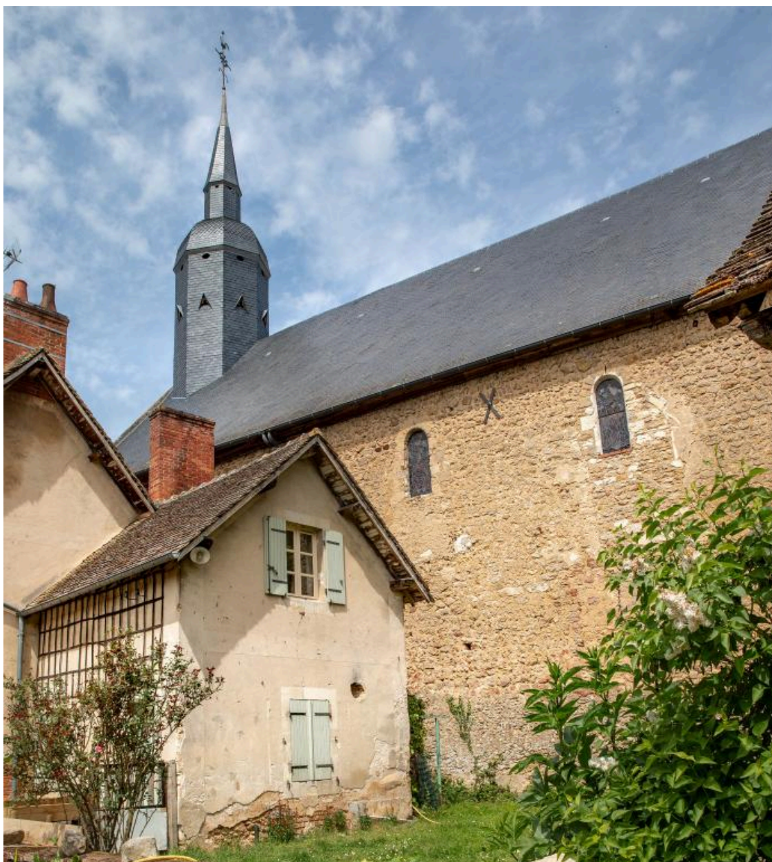
Le mur sud de la nef.
