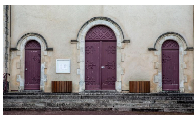
Les trois portes de la façade. Phot. Pierre-Bernard Fourny IVR52_20197200748NUCA
