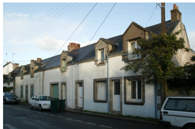
Vue générale des n°44-46 et 48 rue du Faubourg Bizienne. Phot. Denis Pillet IVR52_20064403024NUCA
