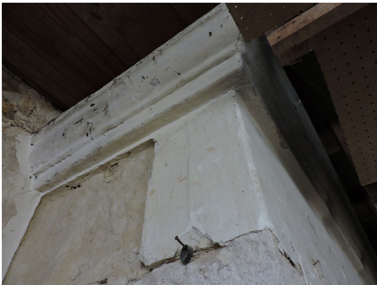
La hotte de la cheminée et sa corniche.
