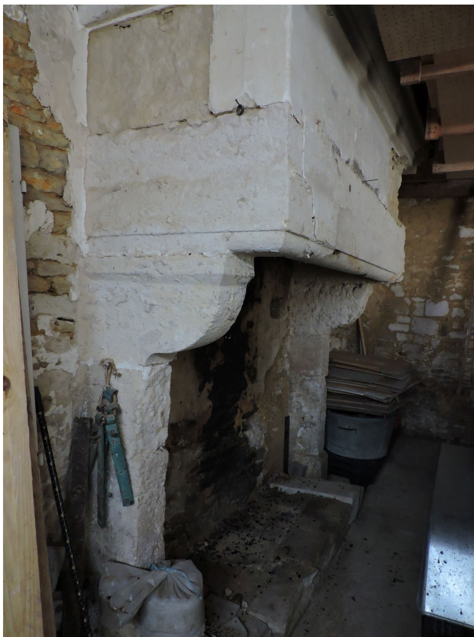
La cheminée dans la remise.
