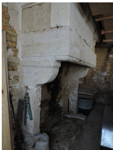
La cheminée dans la remise.
