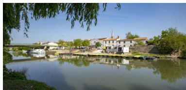
Le port vu depuis le sud. Phot. Pierre-Bernard Fourny IVR52_20228501084NUCA
