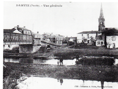
Le grand port vu depuis le sud vers 1910, après début de dégagement de ses abords à l'arrière-plan. Phot. Yannis (reproduction) Suire IVR52_20228501010NUCA
