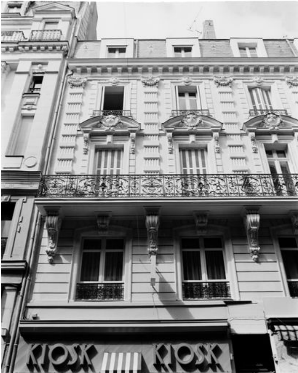
Elévation antérieure : travée gauche.
