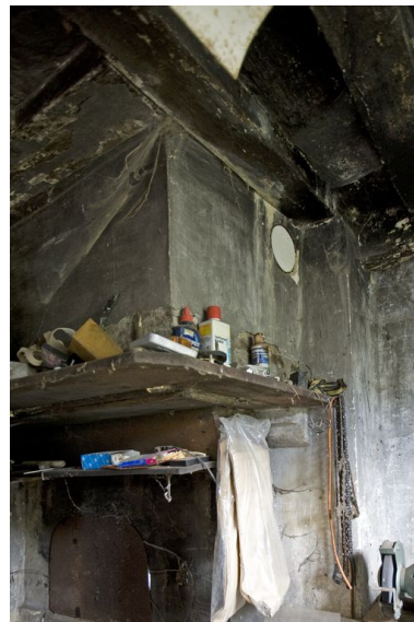
Détail de la cheminée de la pièce à feu de la maison 2. Phot. François Lasa IVR52_20087201417NUCA
