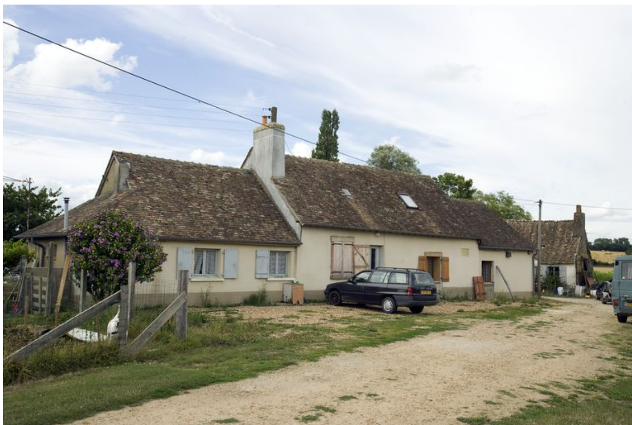
Maison 1, vue générale depuis le sud-est.
