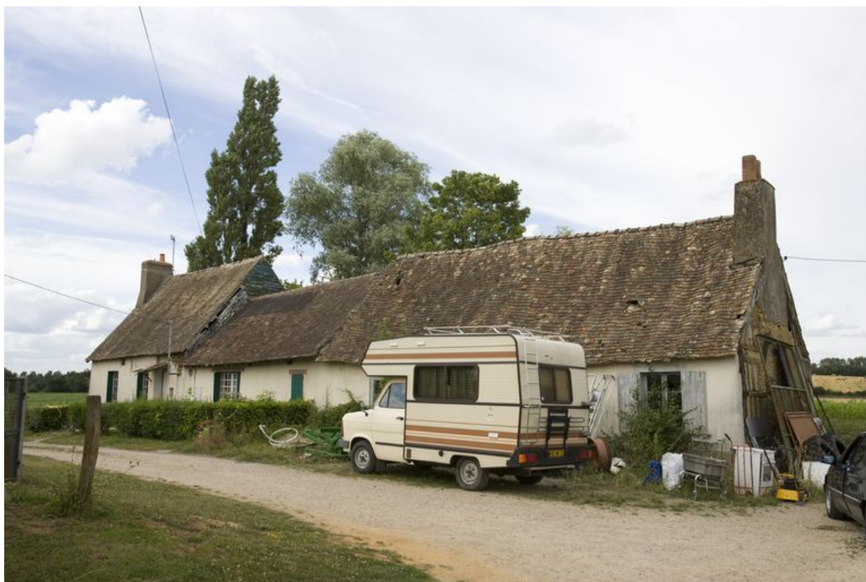
Maisons 2 et 3, vue générale depuis le sud.
