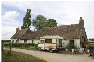
Maisons 2 et 3, vue générale depuis le sud. Phot. François Lasa IVR52_20087201419NUCA
