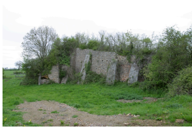
La rampe du four vue depuis le sud. Phot. François Lasa IVR52_20045301438NUCA
