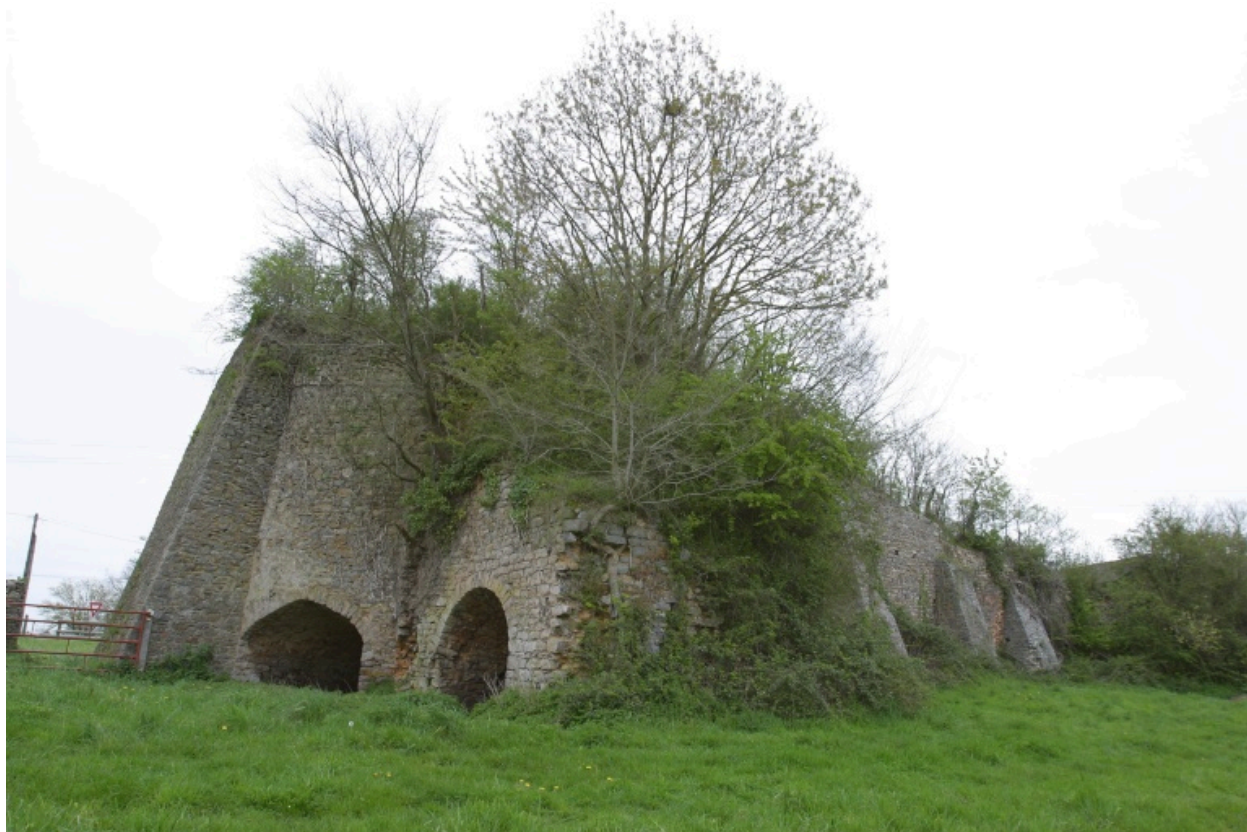
Le four vu depuis le sud-ouest.
