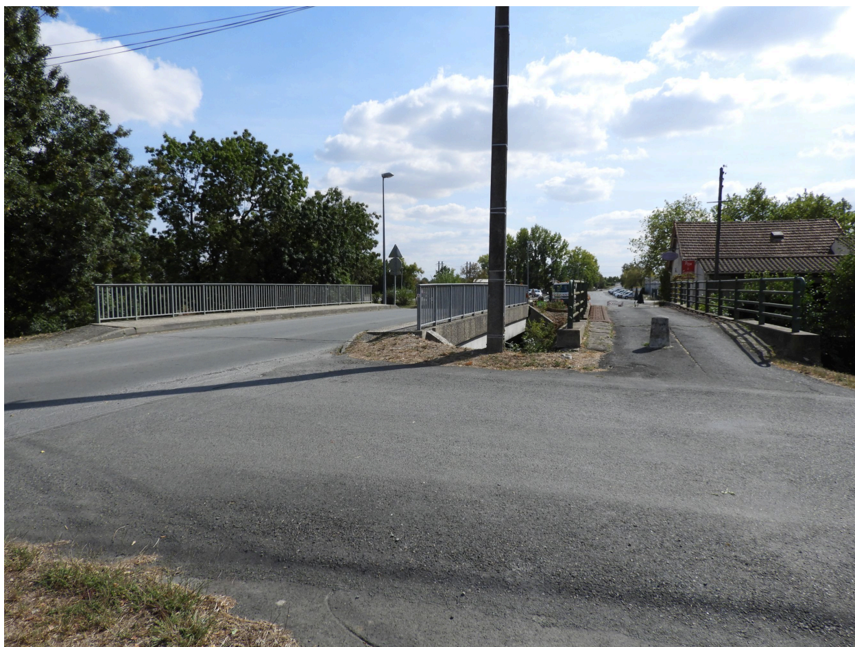
L'ancien pont sur le canal de Vix, à droite, et le nouveau pont, à gauche, vus depuis le nord.
