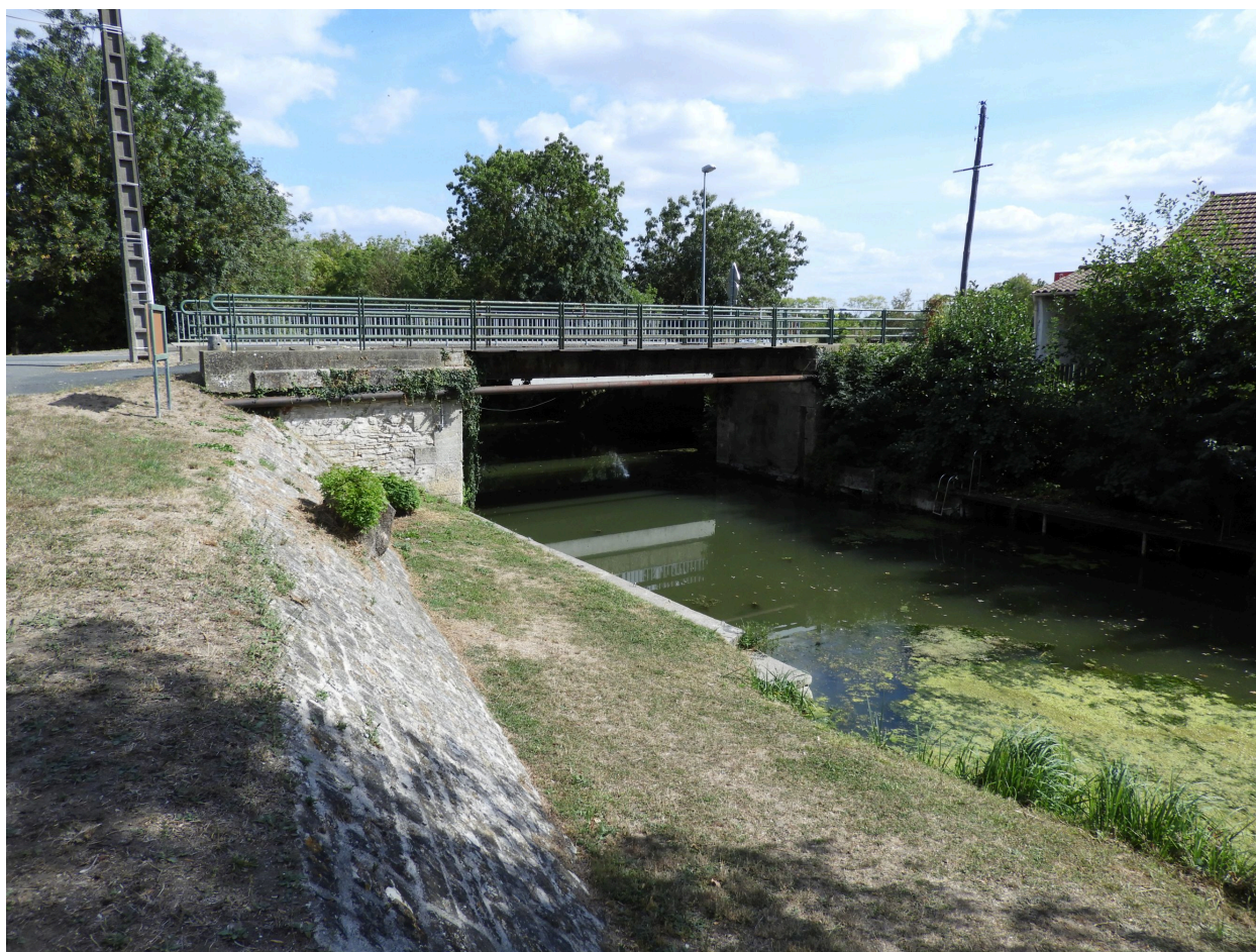
Le pont sur le Contrebot et, au premier plan, la cale, vus depuis le nord-ouest, en aval.
