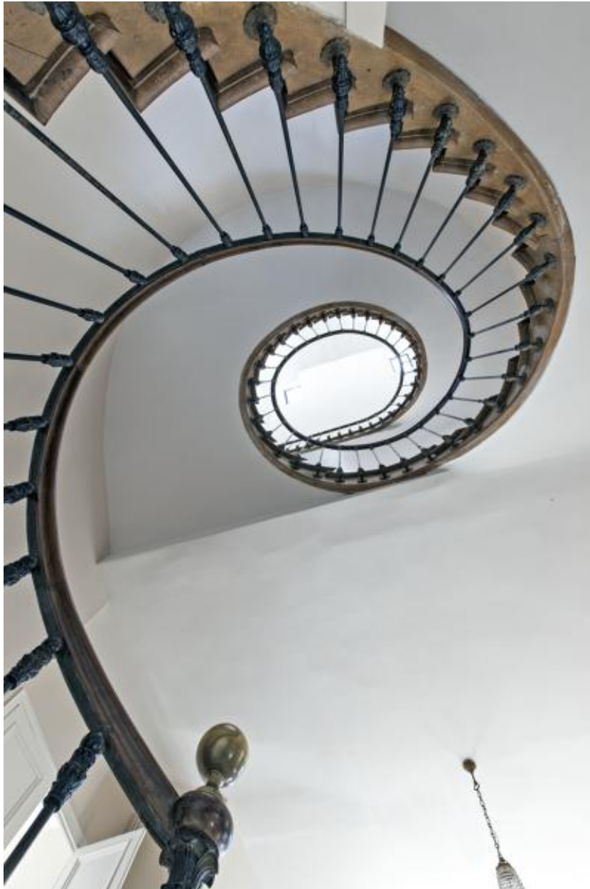
Escalier principal, vu du dessous.
