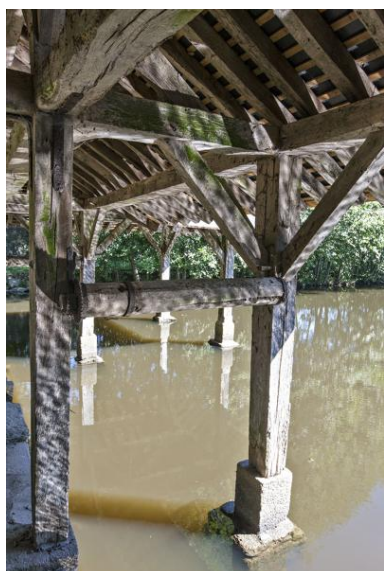
Lavoir du château de la Drouardière. Phot. Yves Guillotin IVR52_20185300372NUCA
