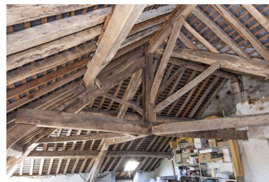
Charpente du château de la Drouardière. Phot. Yves Guillotin IVR52_20185300365NUCA
