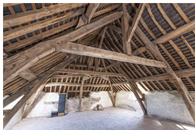
Charpente du château de la Drouardière. Phot. Yves Guillotin IVR52_20185300363NUCA
