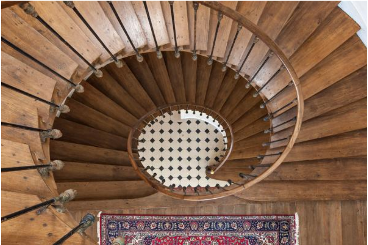
Escalier principal, vue du dessus.
