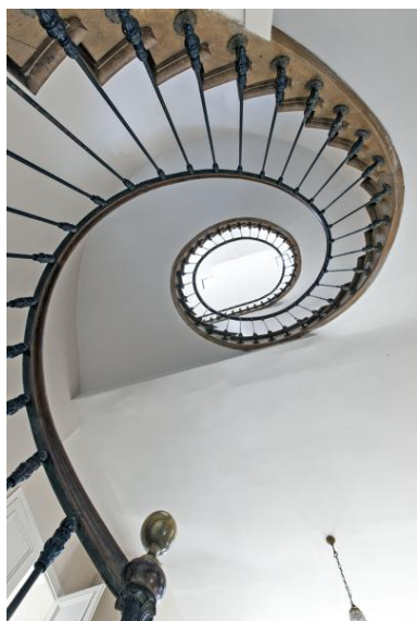
Escalier principal, vu du dessous. Phot. Yves Guillotin IVR52_20185300360NUCA
