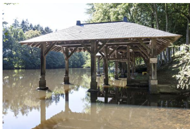
Lavoir du château de la Drouardière. Phot. Yves Guillotin IVR52_20185300371NUCA
