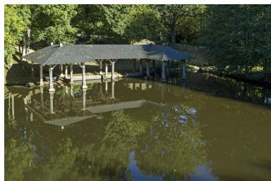
Lavoir du château de la Drouardière. Phot. Yves Guillotin IVR52_20185300357NUCA
