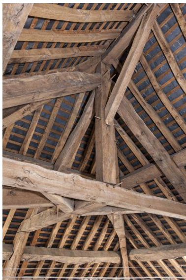
Charpente du château de la Drouardière. Phot. Yves Guillotin IVR52_20185300364NUCA
