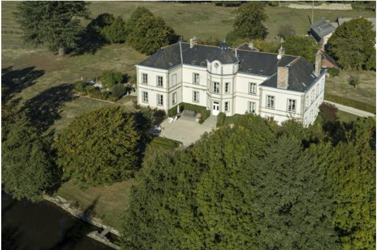
Château vu du nord-est.
