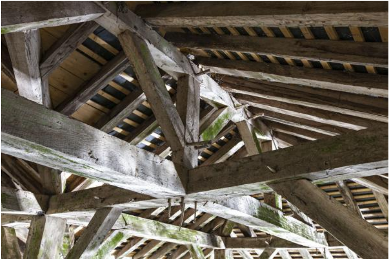
Charpente du lavoir de la Drouardière.
