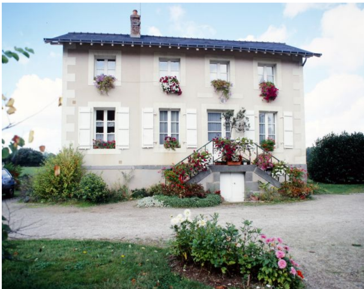
La maison éclusière.
