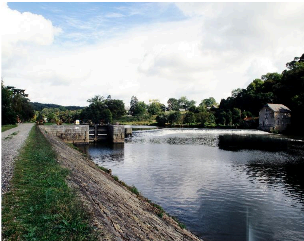
Vue d'ensemble depuis le chemin de halage, rive droite, en aval : écluse, barrage, moulin.
