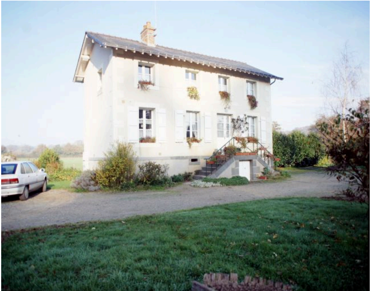
La maison éclusière, vue de trois-quart.
