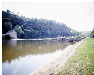
Vue d'ensemble depuis le chemin de halage, rive droite, en amont : moulin, barrage, moulin.
