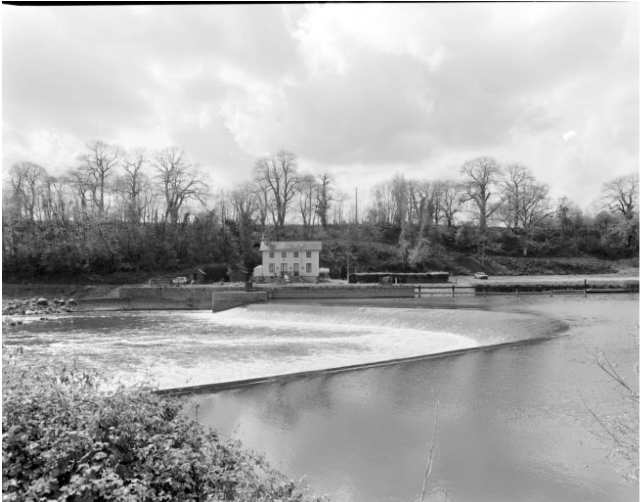
Vue d'ensemble depuis le moulin sur la rive gauche : barrage, écluse, maison éclusière.
