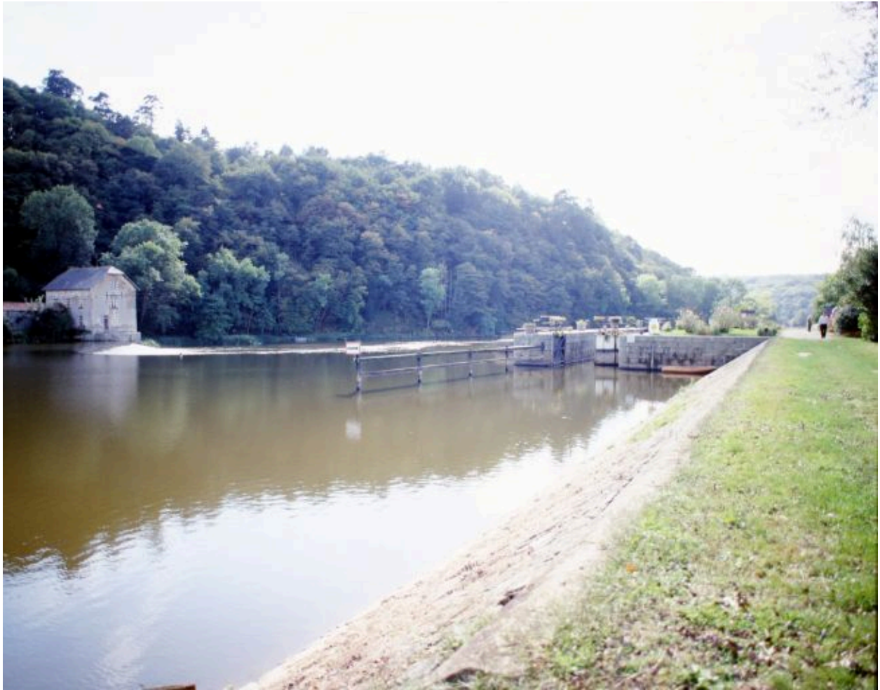
Vue d'ensemble depuis le chemin de halage, rive droite, en amont : moulin, barrage, moulin.
