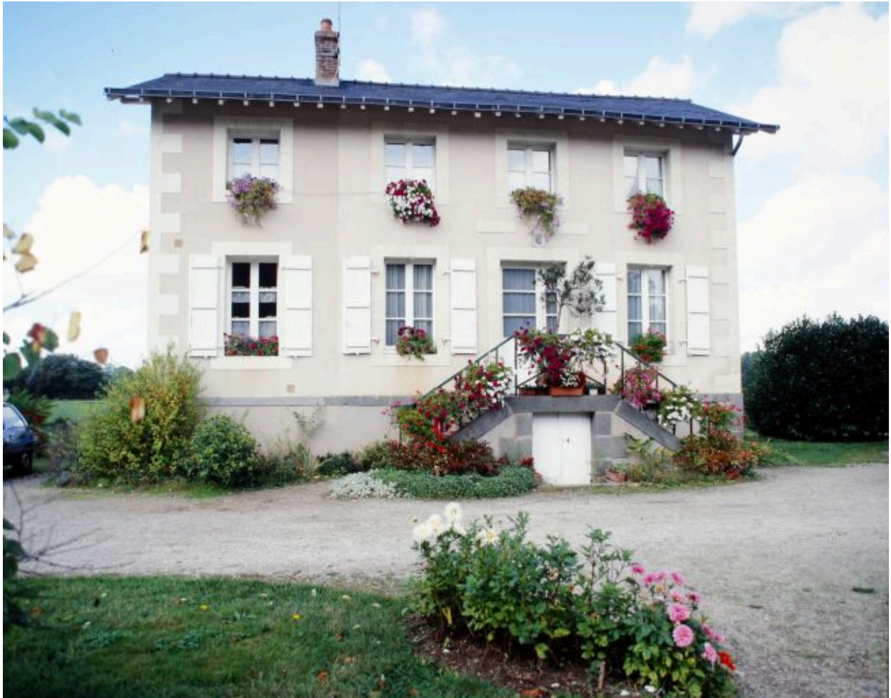
La maison éclusière.
