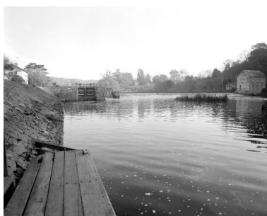
Vue d'ensemble depuis le ponton situé rive droite, en aval : maison éclésièr, écluse, pertuis, barrage, moulin.
