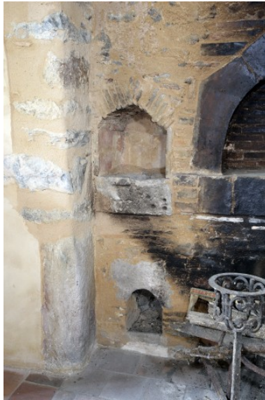
Aile postérieure, pièce ouest, détail de la cheminée : potager. Phot. François Lasa IVR52_20075301769NUCA
