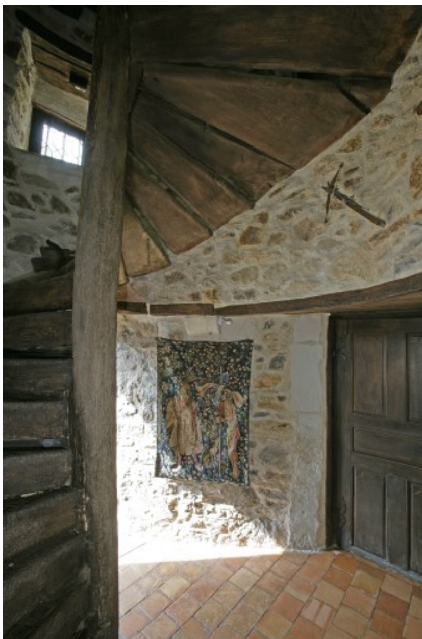
L'escalier vu depuis le seuil de la porte donnant accès au rez-de-chaussée du pavillon.
