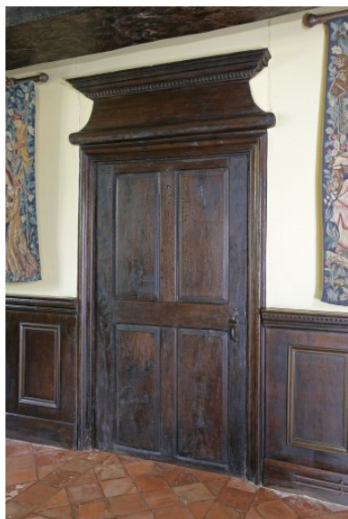
Corps sud du logis, pièce est : la porte d'accès à la pièce ouest. Phot. François Lasa IVR52_20075301762NUCA
