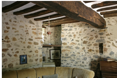
Corps nord du logis : angle nord de la pièce. Phot. François Lasa IVR52_20075301781NUCA
