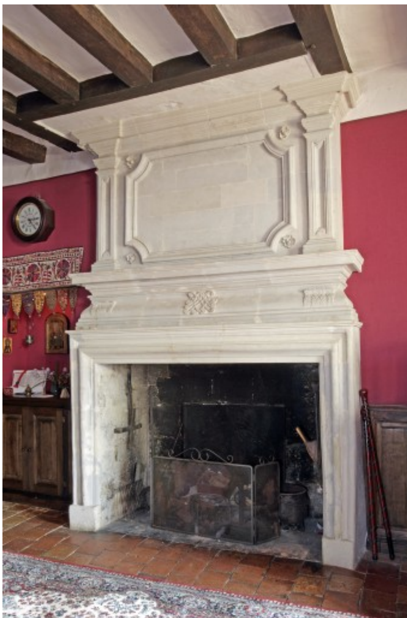
Pavillon du logis, rez-de-chaussée : la cheminée.
