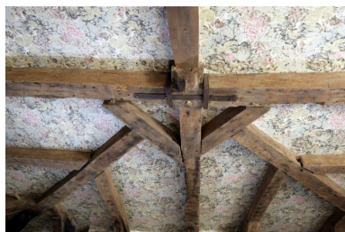
Pavillon du logis, étage de comble : détail de la charpente. Phot. François Lasa IVR52_20075301776NUCA
