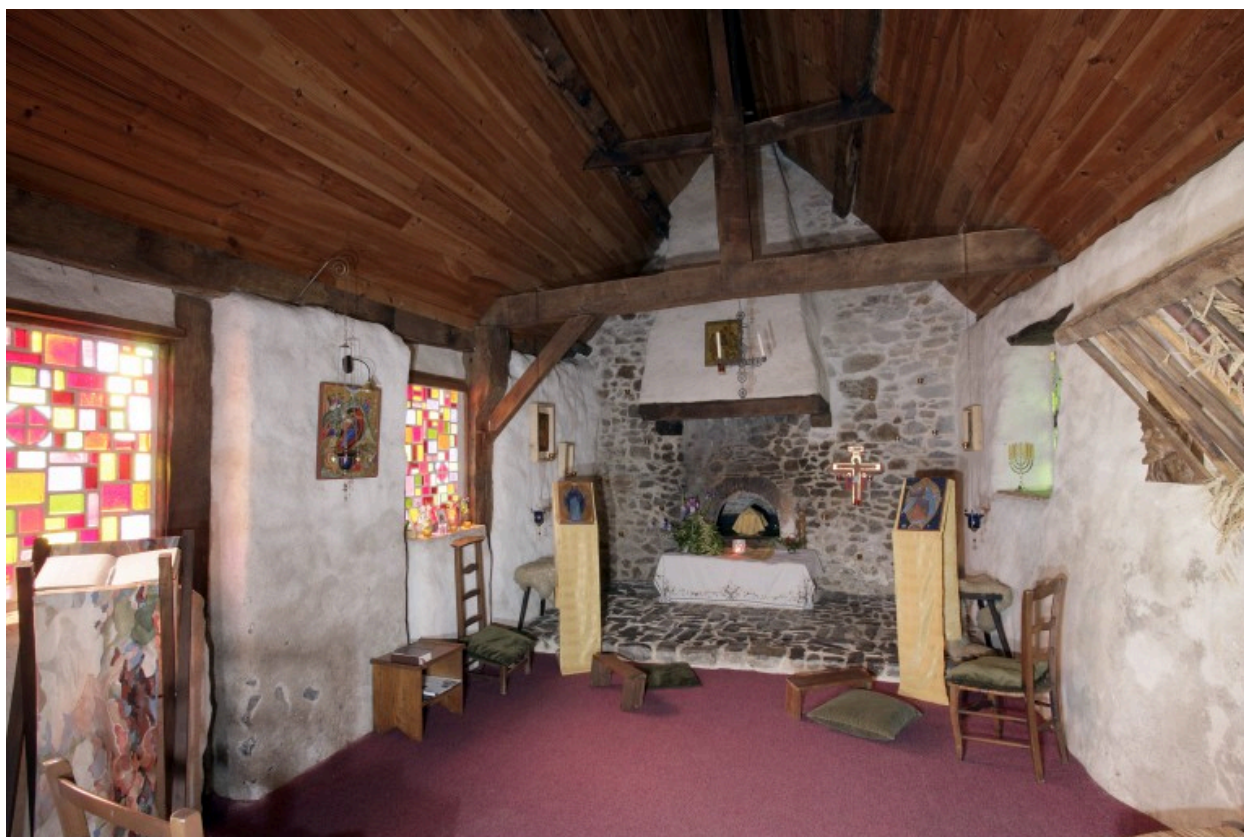
Dépendance sud, partie est : première ferme de charpente sur poteau.
