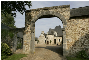
Le porche et le logis vus depuis le jardin à l'est. Phot. François Lasa IVR52_20075301748NUCA
