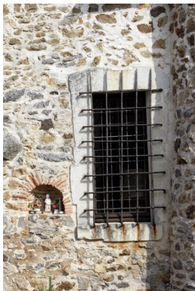
Détail du corps sud vu depuis la cour principale : la fenêtre du mur-pignon.
