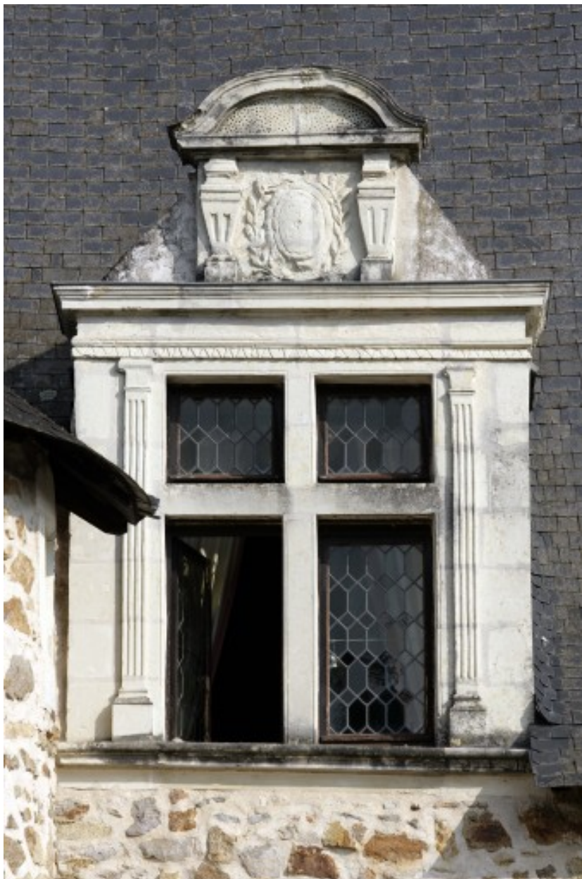
Détail du pavillon vu depuis la cour principale : la lucarne éclairant l'étage de comble.
