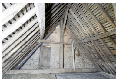
Corps sud du logis, comble : la charpente. Phot. François Lasa IVR52_20075301778NUCA
