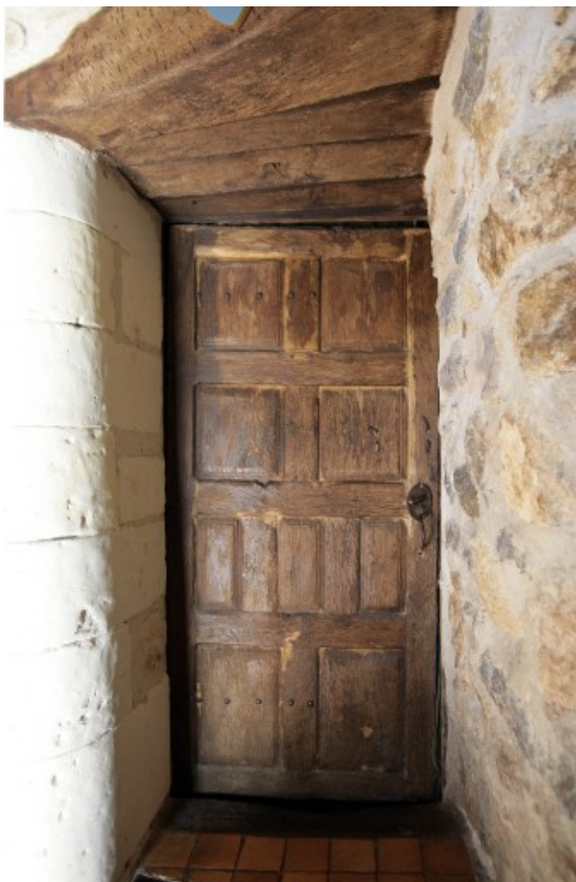
La porte intérieure d'accès au rez-de-chaussée du pavillon, vue depuis l'escalier
