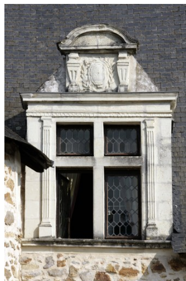
Détail du pavillon vu depuis la cour principale : la lucarne éclairant l'étage de comble. Phot. François Lasa IVR52_20075301744NUCA
