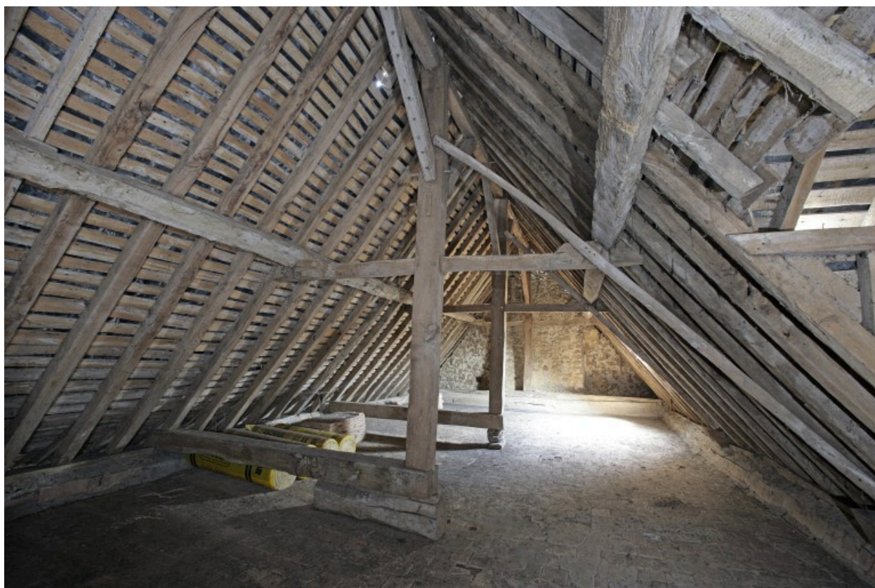
Aile postérieure, comble : la charpente.
