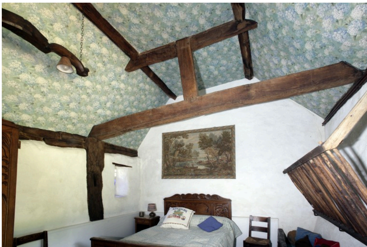
Dépendance sud, partie centrale : troisième ferme de charpente sur poteau.
