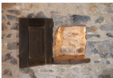
Corps sud du logis, pièce est : niche percée dans le mur sud. Phot. François Lasa IVR52_20075301760NUCA
