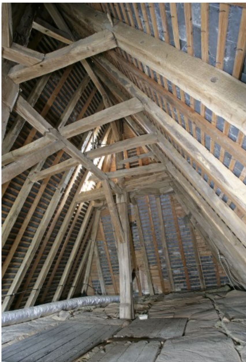
Pavillon du logis, 2e niveau du comble : la partie supérieure de la charpente.
