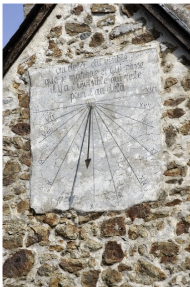
Détail du pignon du corps sud : le cadran solaire.
