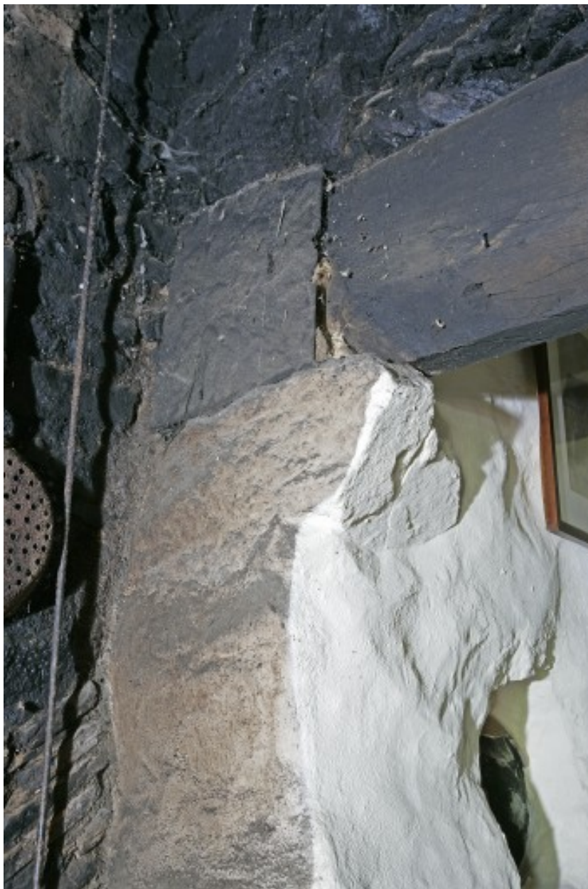
Corps sud du logis, pièce ouest, détail de la cheminée : le corbeau droit.
