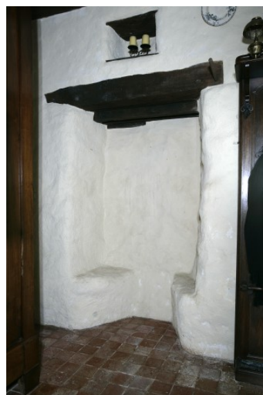
Corps sud du logis, pièce ouest : la fenêtre bouchée à coussièges. Phot. François Lasa IVR52_20075301767NUCA
