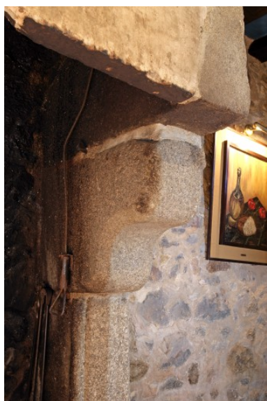
Corps sud du logis, pièce est : le corbeau droit de la cheminée. Phot. François Lasa IVR52_20075301759NUCA
