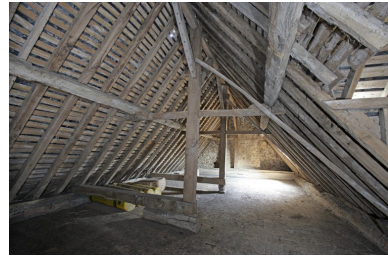
Aile postérieure, comble : la charpente. Phot. François Lasa IVR52_20075301779NUCA
