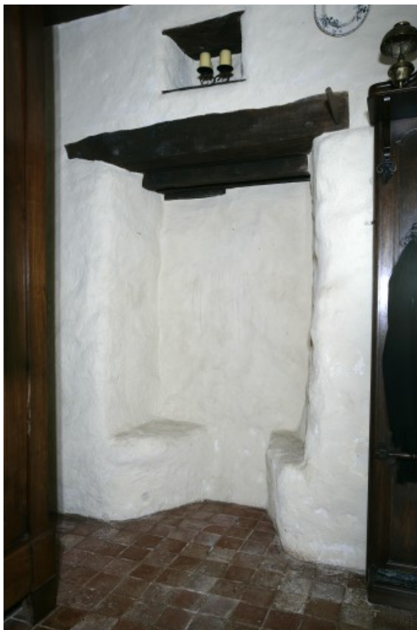
Corps sud du logis, pièce ouest : la fenêtre bouchée à coussièges.
