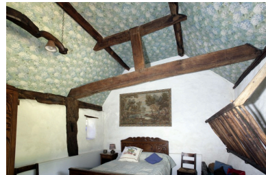
Dépendance sud, partie centrale : troisième ferme de charpente sur poteau. Phot. François Lasa IVR52_20075301755NUCA
