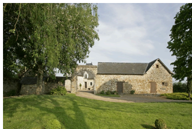
Vue d'ensemble depuis le jardin à l'est : le porche et la dépendance nord. Au fond le logis manorial. Phot. François Lasa IVR52_20075301747NUCA
