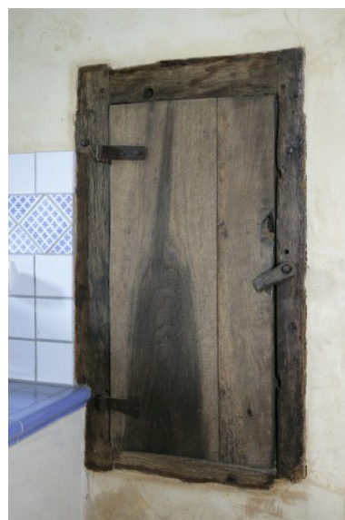
Aile postérieure, pièce est : placard aménagé dans le mur ouest. Phot. François Lasa IVR52_20075301770NUCA
