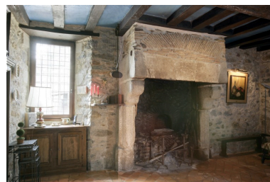
Corps sud du logis, pièce est : la cheminée. Phot. François Lasa IVR52_20075301758NUCA
