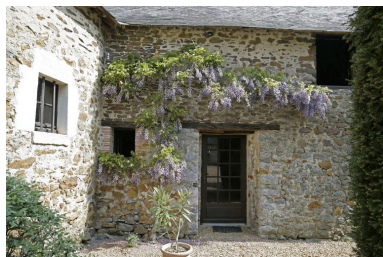
Vue partielle, depuis la cour principale, du corps nord du logis et de la dépendance nord.
