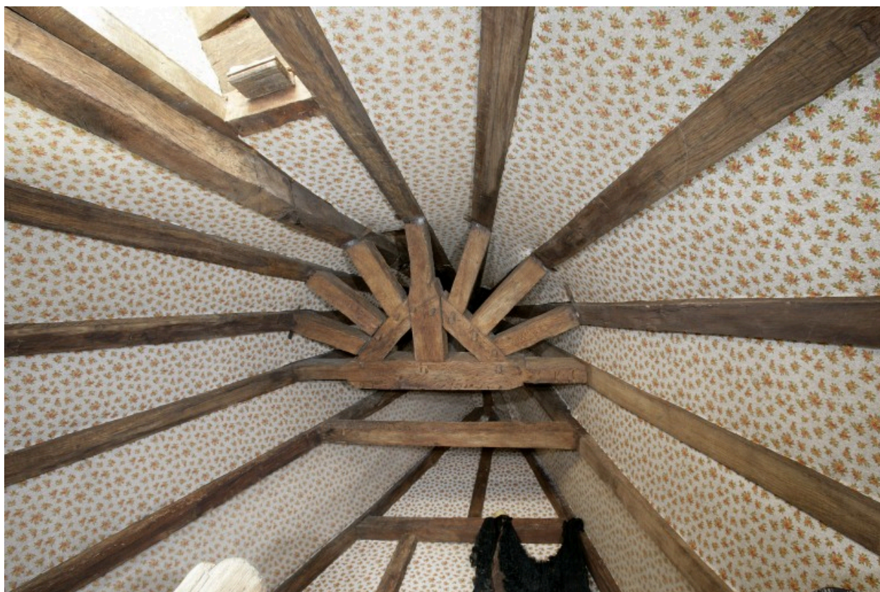
La charpente de la tour d'escalier.
