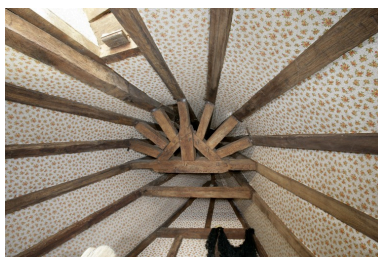
La charpente de la tour d'escalier. Phot. François Lasa IVR52_20075301774NUCA
