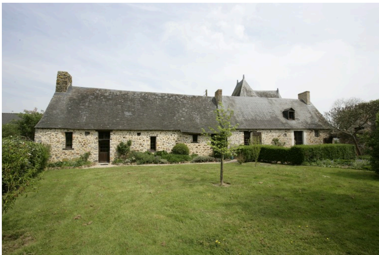
L'aile postérieure et le corps sud du logis vus depuis le jardin au sud.
