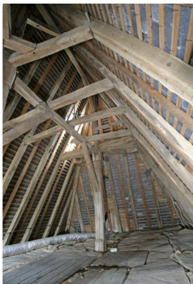
Pavillon du logis, 2e niveau du comble : la partie supérieure de la charpente. Phot. François Lasa IVR52_20075301777NUCA
