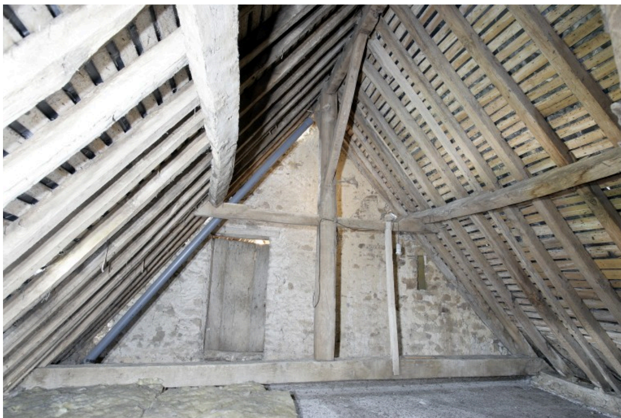
Corps sud du logis, comble : la charpente.
