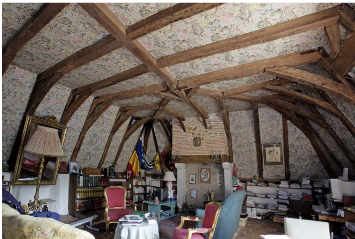
Pavillon du logis, étage de comble : vue d'ensemble.
