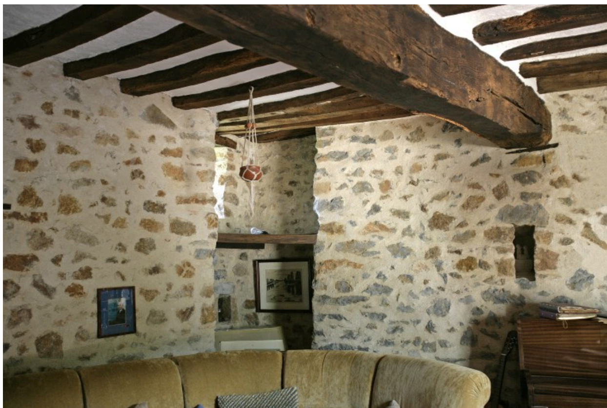
Corps nord du logis : angle nord de la pièce.
