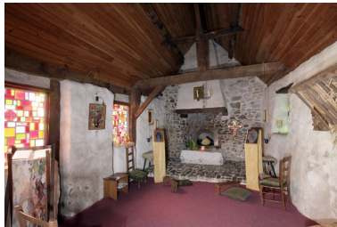
Dépendance sud, partie est : première ferme de charpente sur poteau. Phot. François Lasa IVR52_20075301754NUCA
