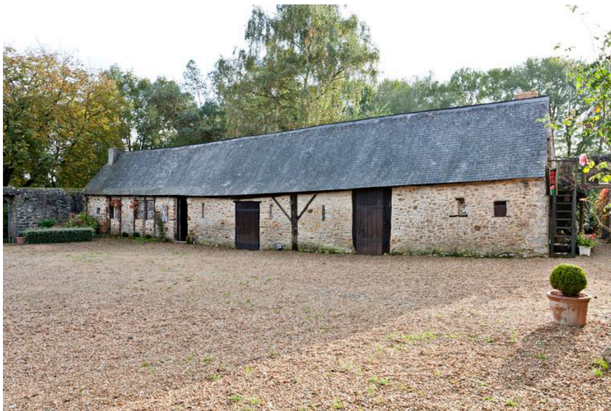
La dépendance sud vue depuis la cour principale.
