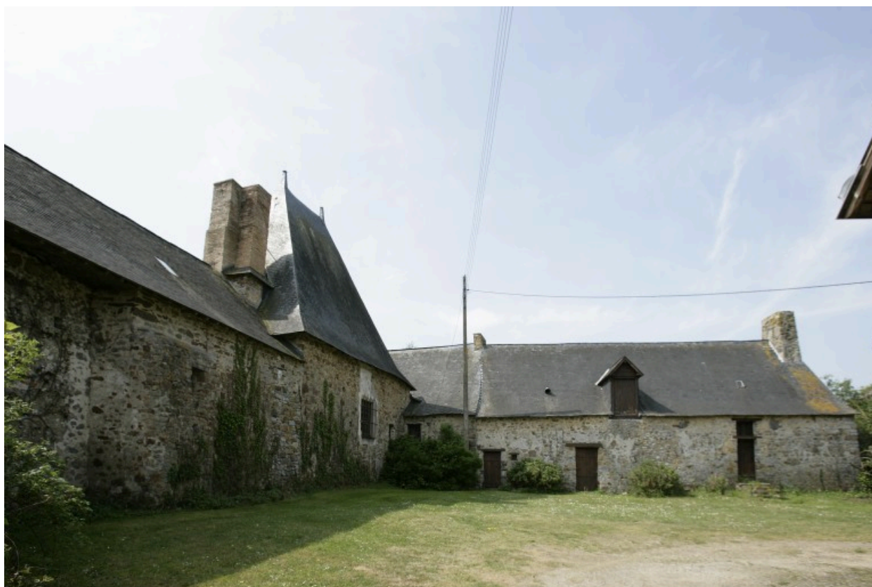
L'extrémité de la dépendance nord, le corps nord, le pavillon et l'aile postérieure vus depuis la cour de ferme.
