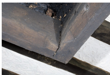
Corps sud du logis, pièce ouest, détail de la cheminée : assemblage du manteau. Phot. François Lasa IVR52_20075301766NUCA
