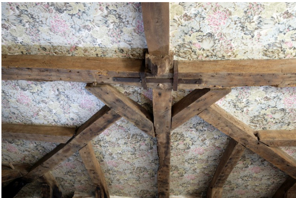
Pavillon du logis, étage de comble : détail de la charpente.
