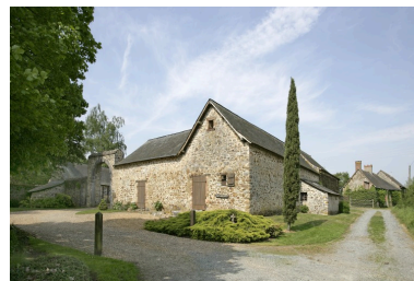
La dépendance nord et le porche vus depuis le chemin à l'est.
