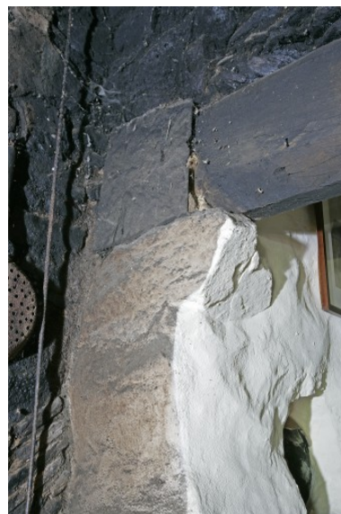
Corps sud du logis, pièce ouest, détail de la cheminée : le corbeau droit. Phot. François Lasa IVR52_20075301765NUCA
