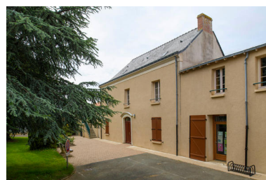
Ancien presbytère de Beausse, vue de la façade sud. Phot. Xaël Despré, Phot. Armelle Maugin IVR52_20214900326NUCA
