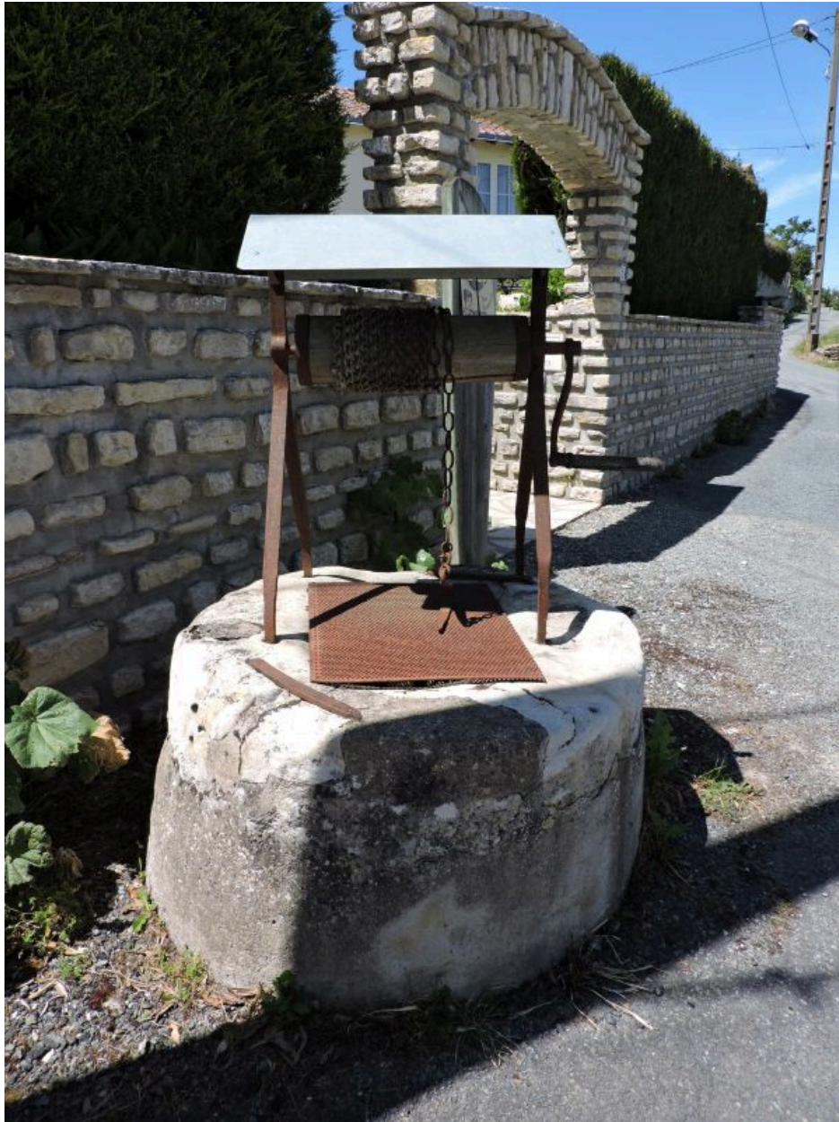
Le puits vu depuis le sud-est.
