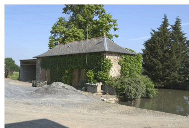
La porcherie. Phot. François Lasa IVR52_20045301841NUCA
