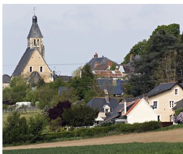
L'église paroissiale dans son environnement. Phot. Pierre-Bernard Fourny IVR52_20147200211NUCA
