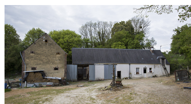
La Roche : une ferme. Phot. Pierre-Bernard Fourny IVR52_20147200150NUCA
