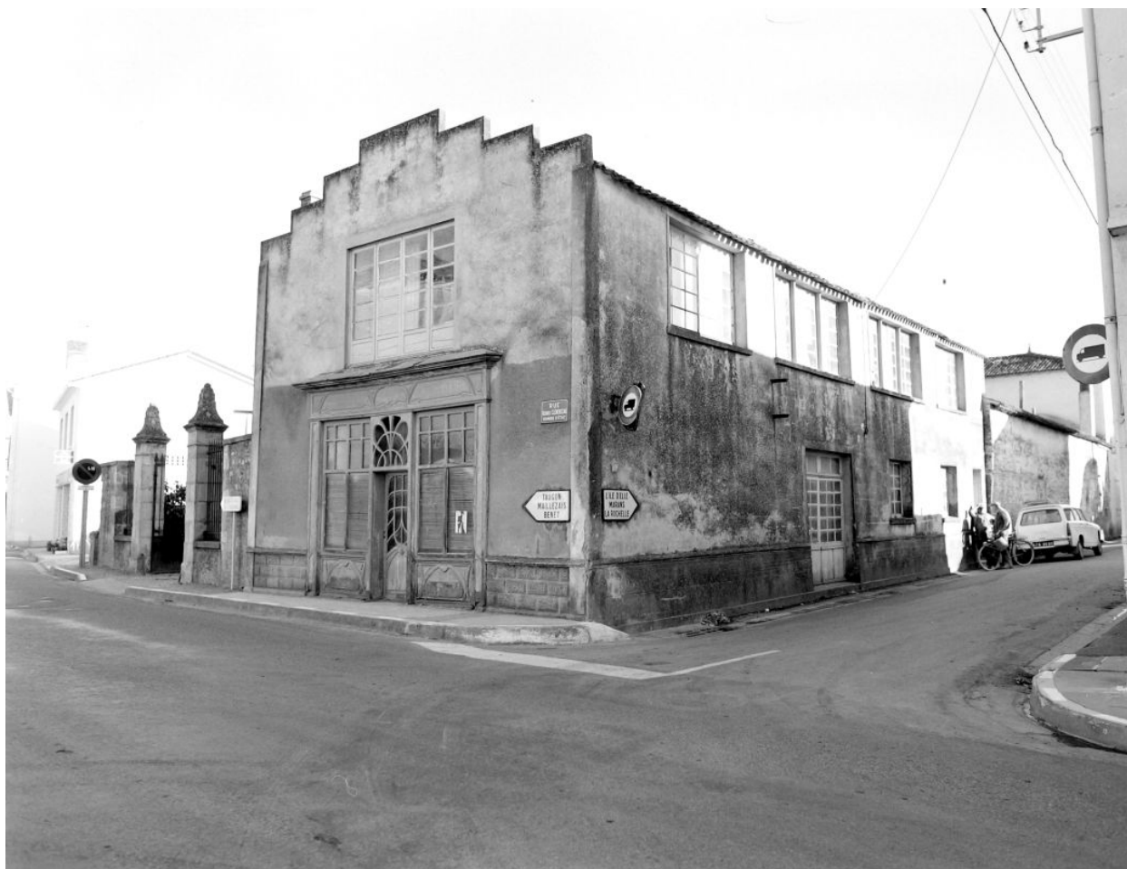
L'atelier de menuiserie-ébénisterie vu depuis le nord en 1974.
