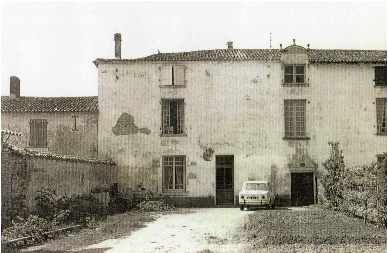
Le logis vu depuis le nord vers 1970.
