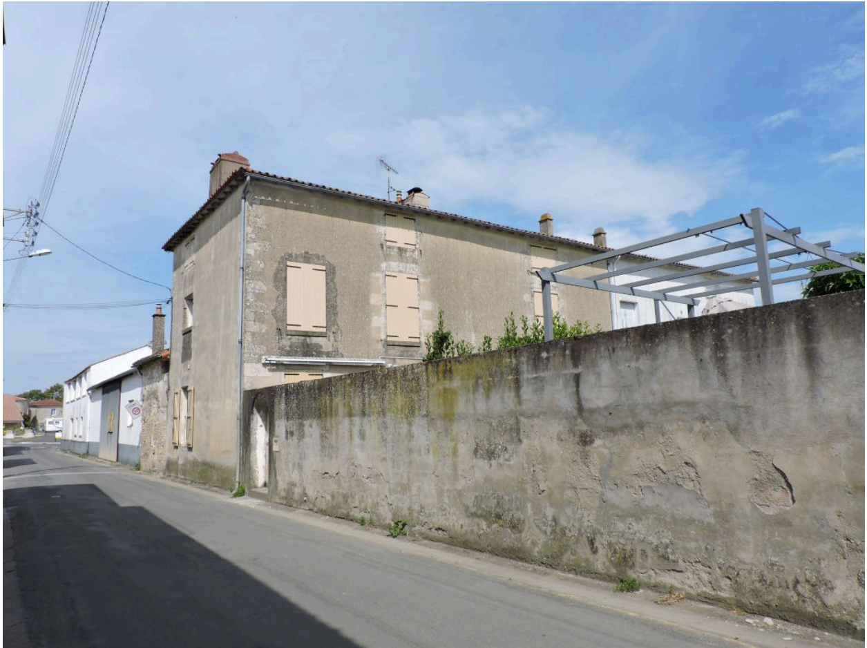
Le logis vu depuis le sud-ouest.
