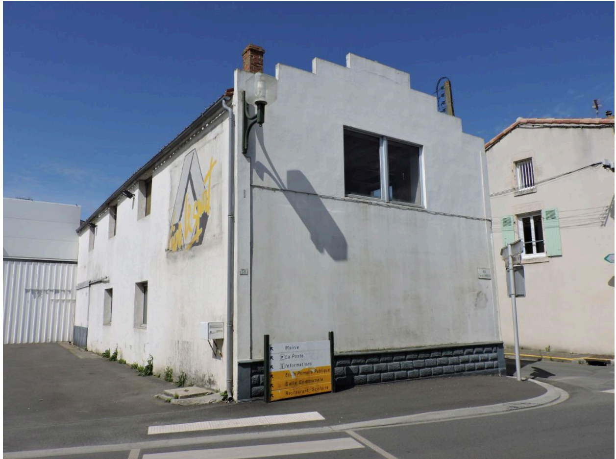
L'ancien atelier de menuiserie puis garage automobile, sur le côté ouest de la cour, vu depuis le nord-est.
