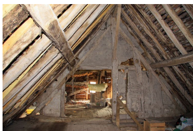
Le moulin, maison d'habitation, grenier : pignon en pan de bois et charpente à pannes. Phot. Jean-Baptiste Darrasse IVR52_20087201631NUCA
