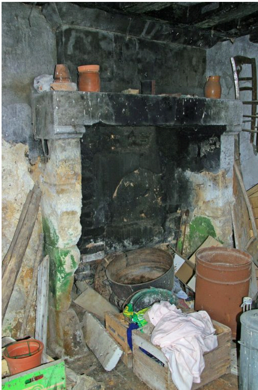
Le moulin, maison d'habitation : cheminée.
