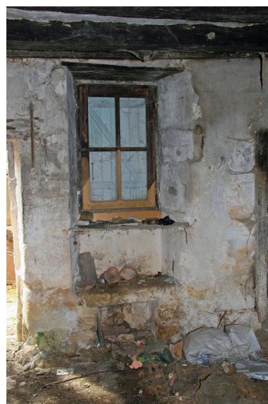
Le moulin, maison d'habitation : fenêtre de la salle. Phot. Jean-Baptiste Darrasse IVR52_20087201632NUCA
