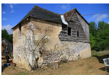
Le moulin, vue de volume : bief comblé, pignon en planches de la chambre des meules. Phot. Jean-Baptiste Darrasse IVR52_20087201625NUCA
