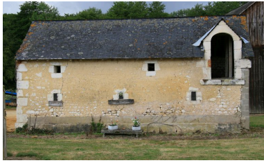
Les toits à porcs en partie démolis. Phot. Jean-Baptiste Darrasse IVR52_20087201636NUCA
