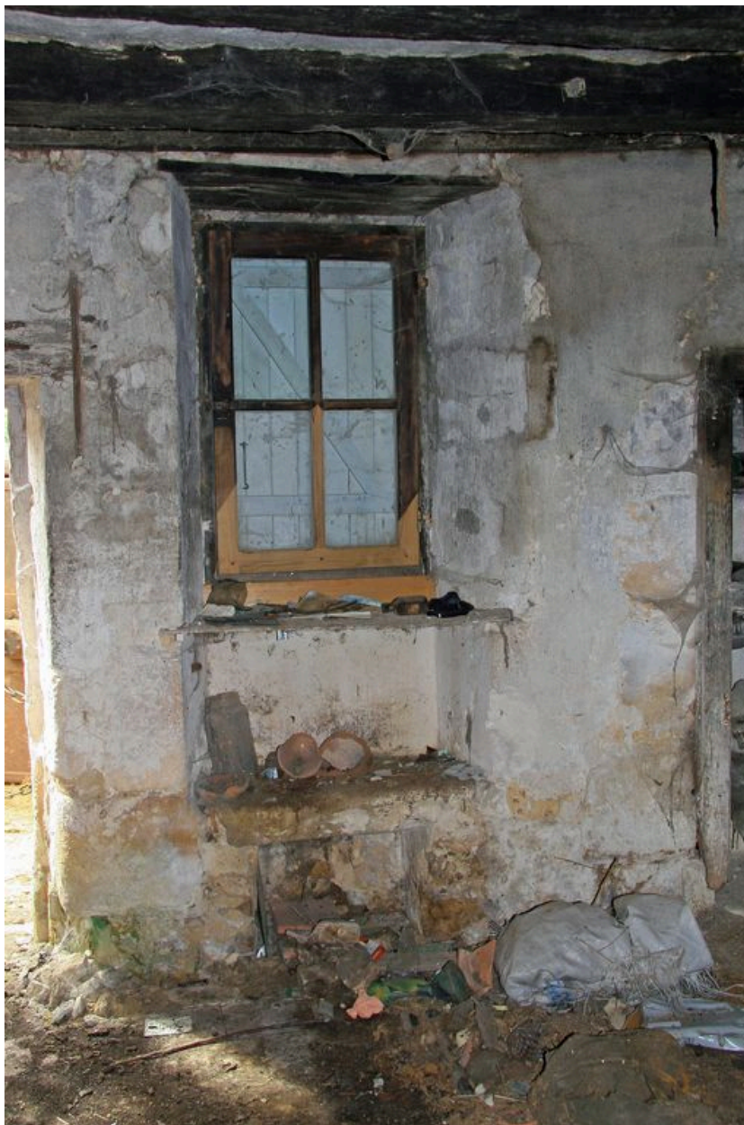
Le moulin, maison d'habitation : fenêtre de la salle.
