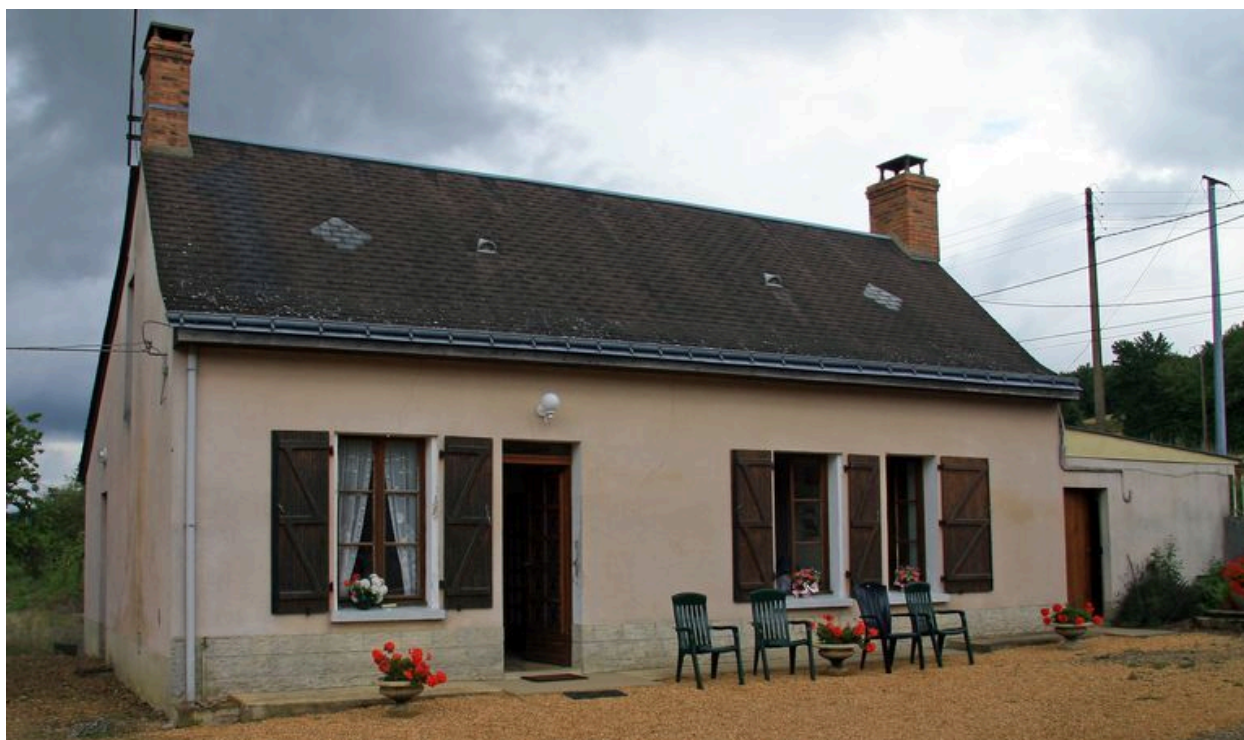
Les anciennes étables transformées en maison.
