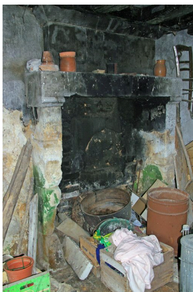
Le moulin, maison d'habitation : cheminée. Phot. Jean-Baptiste Darrasse IVR52_20087201634NUCA
