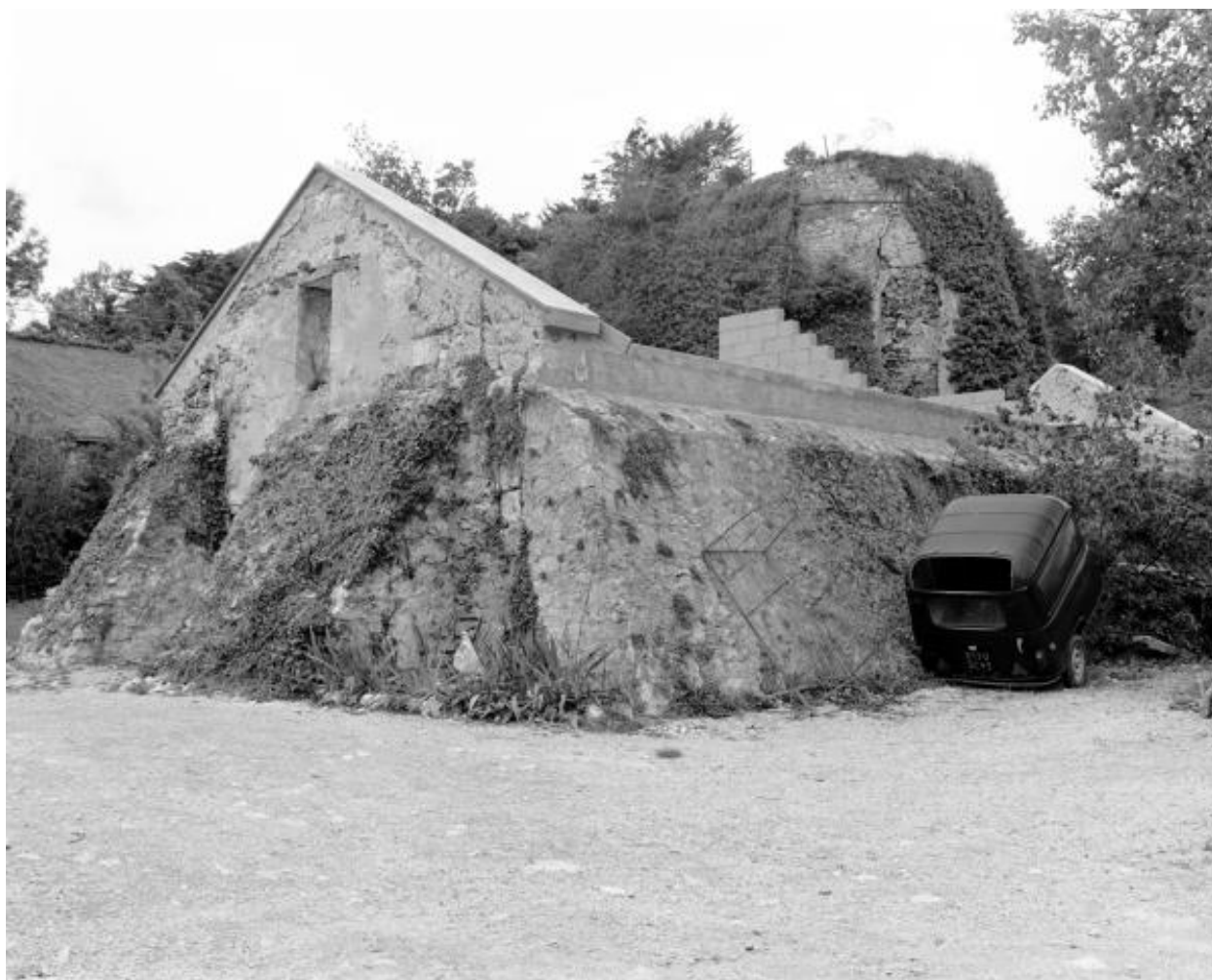
Magasin à chaux nord (parcelle 156), faces sud-est et nord-est, Maison-Blanche, Montjean-sur-Loire.
