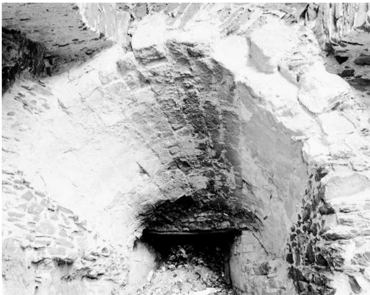
Ebraisoir (est) couvert d'une voûte en cannonière appareillée en panache, en tuffeau de taille, four à chaux de Maison-Blanche, Montjean-sur-Loire.
