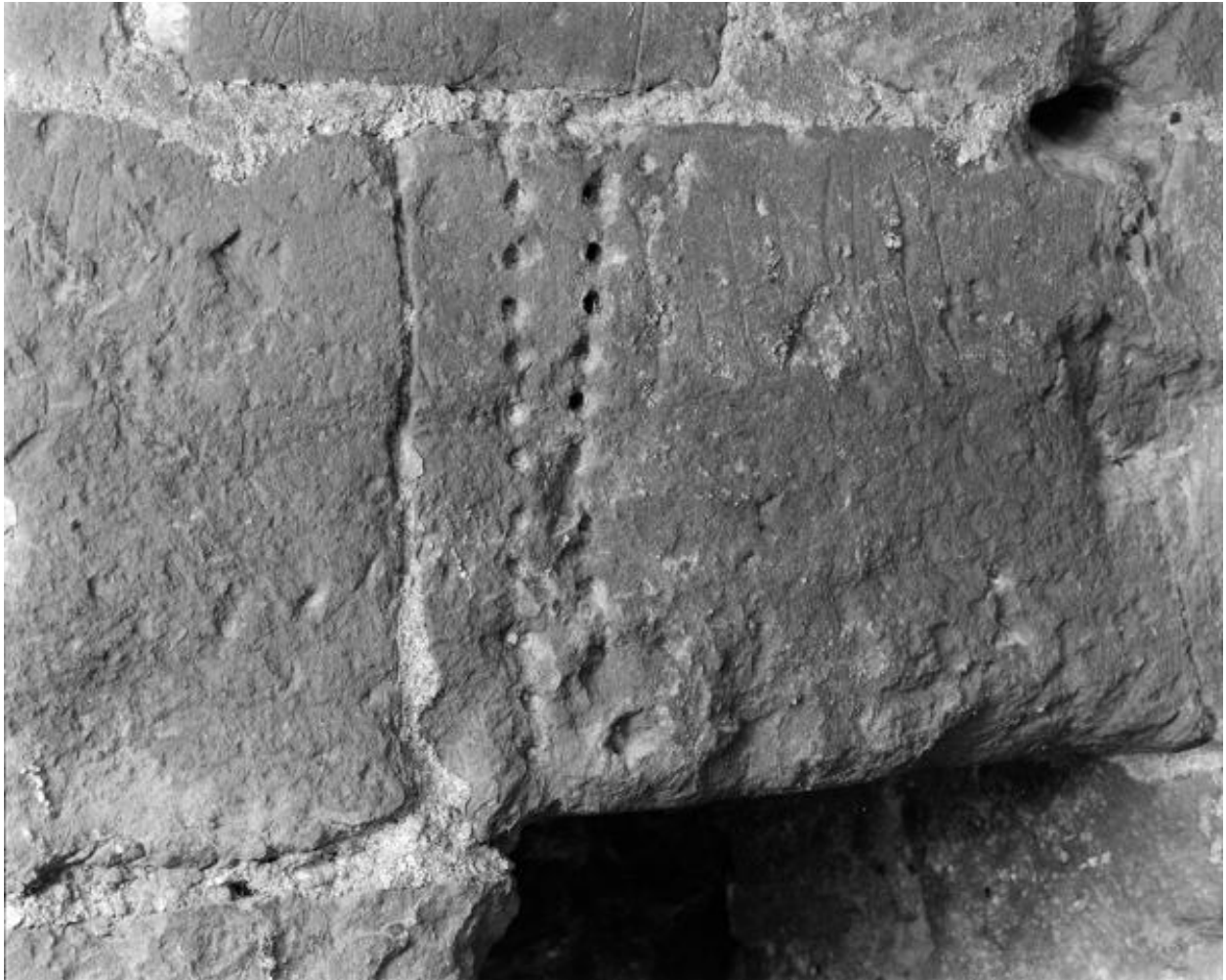
Ebraisoir ouest, paroi nord, compteur de déchargement, four à chaux, Maison-Blanche, Montjean-sur-Loire.
