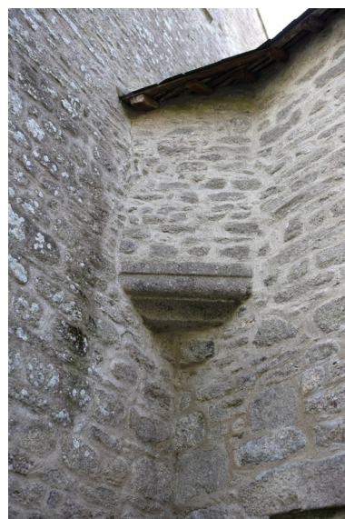
Logis. Angle nord-est. Passage en encorbellement entre la chambre et la garde-robe. Phot. Denis Pillet IVR52_20084402518NUCA
