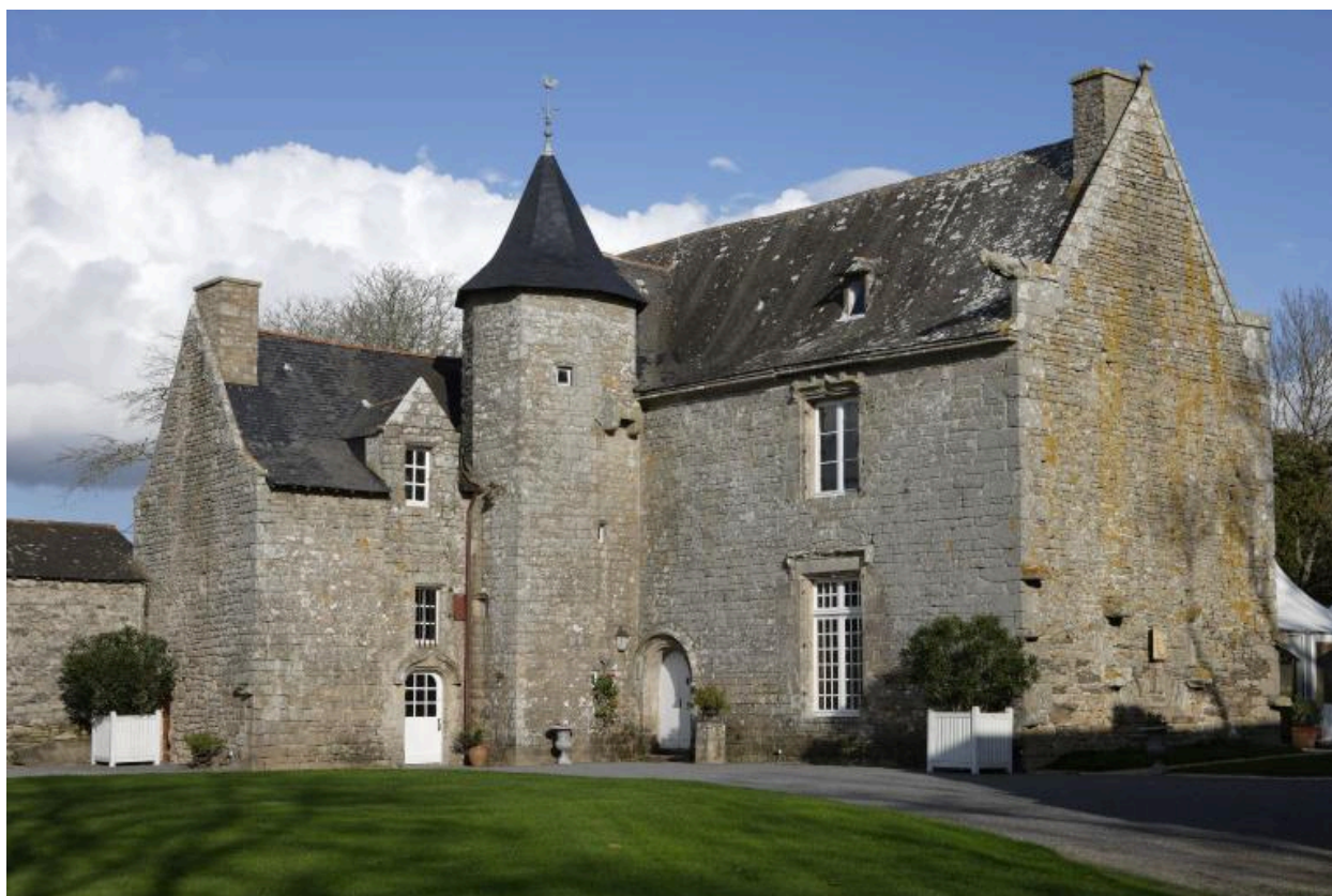
Logis. Vue d'ensemble depuis le sud-ouest.
