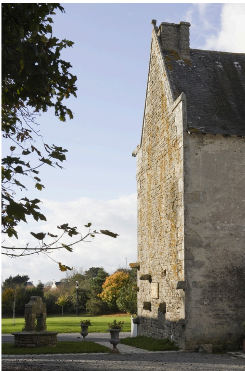
Logis. Aile est. Vue du pignon sud.
