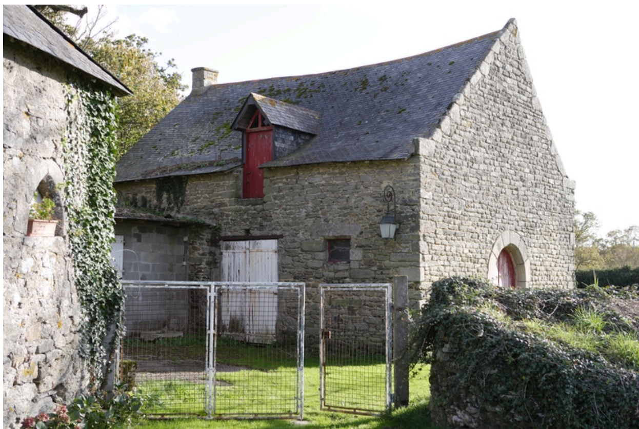
Vue des écuries.
