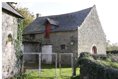
Vue des écuries. Phot. Denis Pillet IVR52_20084402503NUCA
