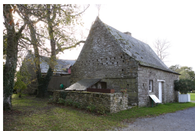
Charretterie. Vue depuis le nord-est. Phot. Denis Pillet IVR52_20084402491NUCA
