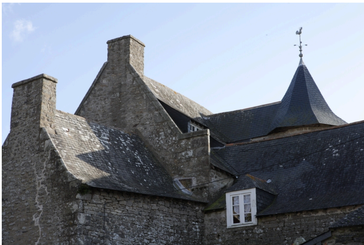
Logis. Détail des toitures depuis le nord.
