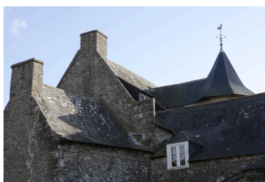
Logis. Détail des toitures depuis le nord. Phot. Denis Pillet IVR52_20084402520NUCA
