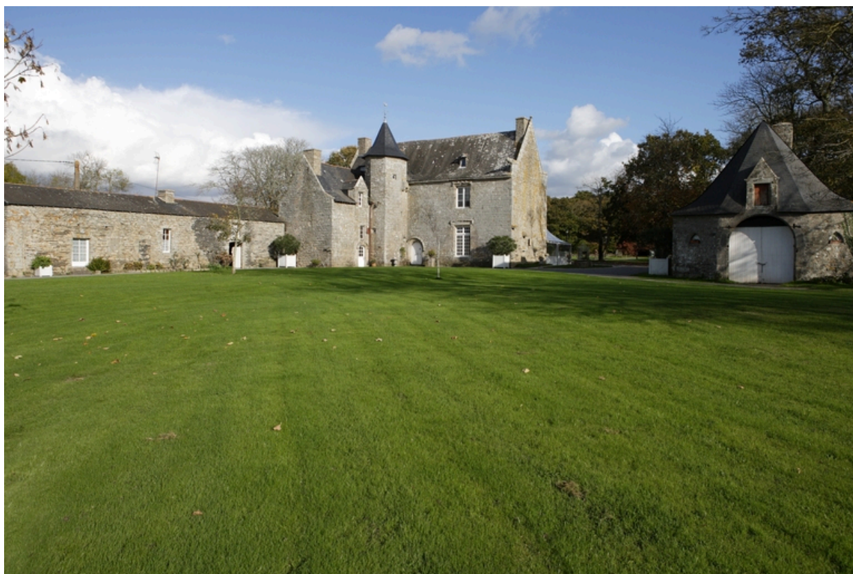
Logis. Vue d'ensemble depuis l'ouest.
