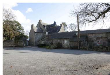
Logis. Vue d'ensemble depuis le nord-ouest. Phot. Denis Pillet IVR52_20084402526NUCA
