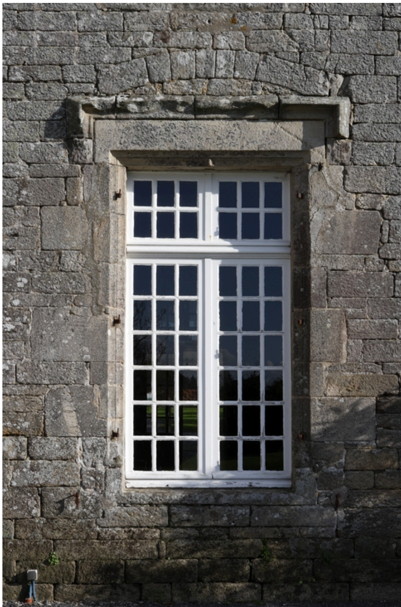
Logis. Aile est. Rez-de-chaussée. Façade ouest. Croisée.
