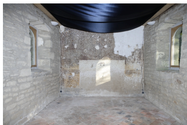
Chapelle. Vue du chœur. Phot. Denis Pillet IVR52_20084402533NUCA
