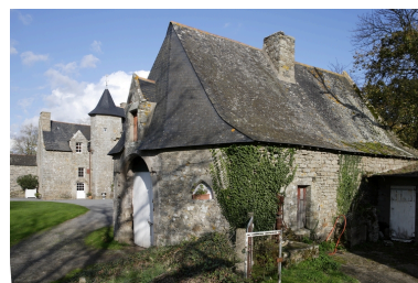
Charretterie. Vue depuis le sud-ouest. Phot. Denis Pillet IVR52_20084402510NUCA
