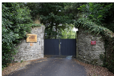
Mur de clôture. Vue du portail d'entrée. Phot. Denis Pillet IVR52_20094400702NUCA
