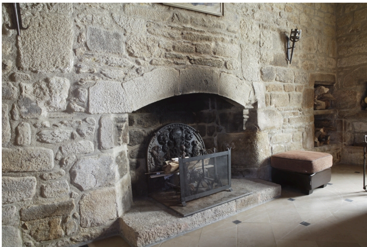
Logis. Aile est. Cuisine. Vue de la cheminée.
