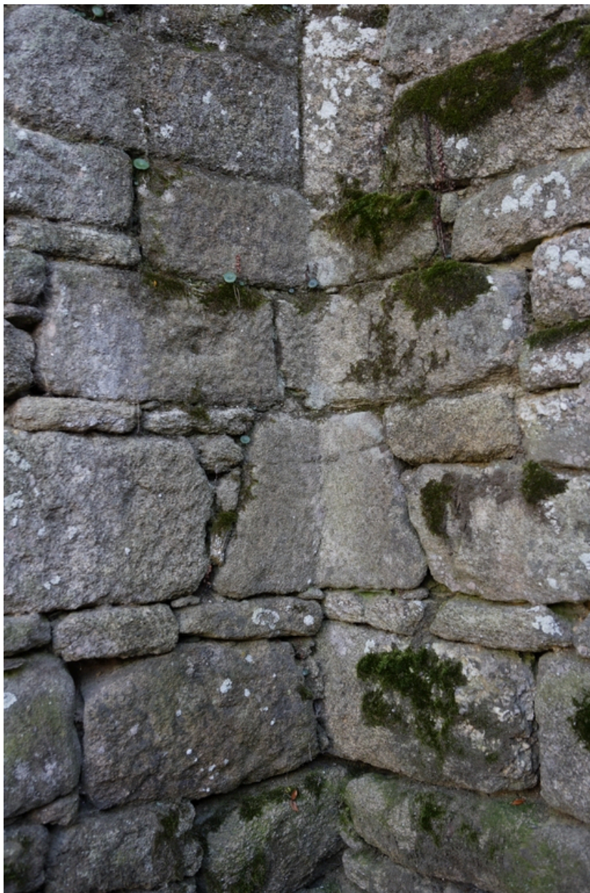
Logis. Détail de la liaison entre l'aile nord et l'aile est.
