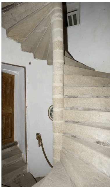
Logis. Tour d'escalier. Détail de la vis. Phot. Denis Pillet IVR52_20094400721NUCA
