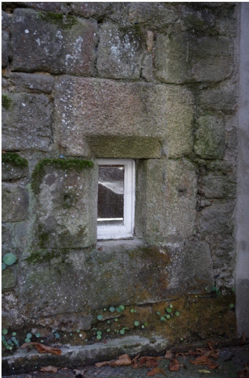
Logis. Cellier. Détail du soupirail.
