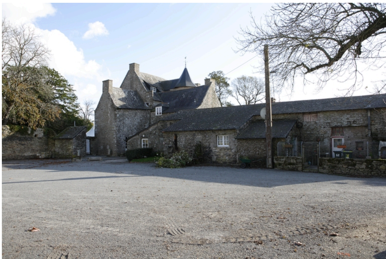
Logis. Vue d'ensemble depuis le nord-ouest.
