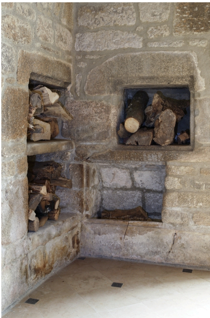
Logis. Aile est. Cuisine. Détail des niches murales.
