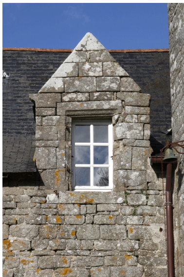
Logis. Aile nord. Lucarne. Phot. Denis Pillet IVR52_20084402495NUCA
