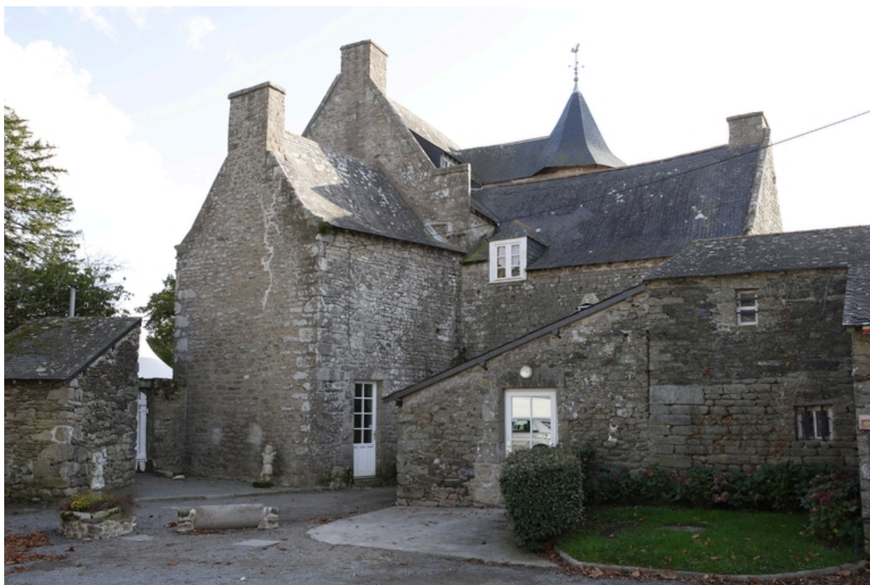
Logis. Vue depuis le nord-est.
