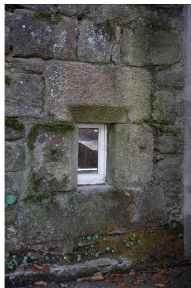
Logis. Cellier. Détail du soudirail. Phot. Denis Pillet IVR52_20084402523NUCA
