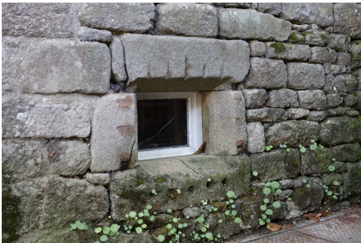
Logis. Cave. Détail du soupirail.
