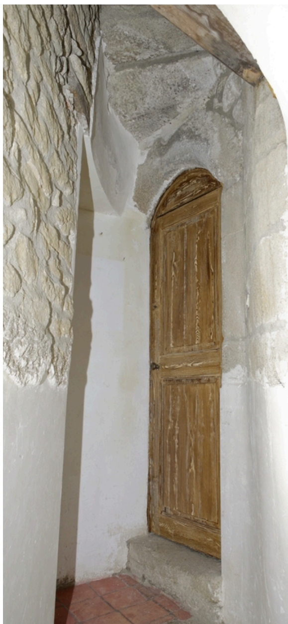
Logis. Aile nord. 1er étage. Détail des vestiges de la vis secondaire.
