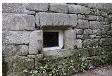
Logis. Cave. Détail du sopirail. Phot. Denis Pillet IVR52_20084402522NUCA
