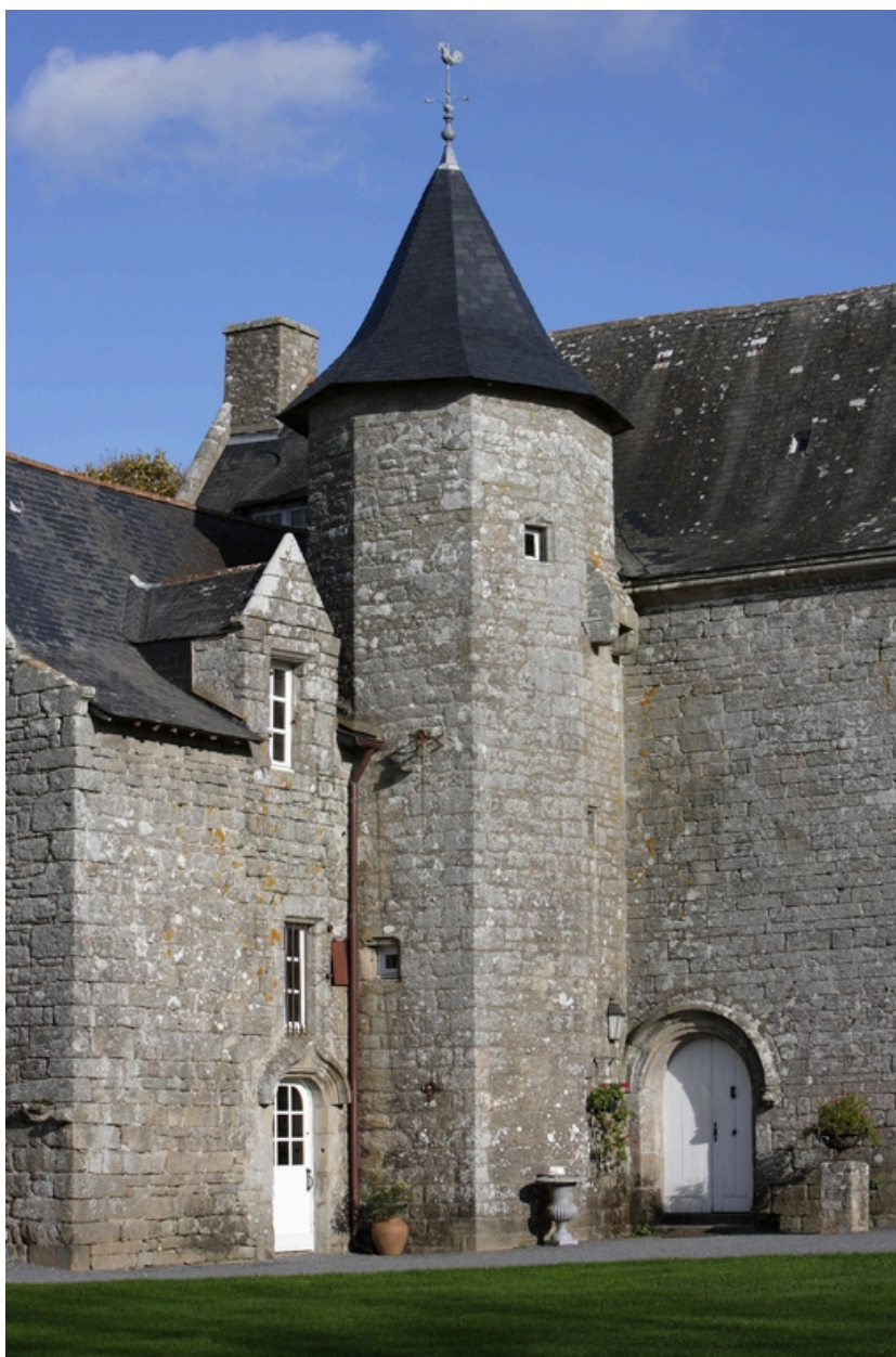
Logis. Détail de la tour d'escalier.
