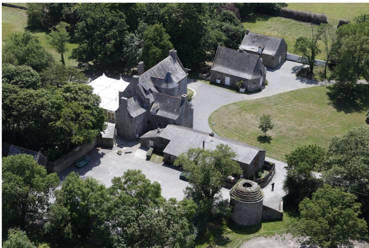
Vue aérienne depuis le nord-est.
