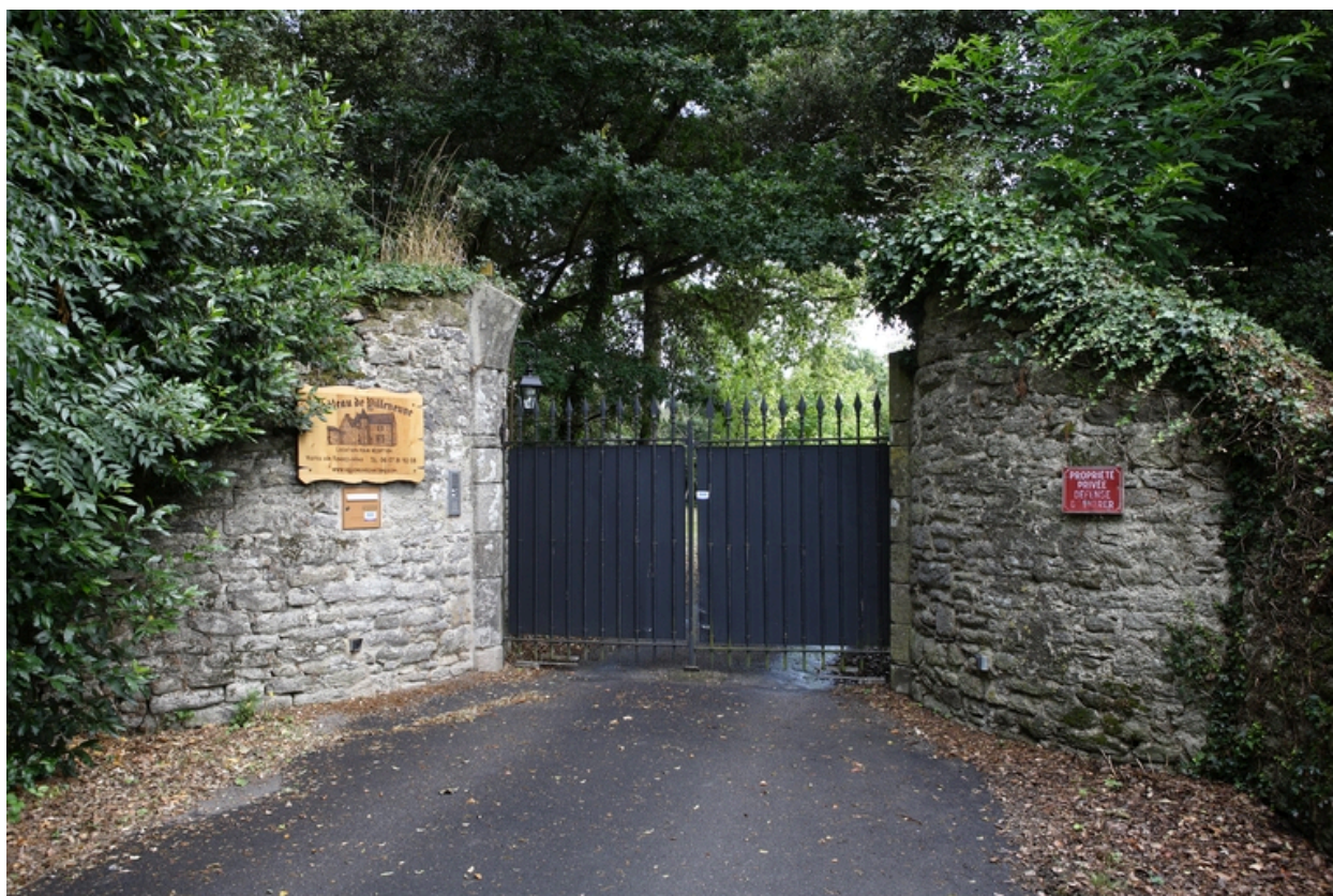
Mur de clôture. Vue du portail d'entrée.
