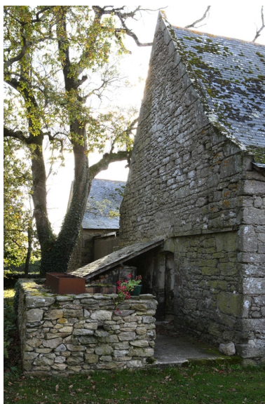
Charretterie. Détail du pignon. Phot. Denis Pillet IVR52_20084402490NUCA
