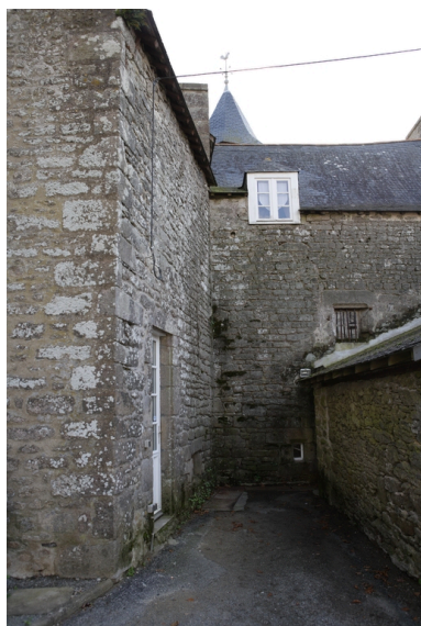
Logis. Détail de l'angle nord-est. Phot. Denis Pillet IVR52_20084402521NUCA
