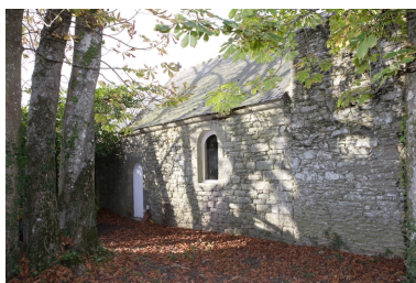
Chapelle. Vue depuis le sud. Phot. Denis Pillet IVR52_20084402537NUCA
