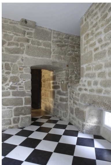
Logis. Aile est. Vue de la porte du cellier et départ de la vis secondaire. Phot. Denis Pillet IVR52_20094400715NUCA
