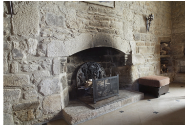
Logis. Aile est. Cuisine. Vue de la cheminée. Phot. Denis Pillet IVR52_20094400712NUCA
