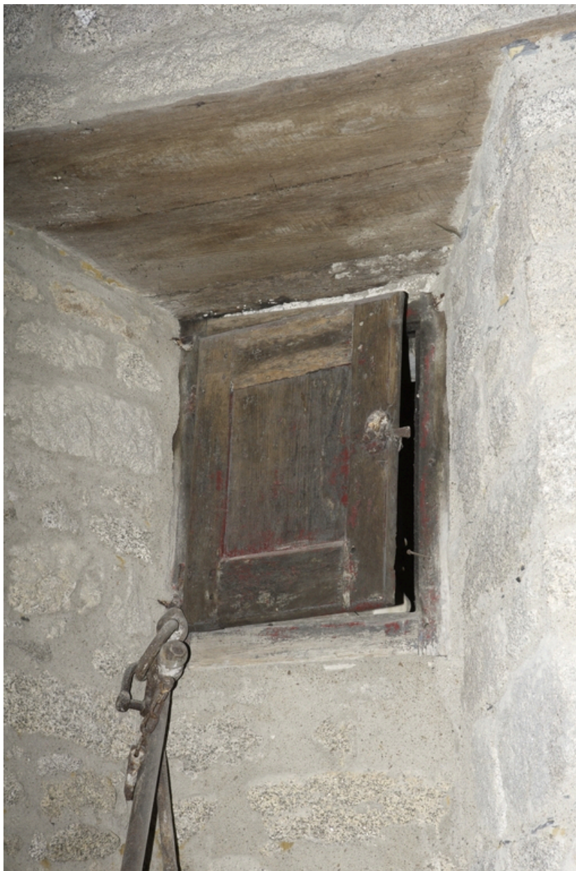
Logis. Aile nord. Rez-de-chaussée surélevé. Détail du judas.
