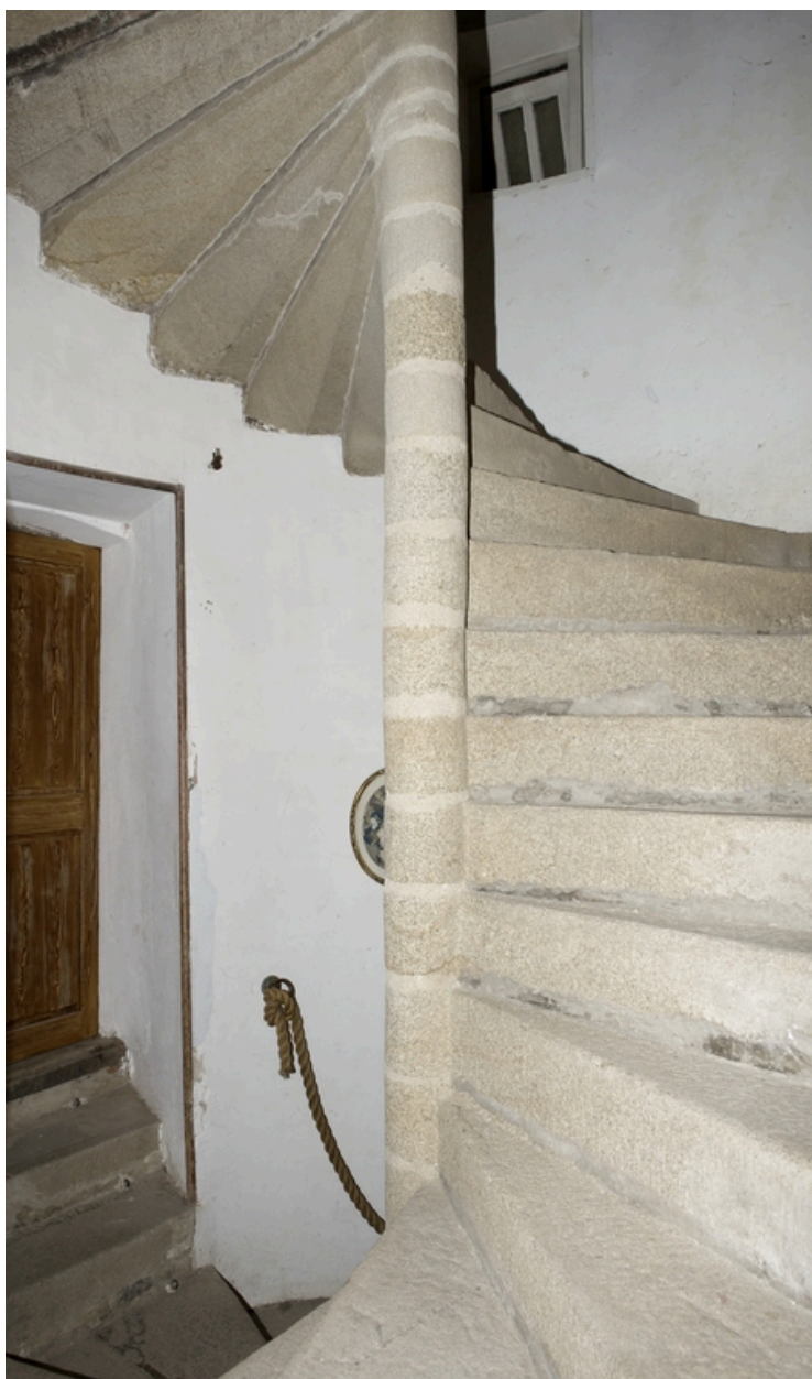
Logis. Tour d'escalier. Détail de la vis.
