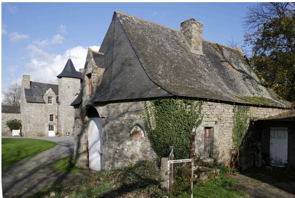
Charreterie. Vue depuis le sud-ouest.
