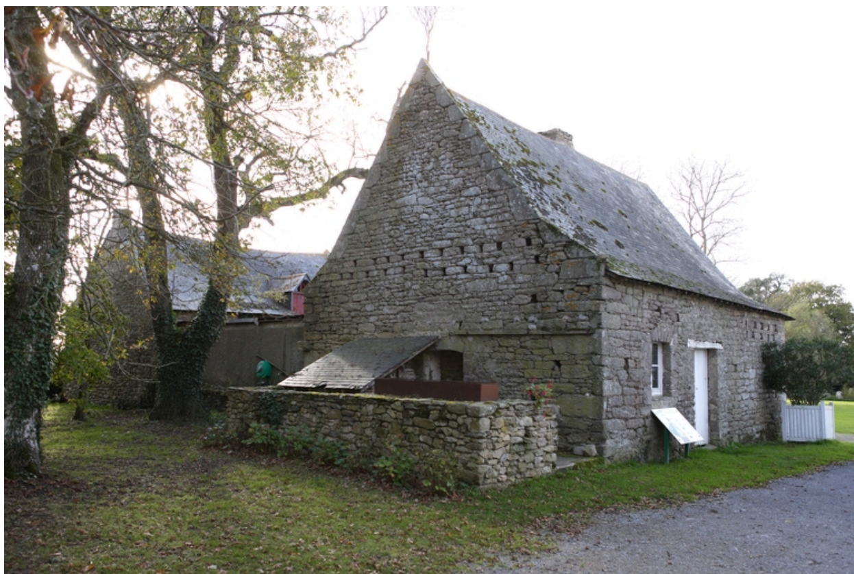
Charretterie. Vue depuis le nord-est.
