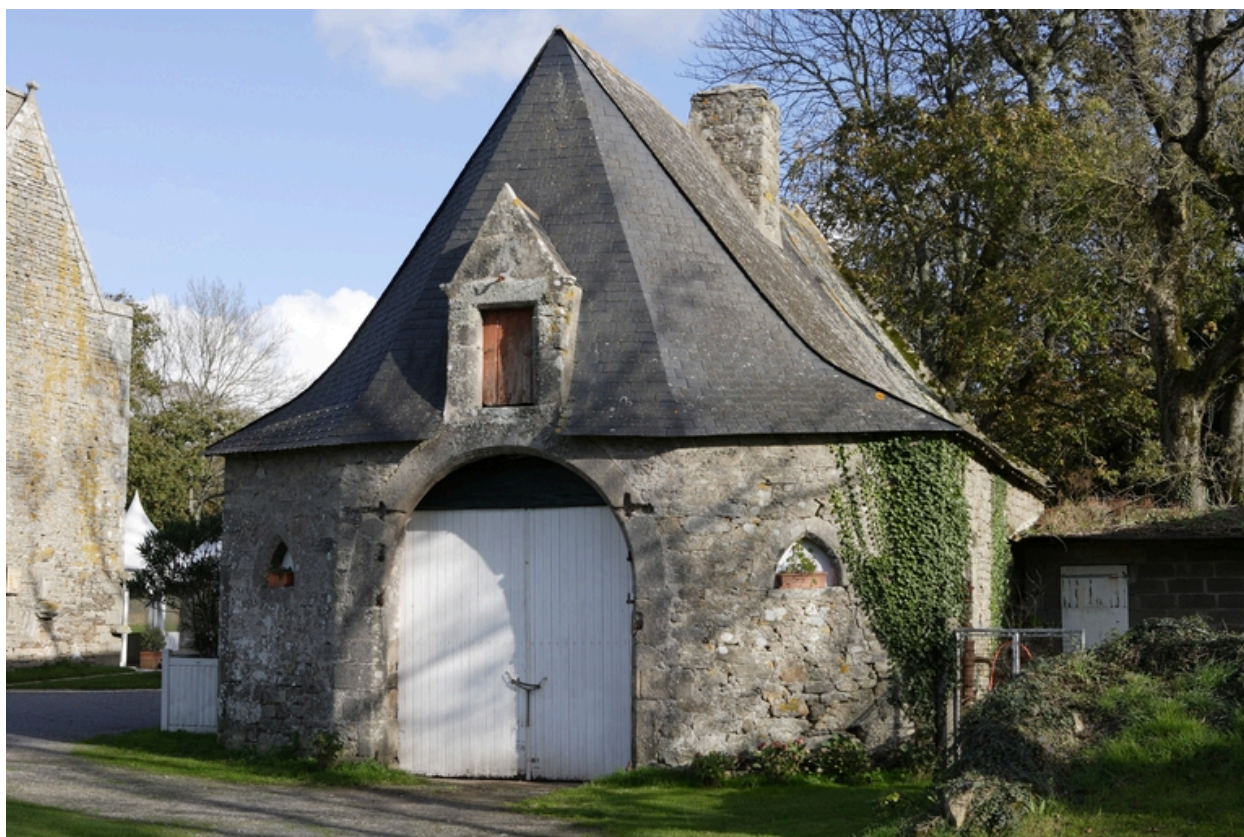
Vue de la charetterie.
