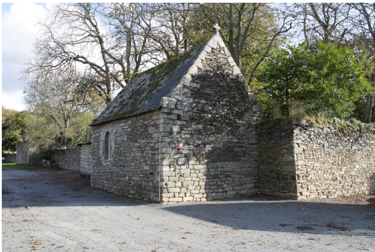
Chapelle. Vue depuis l'ouest.
