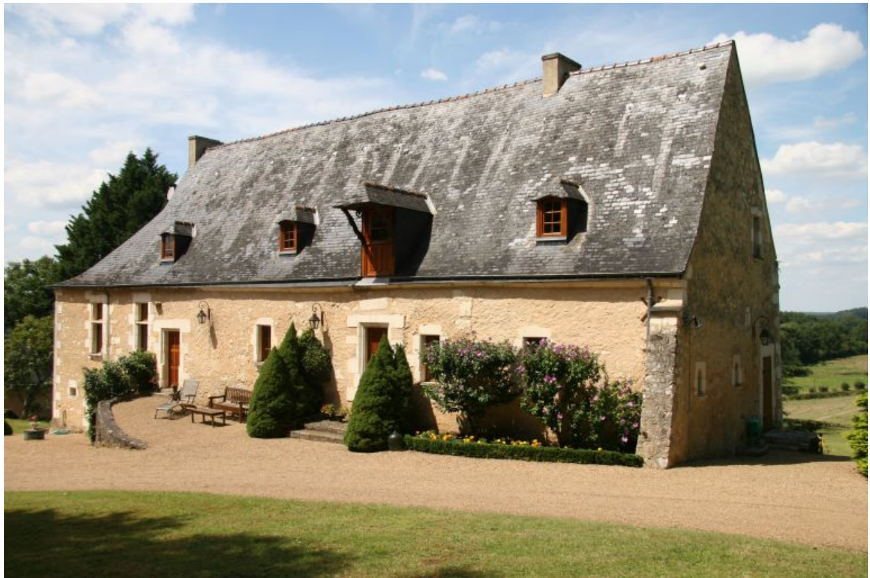
Vue de volume prise du sud-est : logis en rez-de-chaussée.
