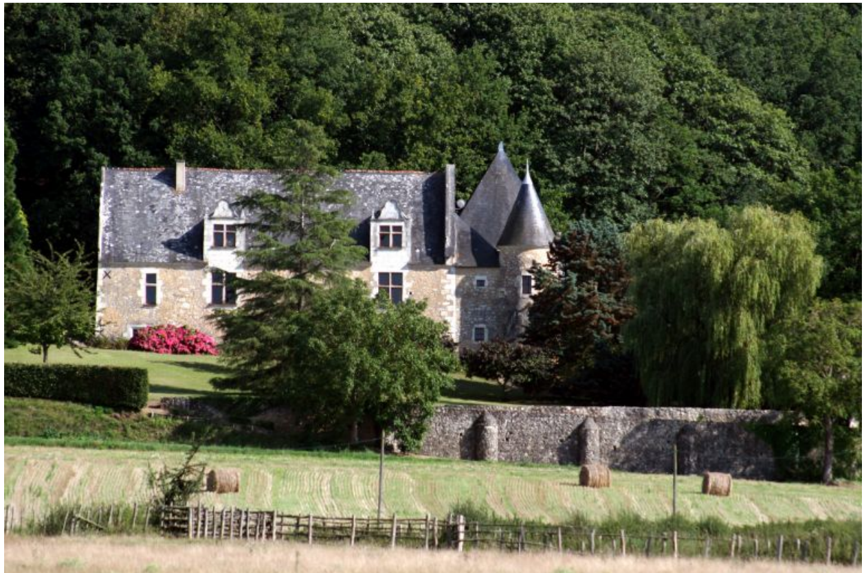
Façade sur la vallée du Loir.
