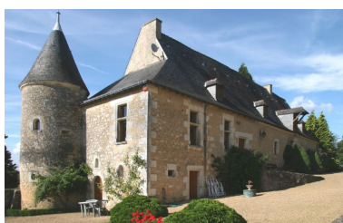
Vue de volume prise du sud-ouest. Phot. Jean-Baptiste Darrasse IVR52_20077200959NUCA
