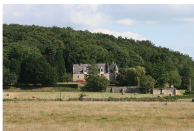
Vue d'ensemble : château à mi pente au pied d'un bois. Phot. Jean-Baptiste Darrasse IVR52_20077200955NUCA
