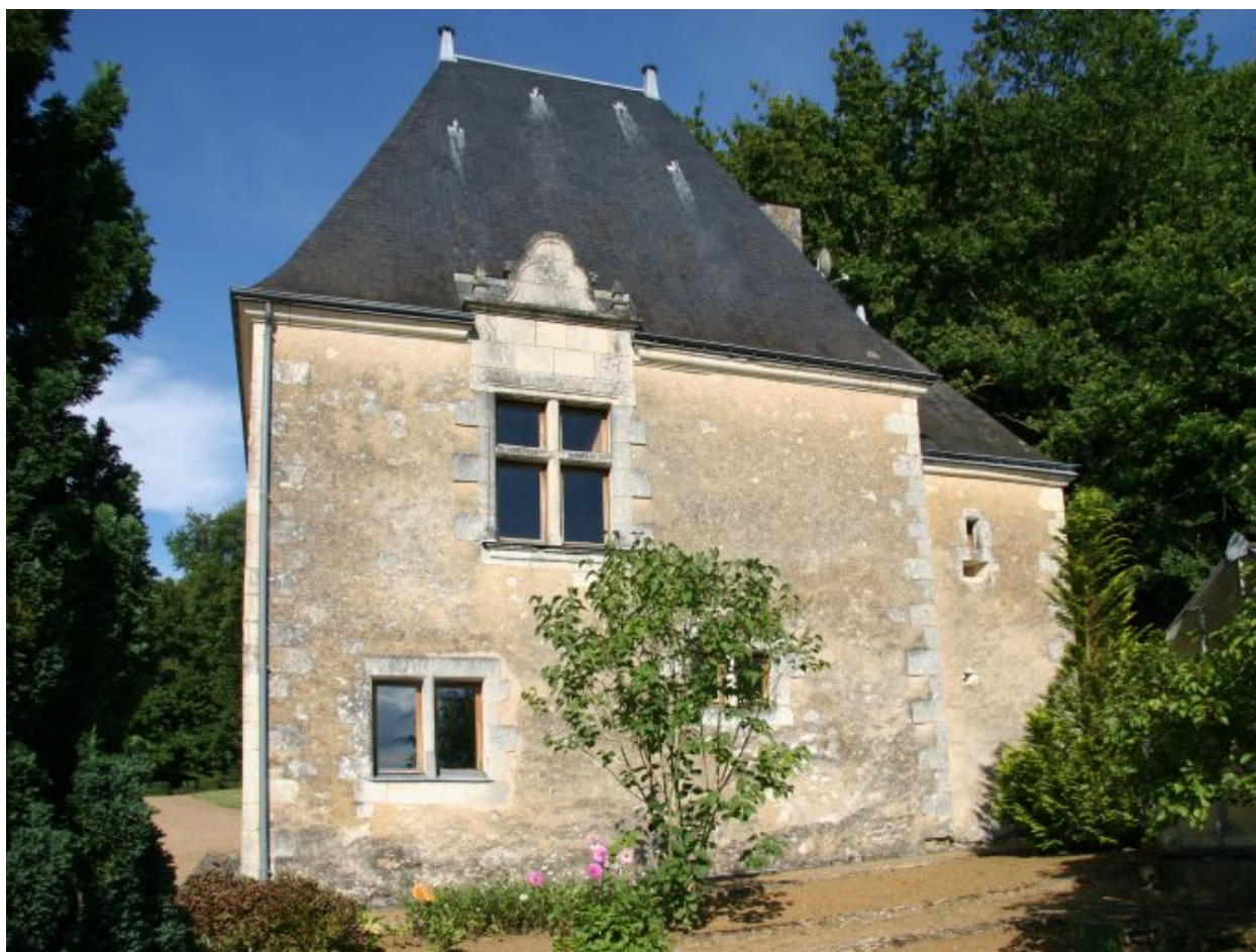
Le pavillon : façade postérieure.
