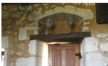
Demi-baie de la salle est remaniée : face interne. Phot. Jean-Baptiste Darrasse IVR52_20077200970NUCA
