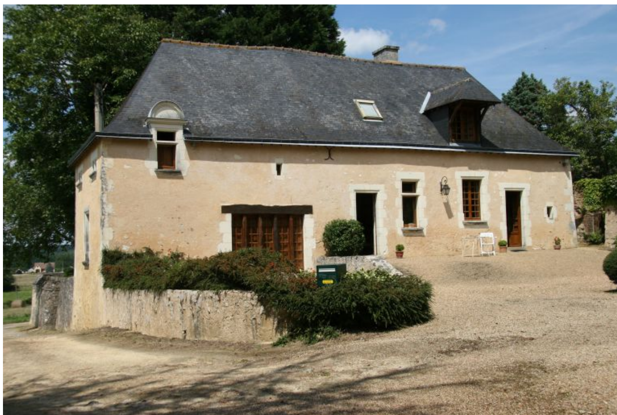
La ferme transformée en résidence.
