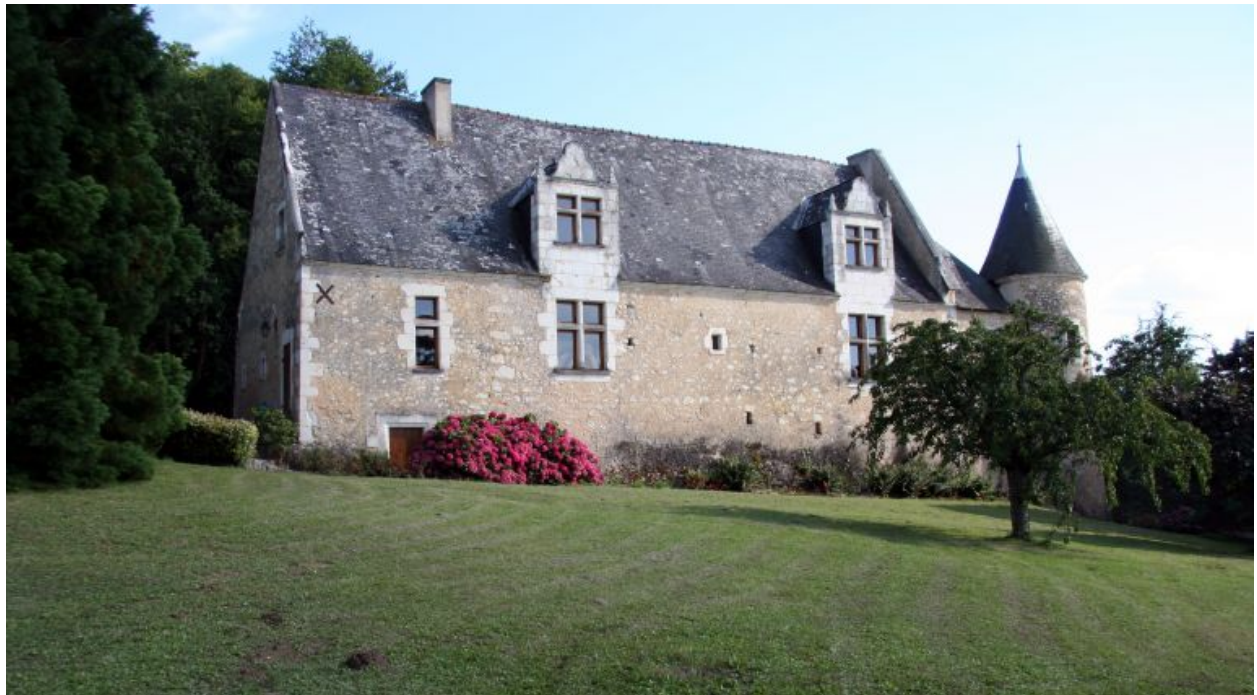
Le logis : façade postérieure sur la vallée.
