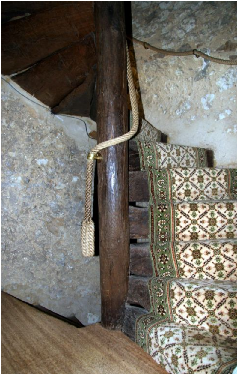
Escalier en vis en bois desservant trois niveaux.
