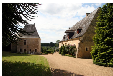
Vue d'ensemble sur la cour. Phot. Jean-Baptiste Darrasse IVR52_20077201020NUCA
