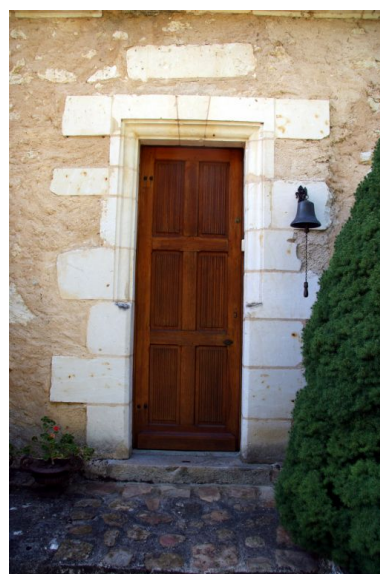
Porte d'entrée de la salle est : ancienne demie baie agrandie et transformée. Phot. Jean-Baptiste Darrasse IVR52_20077200973NUCA
