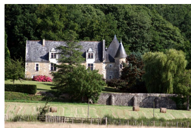
Façade sur la vallée du Loir. Phot. Jean-Baptiste Darrasse IVR52_20077200956NUCA
