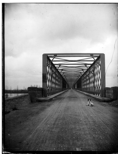
Vue de l'entrée du pont depuis la rive droite par Aristide Drouin, vers 1905. IVR52_20204400597NUCA
