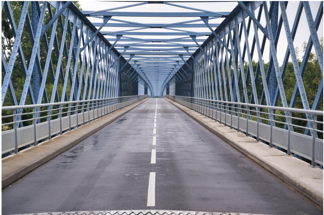
Cage et tablier du Grand Pont de Thouaré (1/2).
