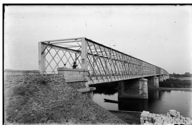
Vue du pont depuis la rive droite, par Adolphe Moitié, vers 1890. IVR52_20204400596NUCA
