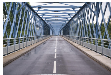
Cage et tablier du Grand Pont de Thouaré (1/2). Phot. Patrick Jean IVR52_20214400504NUCA
