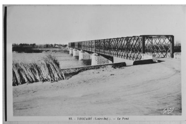
Vue d'ensemble depuis la rive droite. Repro. Patrice Giraud IVR52_19754401170X
