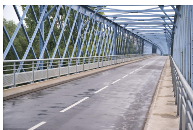
Cage et tablier du Grand Pont de Thouaré (2/2). Phot. Patrick Jean IVR52_20214400505NUCA
