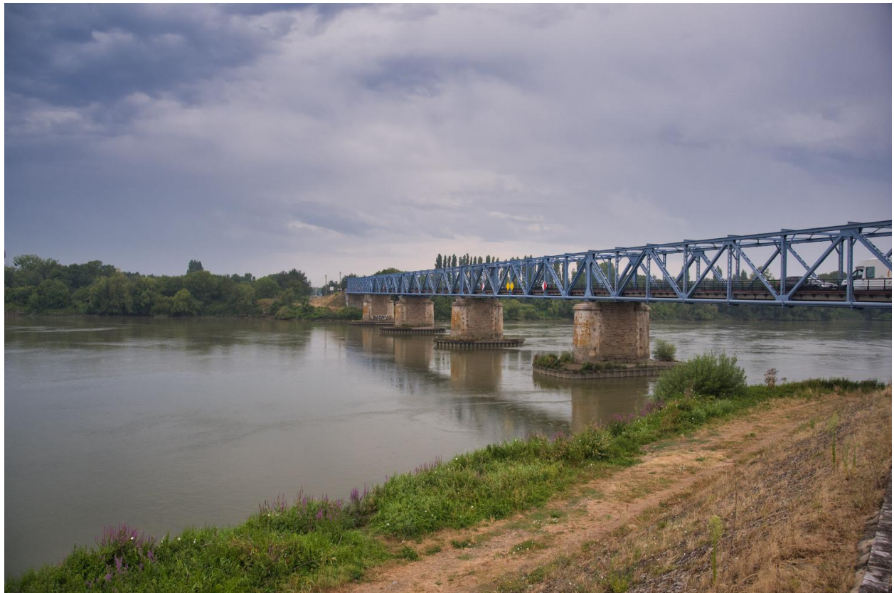
Pont du Haut Village.
