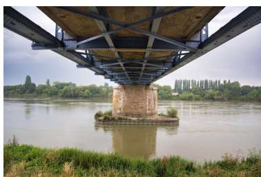
Charpente métallique soutenant le tablier du pont du Haut Village. Phot. Patrick Jean IVR52_20214400509NUCA
