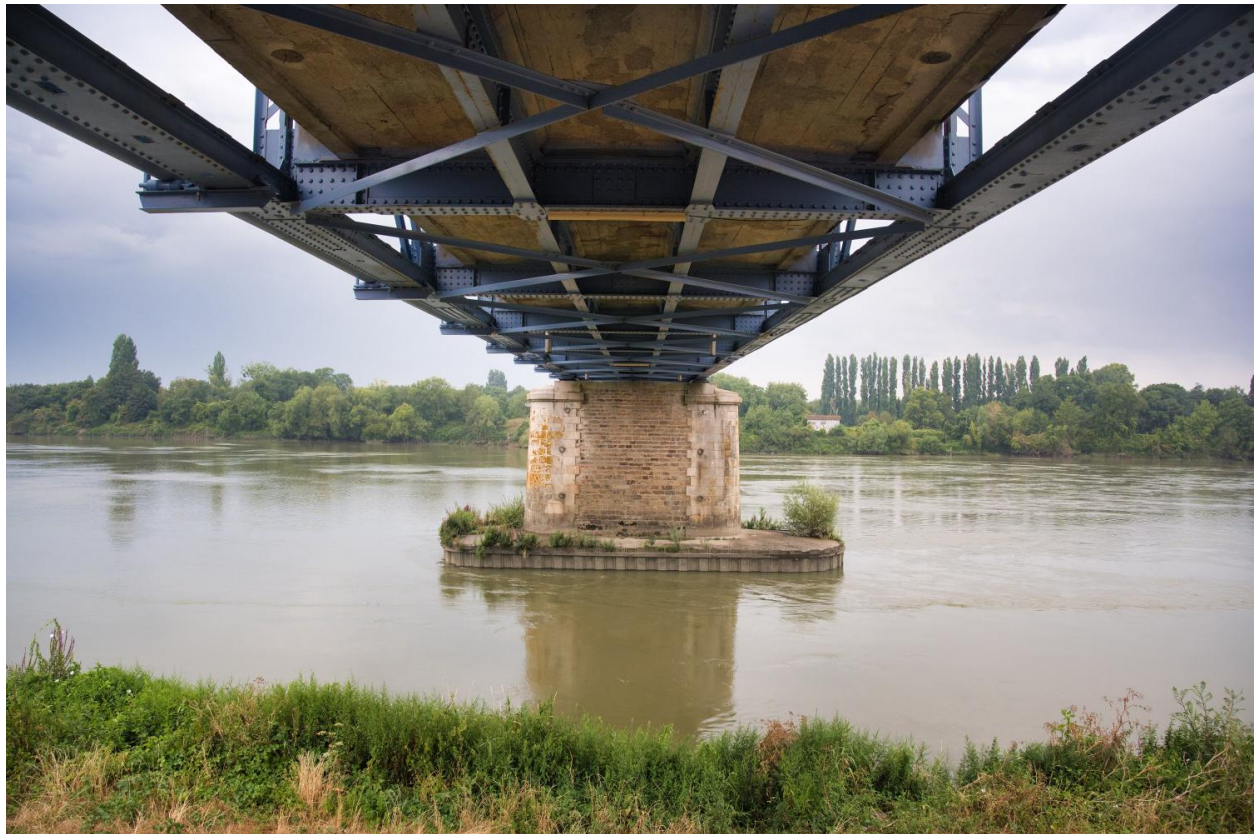
Charpente métallique soutenant le tablier du pont du Haut Village.
