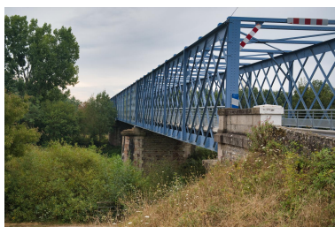
Entrée du pont depuis la rive nord. Phot. Patrick Jean IVR52_20214400503NUCA
