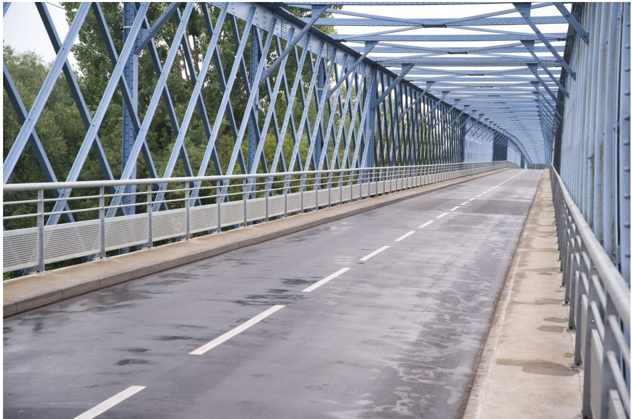
Cage et tablier du Grand Pont de Thouaré (2/2).
