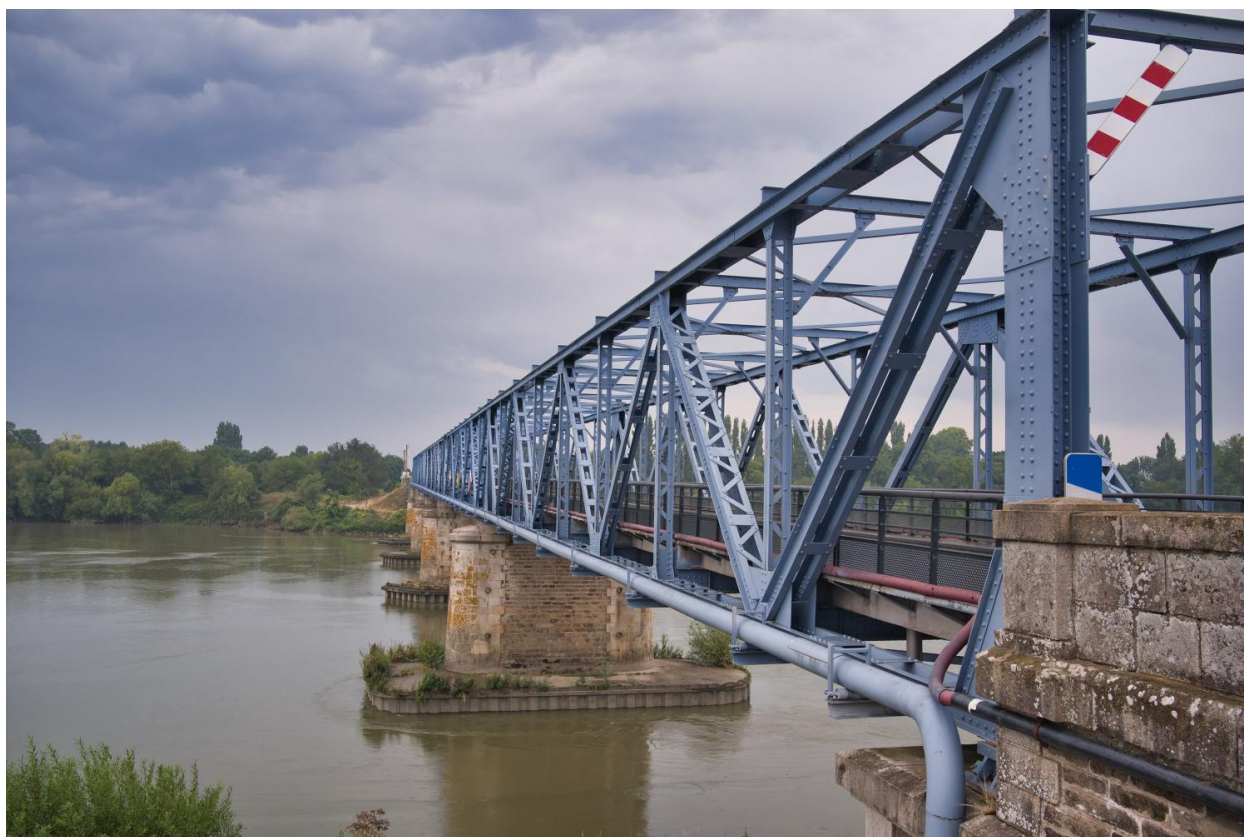
Le pont du Haut Village en rive sud.
