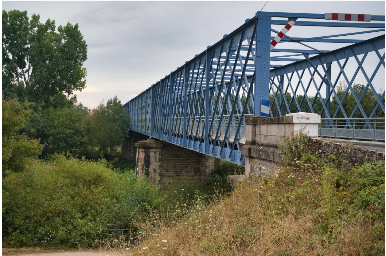
Entrée du pont depuis la rive nord.
