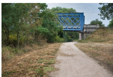
Le Grand Pont de Thouaré enjambant le chemin de halage en rive nord. Phot. Patrick Jean IVR52_20214400506NUCA
