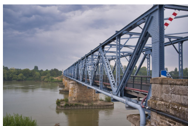
Le pont du Haut Village en rive sud. Phot. Patrick Jean IVR52_20214400508NUCA
